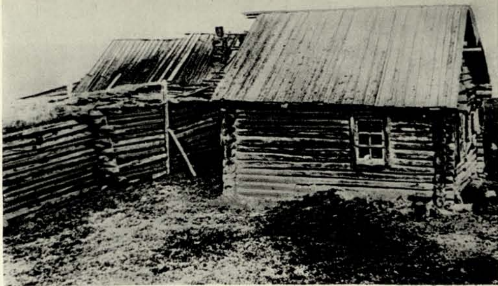
Дом в поселке Курейка, Туруханского края, в котором с начала 1914 года по декабрь 1916 года жил Сталин во время своей последней ссылки.
