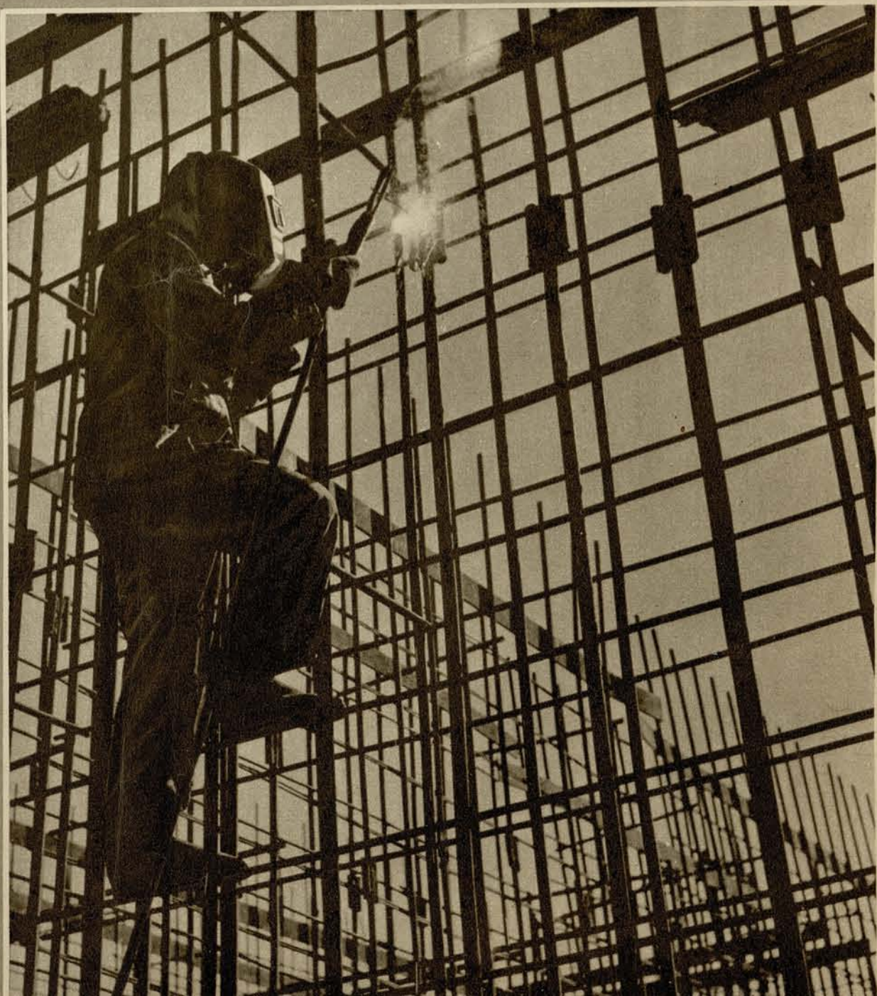
На нижнем снимке — электросварка арматуры фундаментов нового здания университета.
