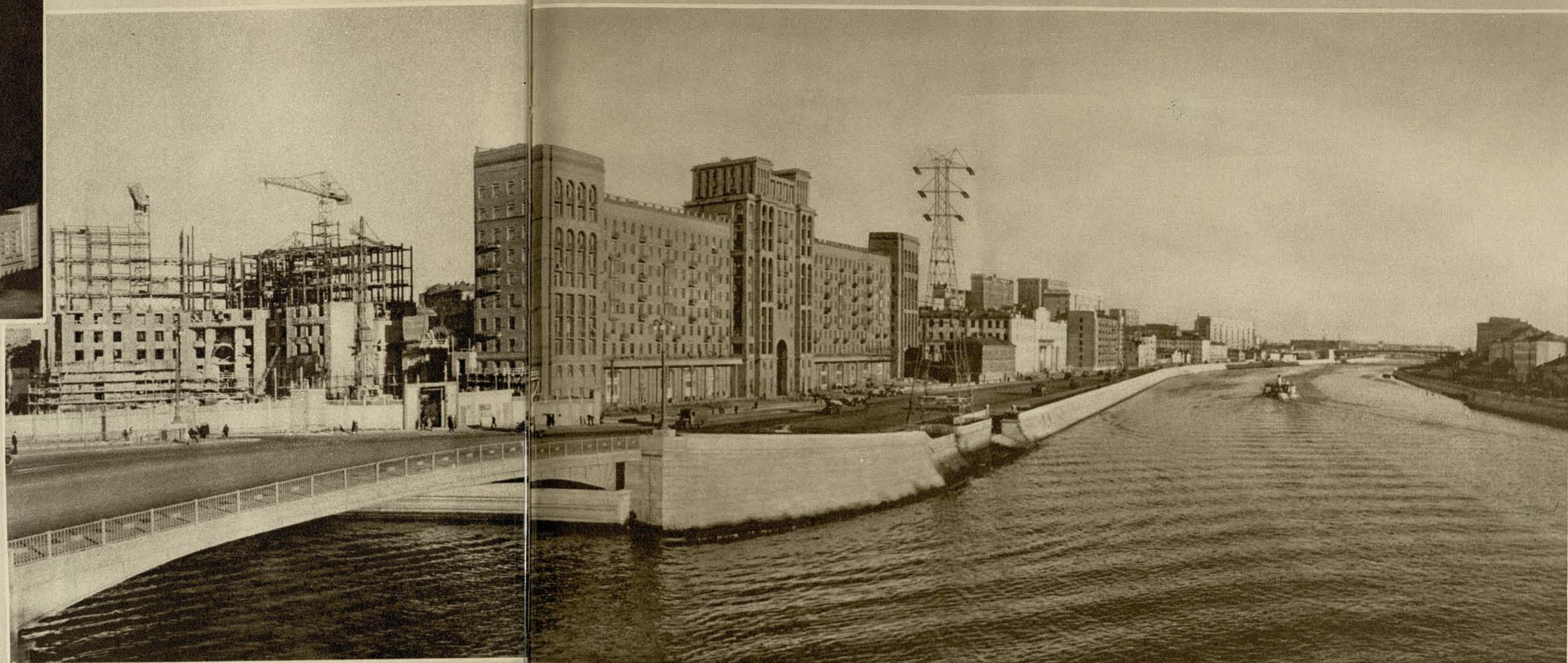
Высотное здание на Котельнической набережной своим фасадом будет выходить на Москву-реку и на реку Яузу. Крыльями высотной части здания должны служить недавно построенный дом на Котельнической набережной Москвы-реки и такой же дом, проектируемый на Подгорской набережной реки Яузы. На снимке — вид на строительство высотного дома со стороны Москвы-реки. Здание, находящееся справа от строительной площадки, соответствует правому крылу архитектурного ансамбля на макете.
