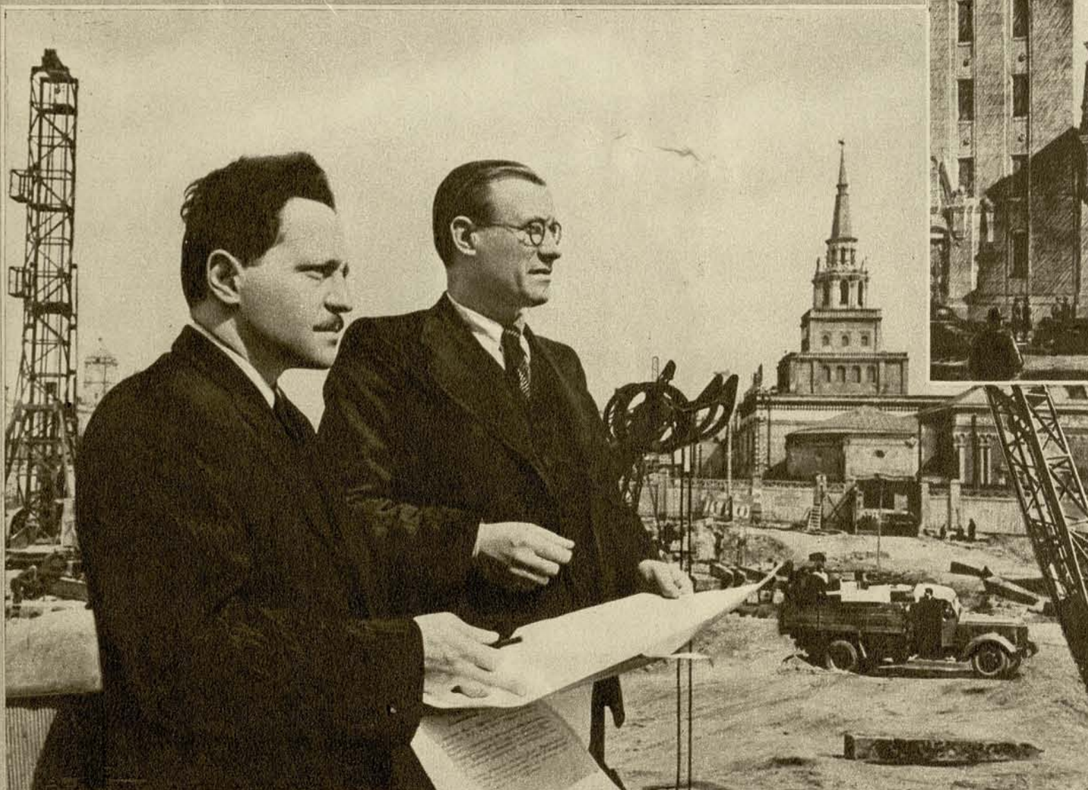
На снимке слева — авторы проекта здания гостиницы, лауреаты Сталинской премии архитекторы Л. Поляков (справа) и А. Борейский на строительной площадке.
