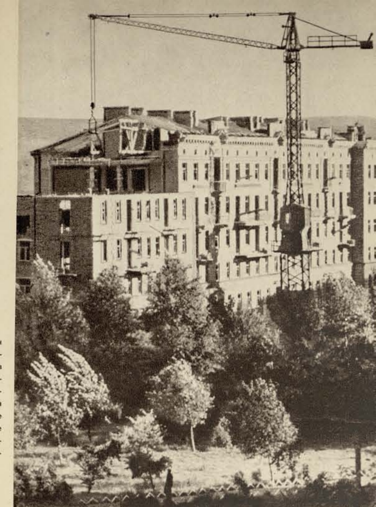
Свыше двух тысяч квартир получают жители Сталинска в 1949 году. На снимке справа: строительство жилого дома на 140 квартир на улице Кирова. На снимке внизу: вновь строящаяся часть проспекта Мологова.
