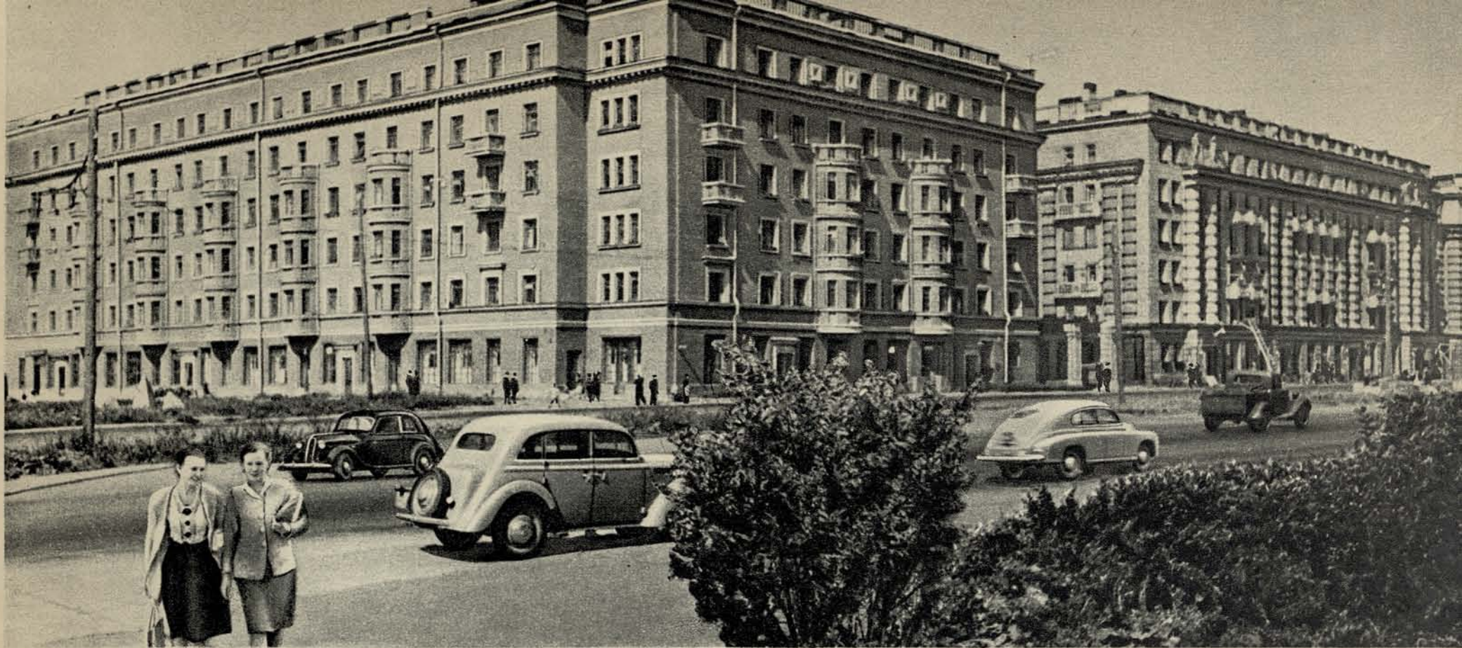
В Ленинграде, тяжело пострадавшем от немецкой блокады, наряду с восстановлением разрушенных зданий ведется большое новое строительство. На снимке — жилые дома на Московском шоссе.
