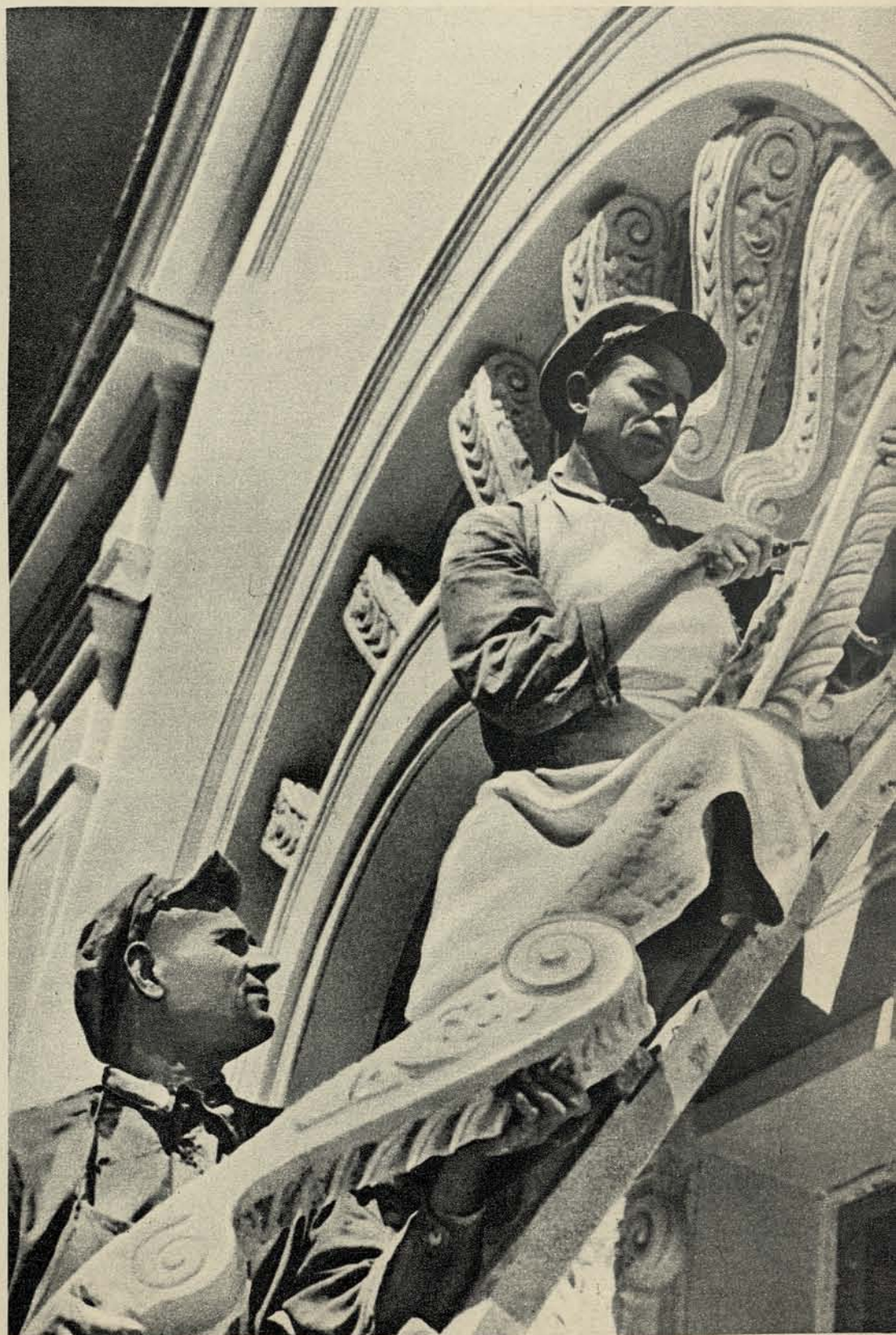
Справа — отделка фасада восстановленного здания вокзала в г. Ставрополе.
