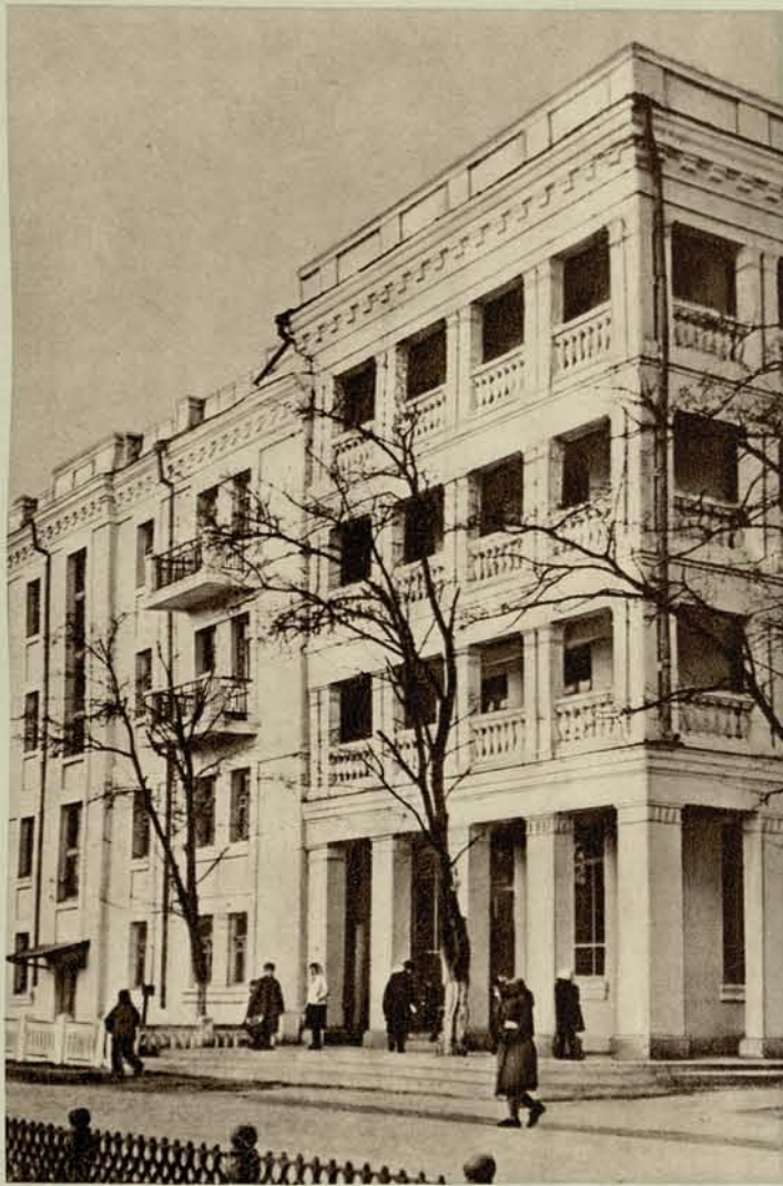
Один из домов для рабочих металлургического завода в гор. Жданове. Этот дом был разрушен немецкими оккупантами и потребовал капитального восстановления.
