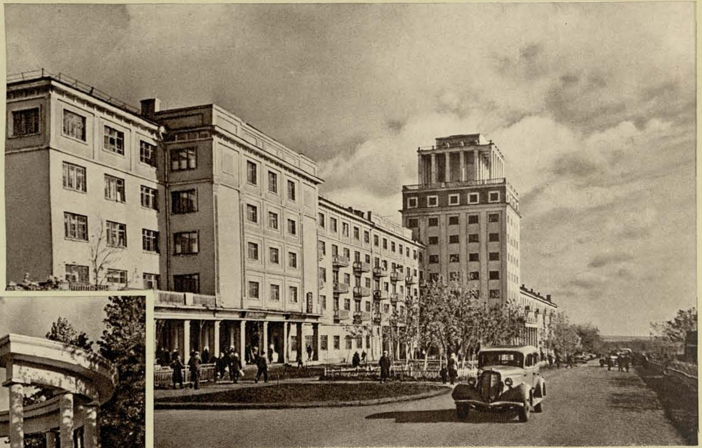
Комсомольская улица — центральный проспект Сталиногорска. Из года в год эта улица удлиняется, — по обоим концам ее вырастают новые большие дома и коттеджи рабочих.
