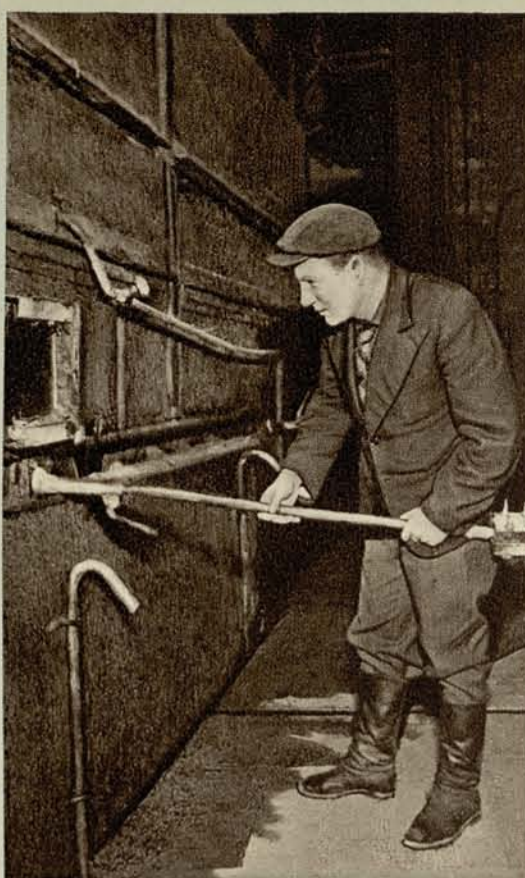
На Уральском заводе тяжелого машиностроения. Очистка литья от формовочной земли в специальных, хорошо изолированных гидрокерамах. В отличие от ручной, такая очистка значительно облегчает труд и освобождает от пыли производственные помещения литейных цехов.
