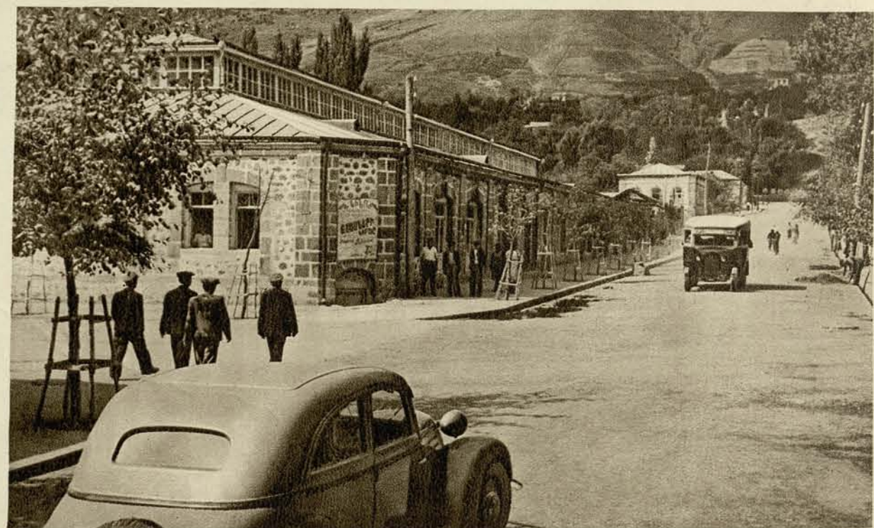
Город Горис. Здание трикотажной фабрики.
