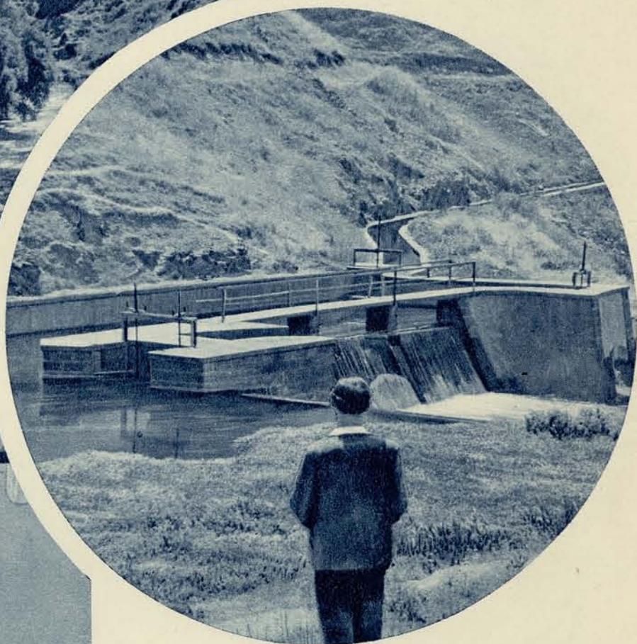
Плотина гидростанции, обуздавшая небольшую, но бурную горную речку.
