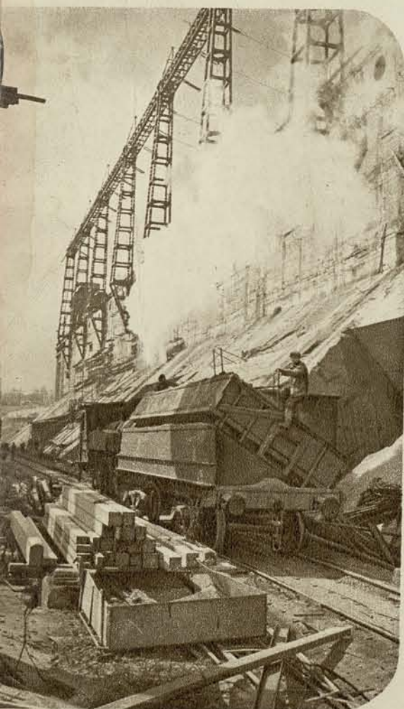
В дни восстановления Днепрогэса. Строительство щитовой стены.
