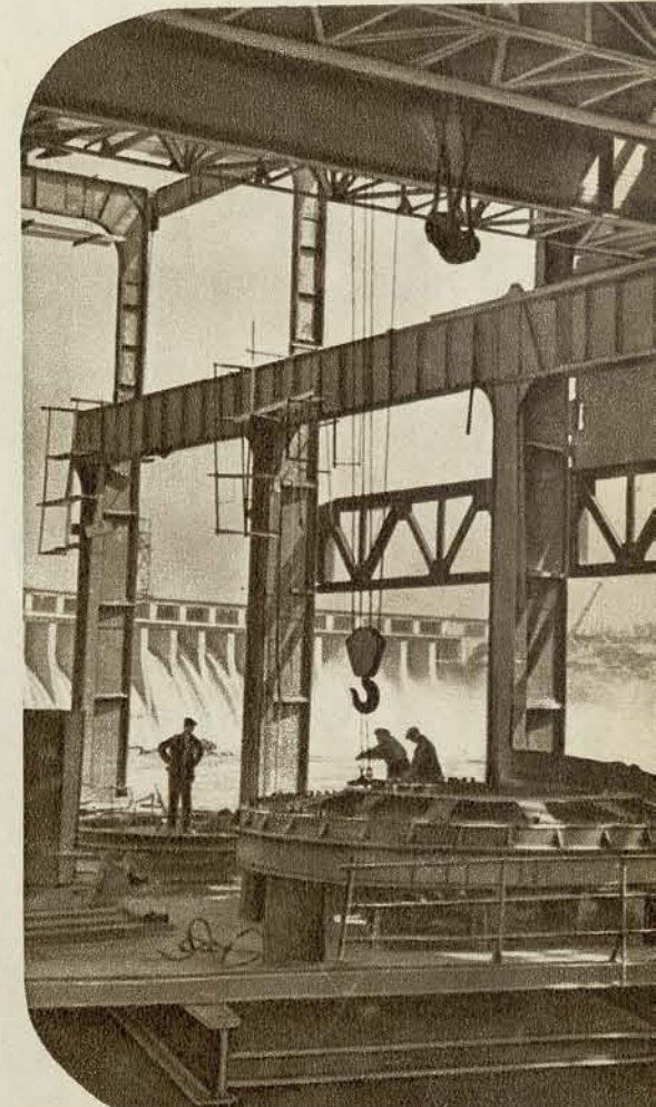
Восстановление Днепрогэса. Монтаж турбины.
