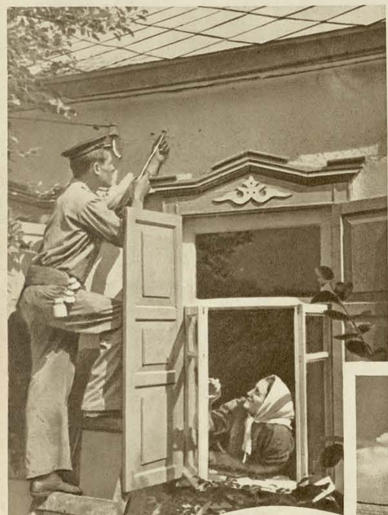
Высоковольтная линия передачи подала ток районной электростанции в колхоз им. Шевченко, Харьковской области. В новый дом колхозницы А. Шаруды проводится электричество.
