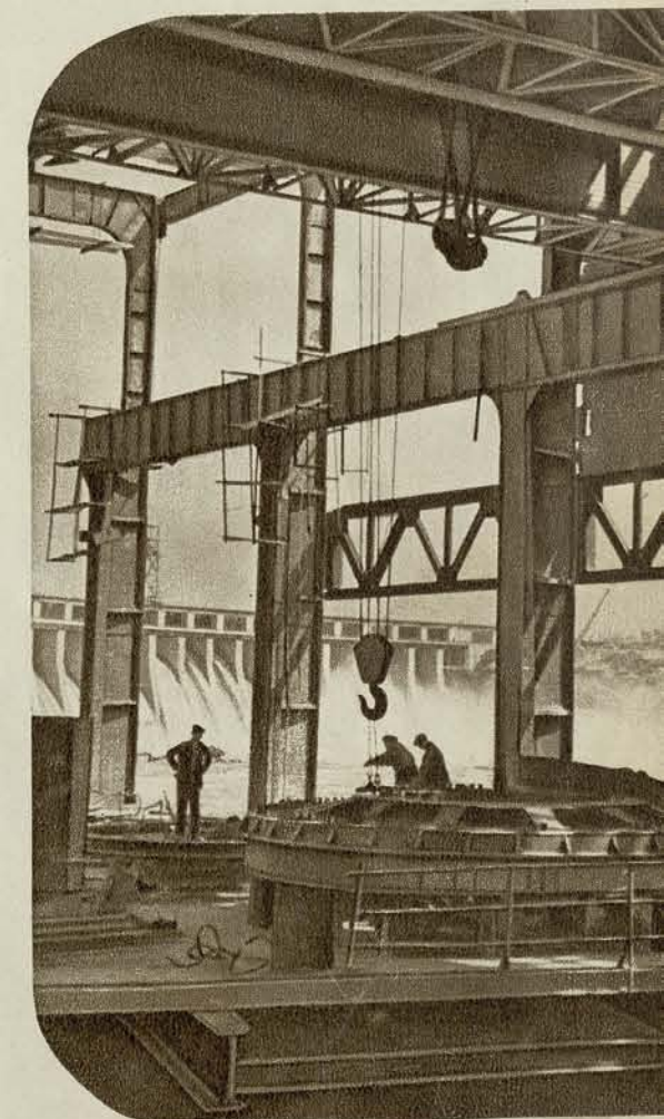
Восстановление Днепрогэса. Монтаж турбины.
