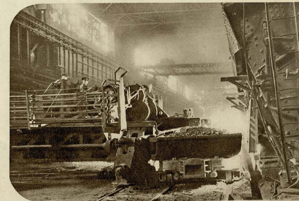
Механическая завалка мартеновской печи на заводе „Азовсталь”.
