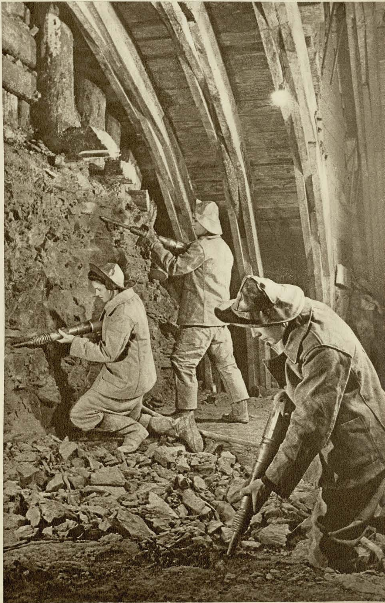
Бригада строителей ленинградского метро ведет разработку щитовой камеры.
