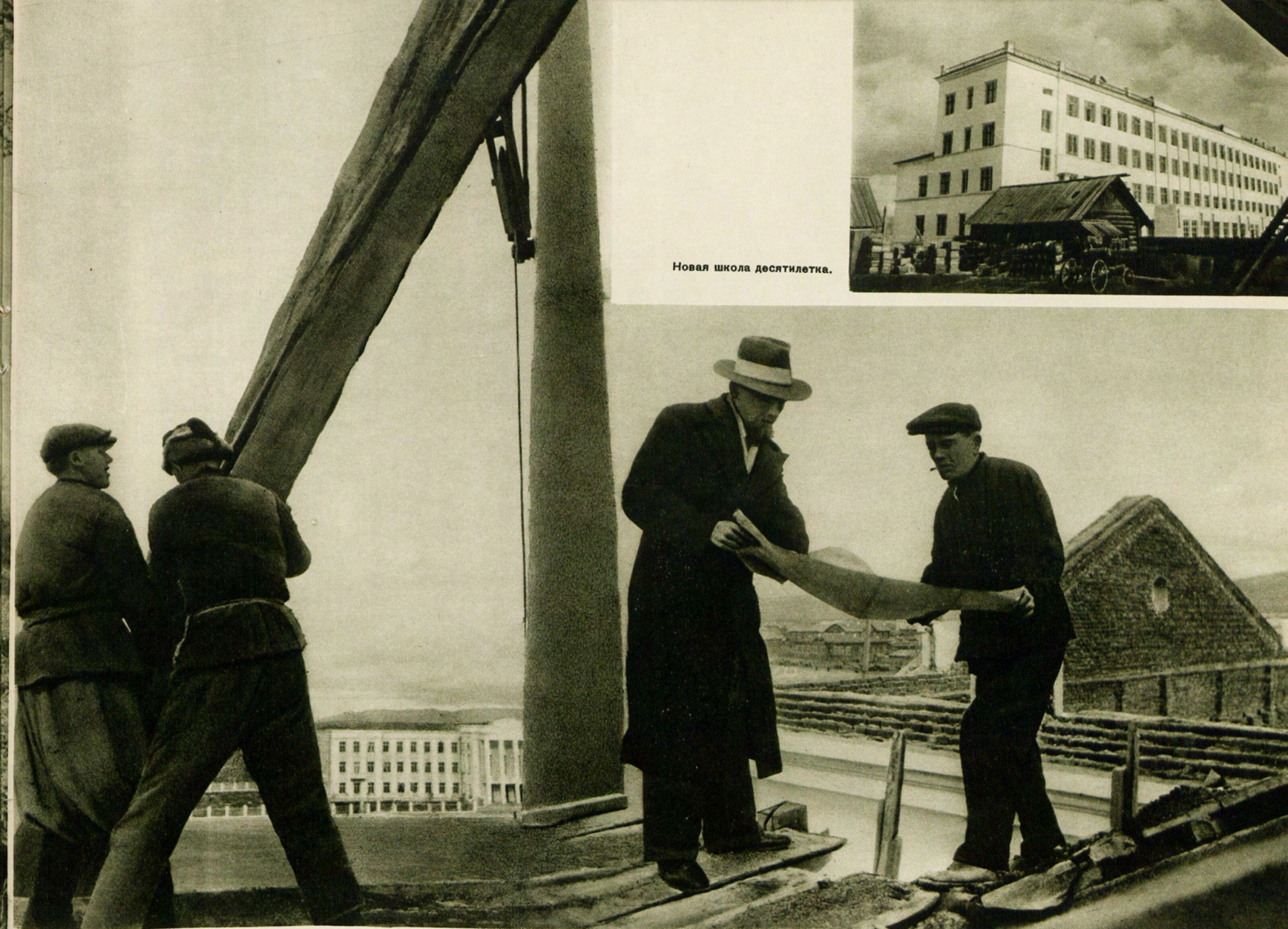
В городе ведется непрерывная стройка.
