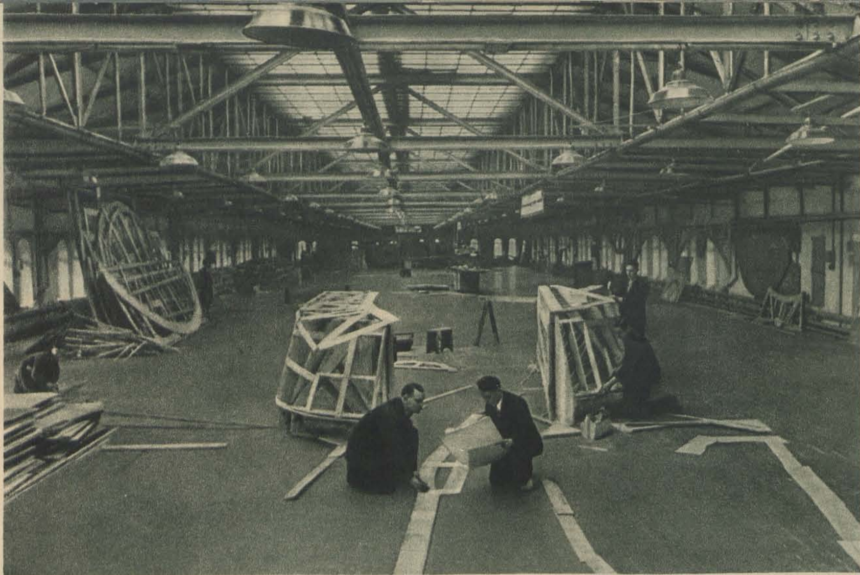
Изготовленные шаблоны проверяются на плазе.
