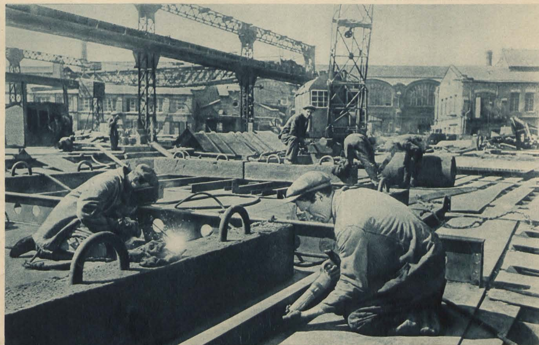
В цеху предварительной сборки идет монтаж деталей.
