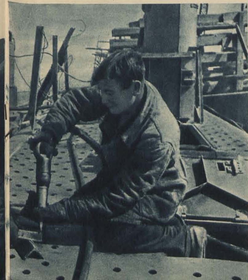
Подгонка деталей корпуса.
