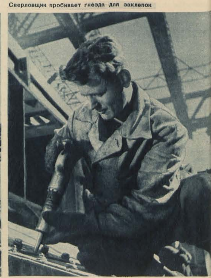
Сверловщик пробивает гнезда для заклепок
