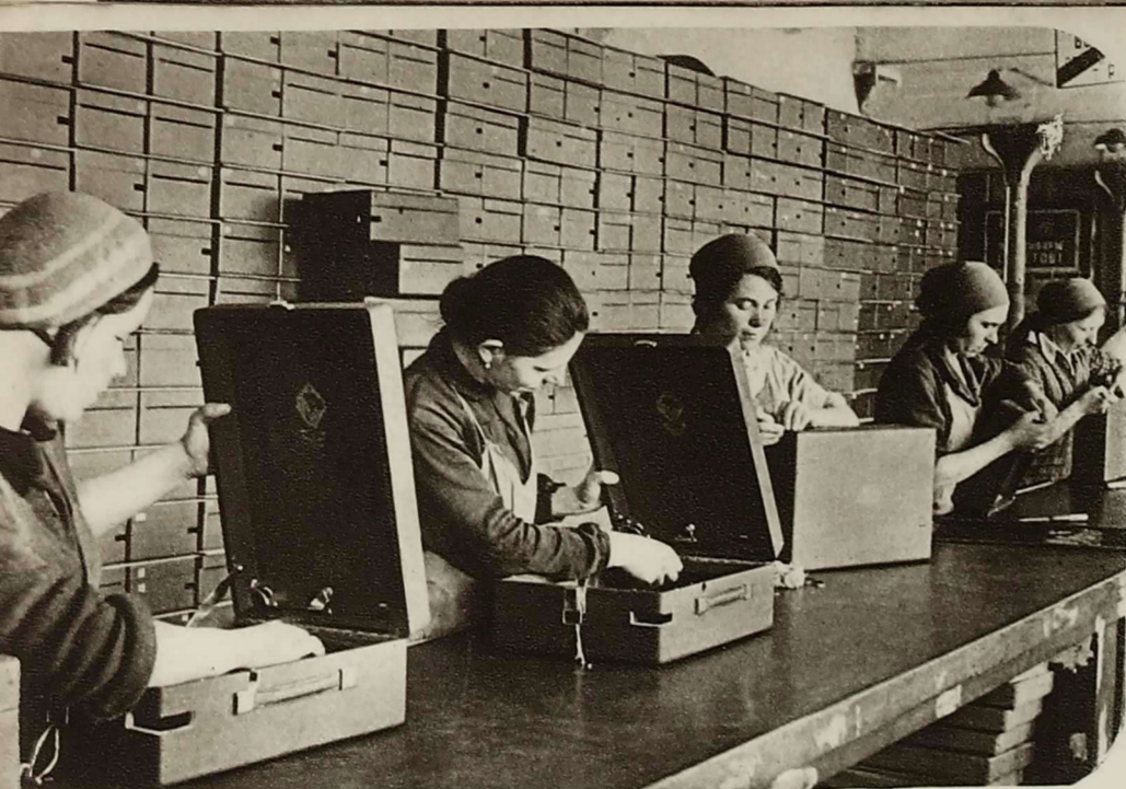
ОКОНЧАТЕЛЬНАЯ ОТДЕЛКА ФУТЛЯРОВ.
