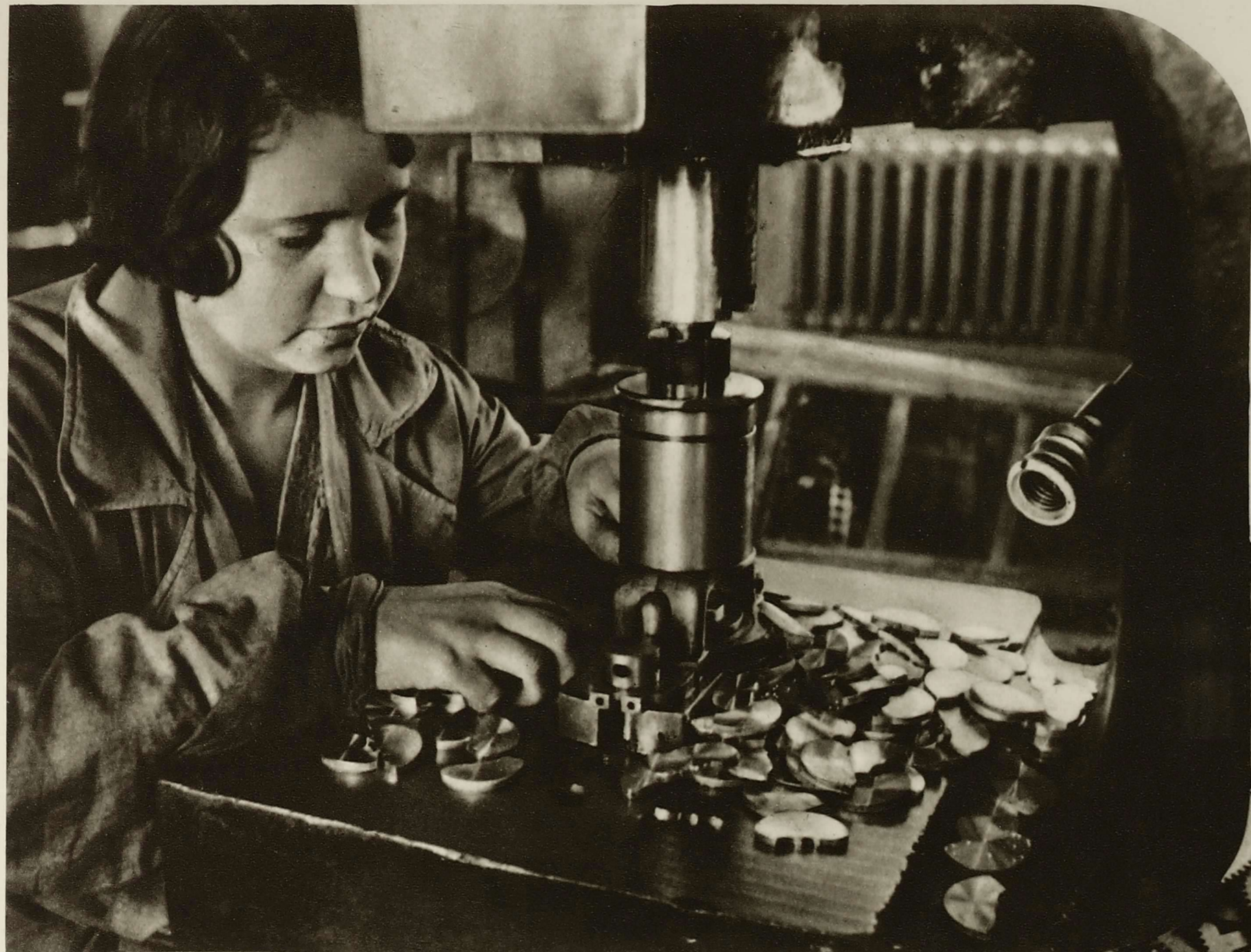
РАСТОЧКА ОТВЕРСТИЙ В КОРПУСЕ РУЧНЫХ ЧАСОВ.
