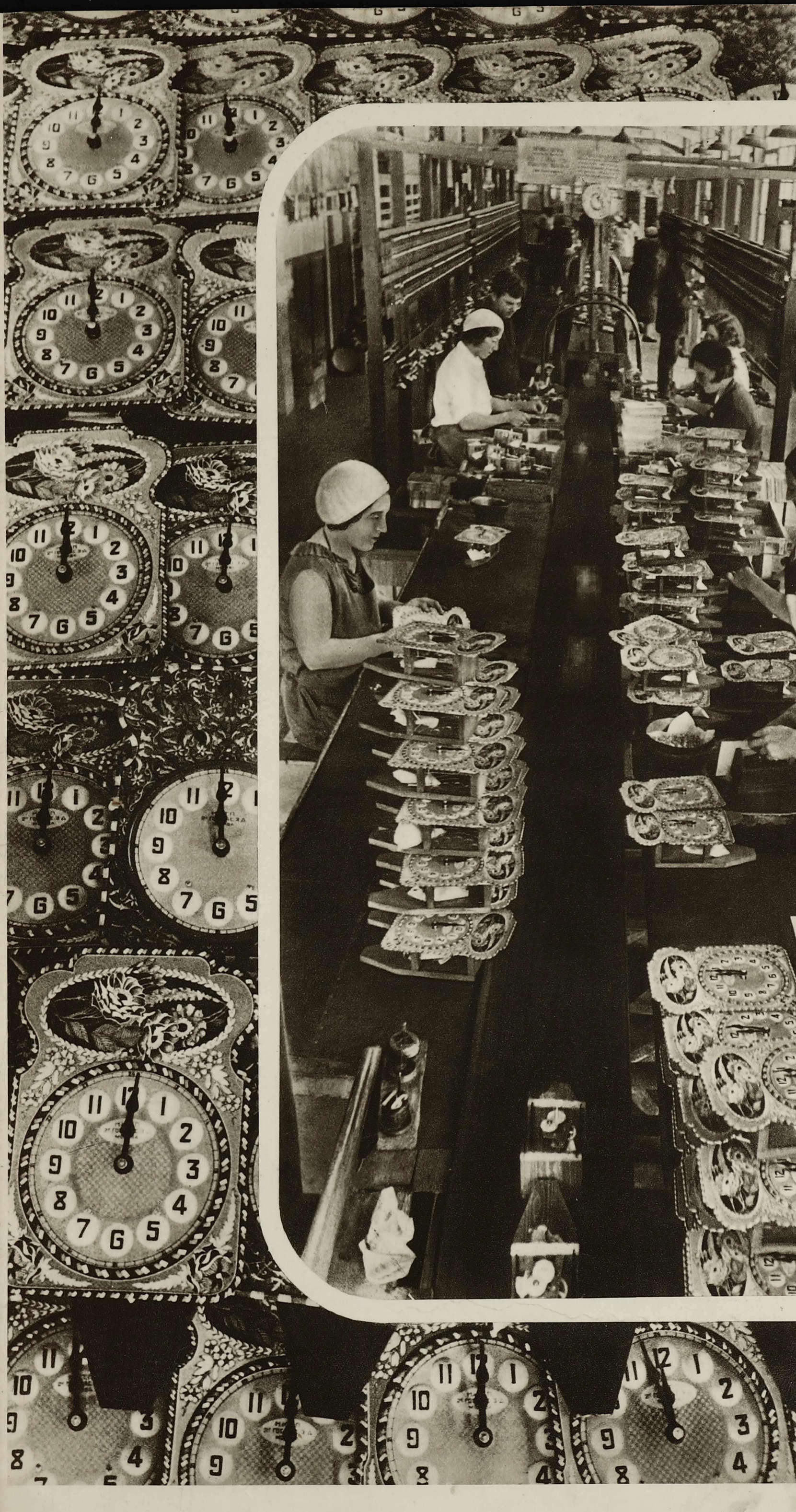
КОНВЕЙЕР «ХОДИКОВ» И ГОТОВЫЕ «ХОДИКИ».
