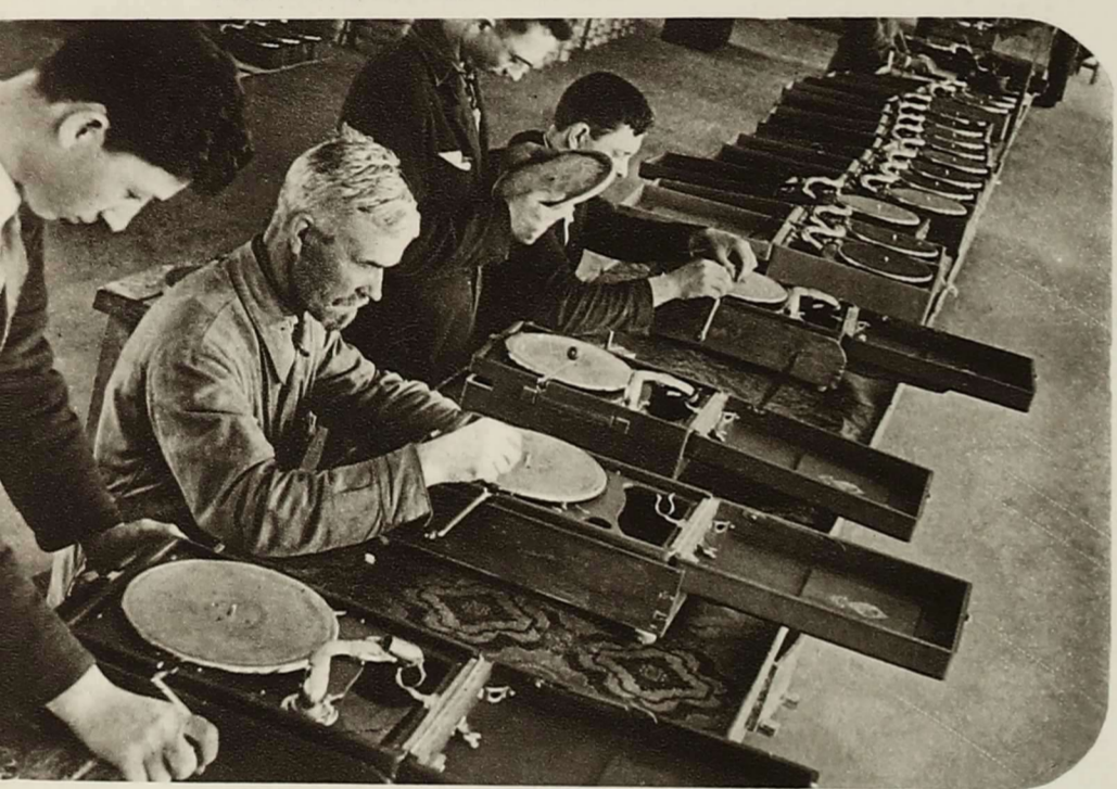
ПОСЛЕДНЕЕ ИСПЫТАНИЕ СОБРАННОГО ПАТЕФОНА.
