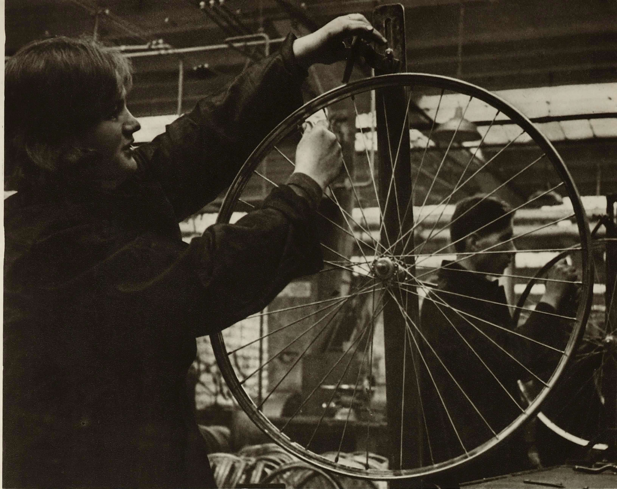
СБОРКА КОЛЕС И УКРЕПЛЕНИЕ СПИЦ — ОДНА ИЗ ОТВЕТСТВЕННЕЙШИХ ОПЕРАЦИЙ ВЕЛОСИПЕДНОГО КОНВЕЙЕРА.
