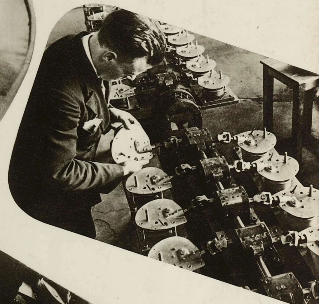
СОБРАННЫЙ И ЗАКЛЮЧЕННЫЙ В МЕТАЛЛИЧЕСКУЮ КОРОБКУ МЕХАНИЗМ ПАТЕФОНА ТЩАТЕЛЬНО ПРОВЕРЯЕТСЯ.
