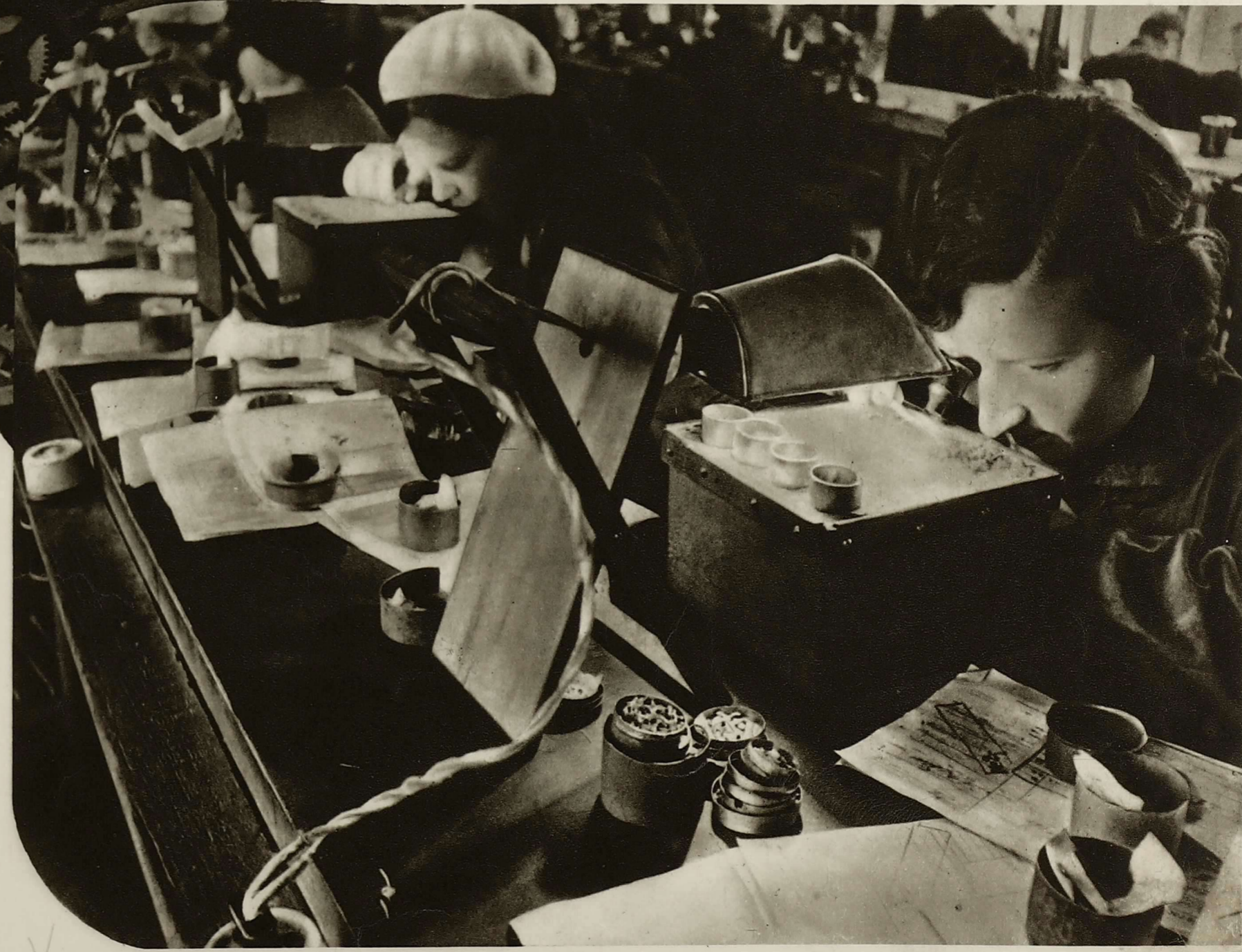
ДЕТАЛИ МЕХАНИЗМОВ ЧАСОВ ТАК МЕЛКИ, ЧТО ИХ ПРОВЕРКА ПРОИЗВОДИТСЯ ПРИ ПОМОЩИ СПЕЦИАЛЬНЫХ ОПТИЧЕСКИХ ПРИБОРОВ И ЛАМП. В ОДНОЙ КОНСЕРВНОЙ БАНКЕ МОЖЕТ УМЕСТИТЬСЯ ТАКОЕ КОЛИЧЕСТВО ШЕСТЕРенок РУЧНЫХ ЧАСОВ, КОТОРОЕ МОГЛО БЫ УДОВЛЕТВОРИТЬ ПОТРЕБНОСТЬ ВСЕГО ЗАВОДА НА НЕСКОЛЬКО МЕСЯЦЕВ.
