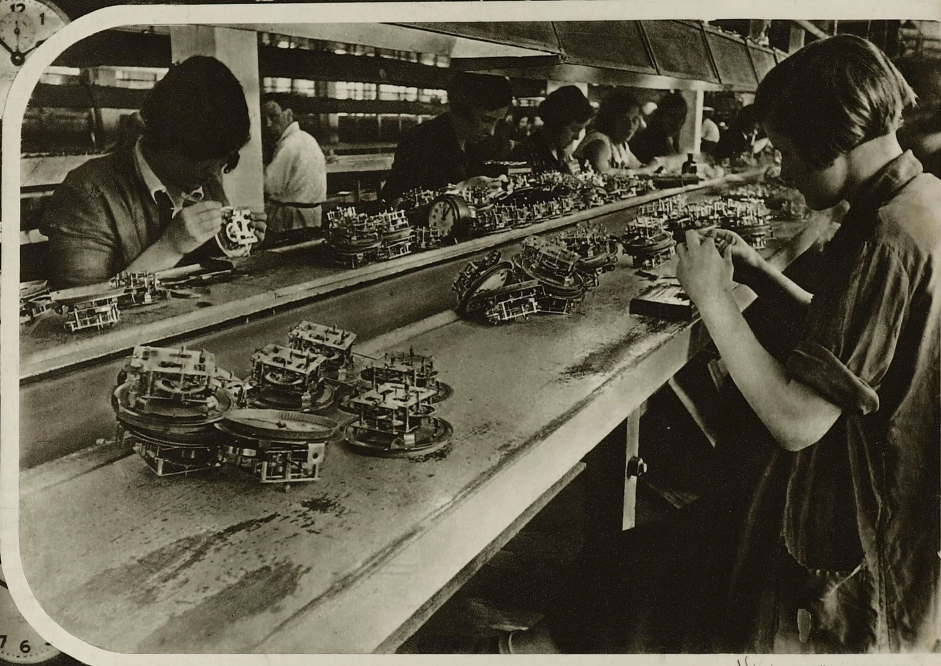
W КОНВЕЙЕР СБОРКИ БУДИЛЬНИКОВ И ГОТОВАЯ ПРОДУКЦИЯ.
