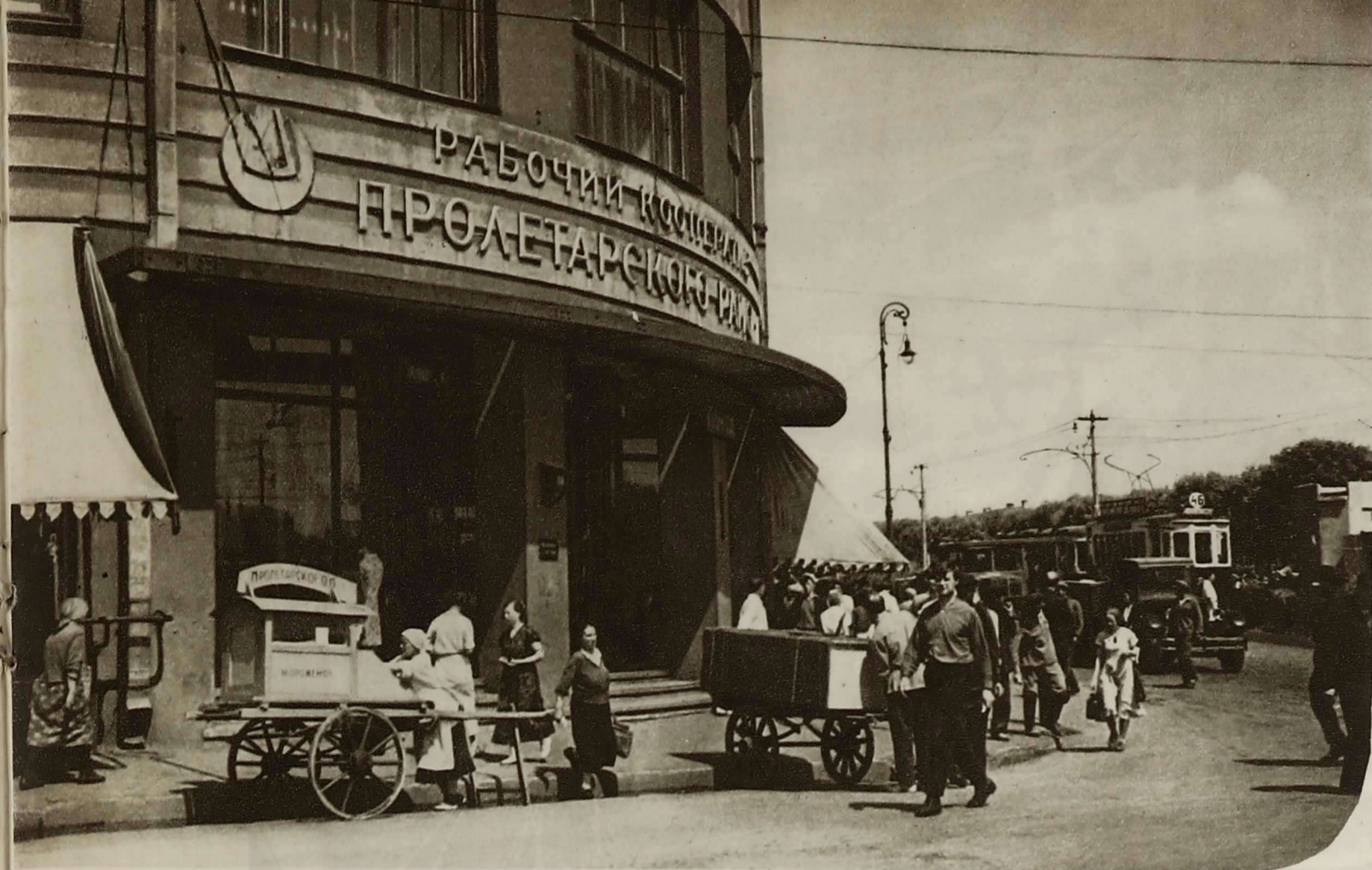
РАБОЧИЙ КООПЕРАТИВ ПРОЛЕТАРСКОГО РАЙОНА В МОСКВЕ. ДЕТАЛЬ ВХОДА.
