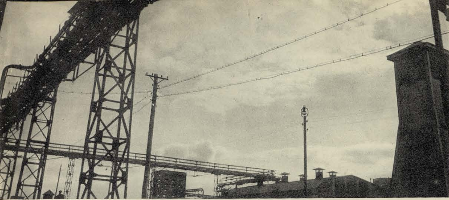
Газоход из цеха синтеза в склад аммиака.
