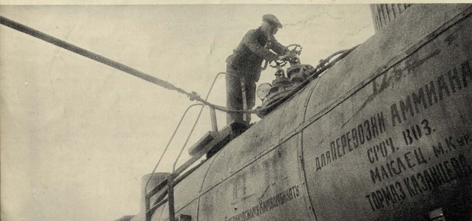
Погрузка аммиака в цистерны.
