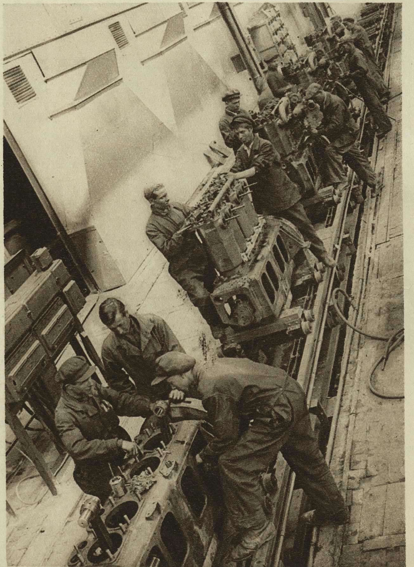
Сборка моторов на конвейере.
