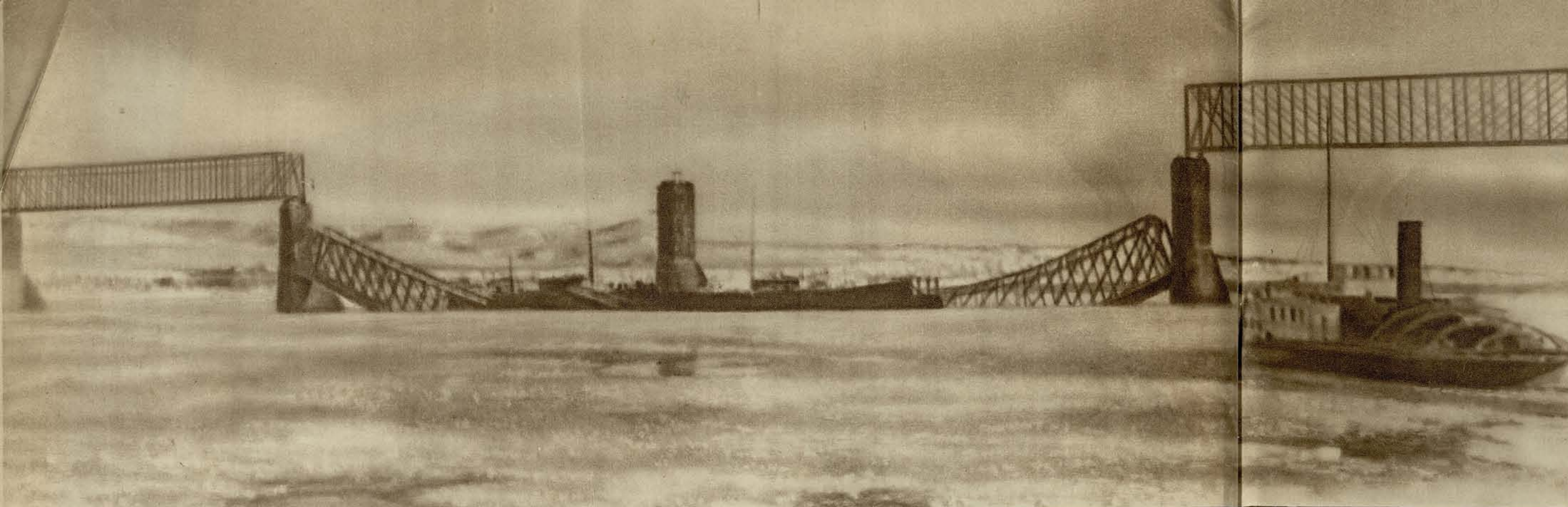
Сызранский мост, разрушенный во время гражданской войны.
