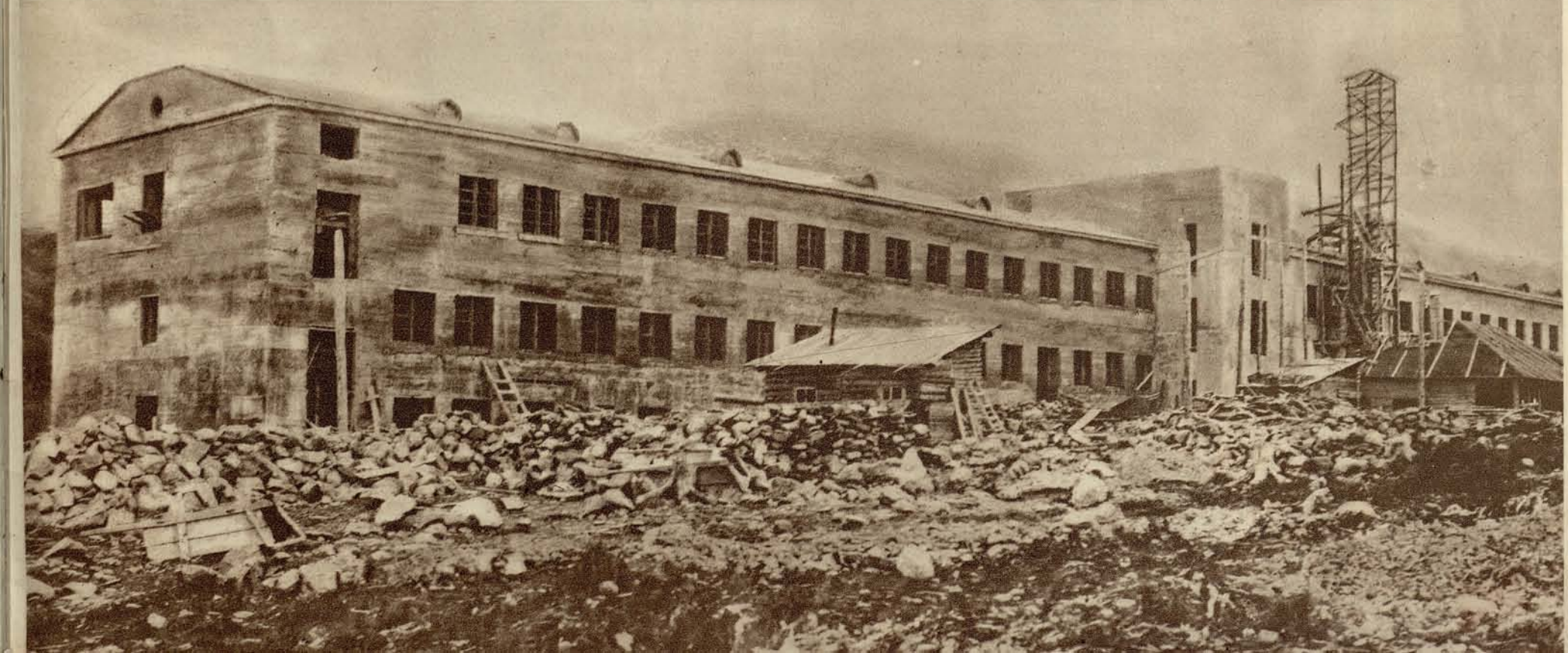
Строится новая больница.
