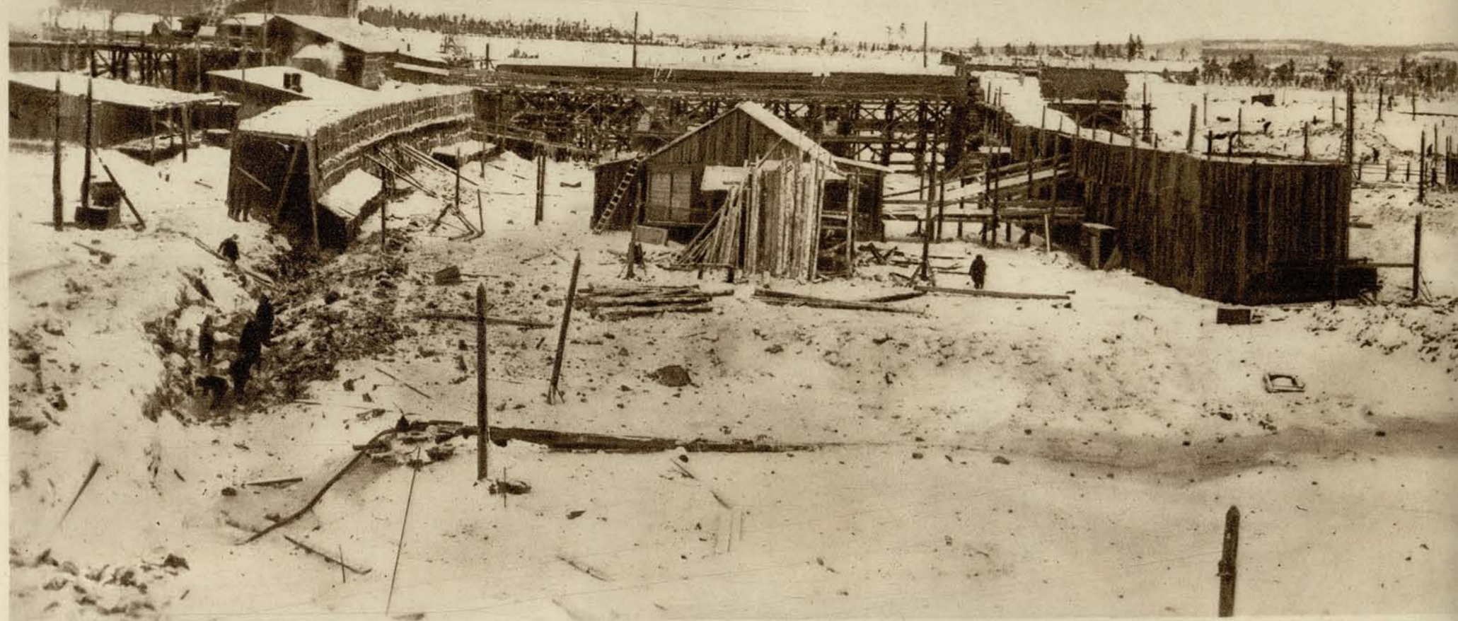
Строительство гидроэлектростанции на р. Нива.
