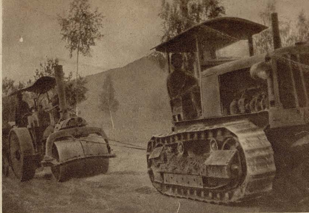
Укатка новой дороги.
