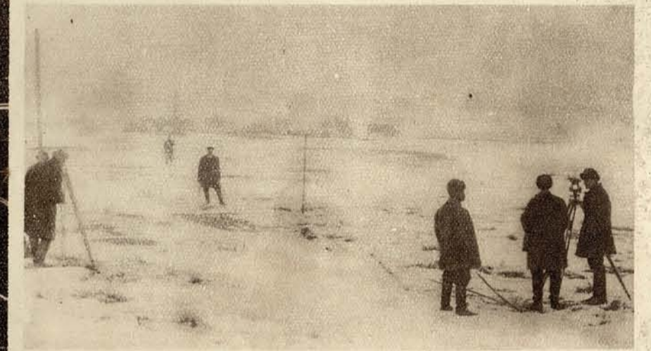
Трассировка будущего пути в районе ст. Луганской.
