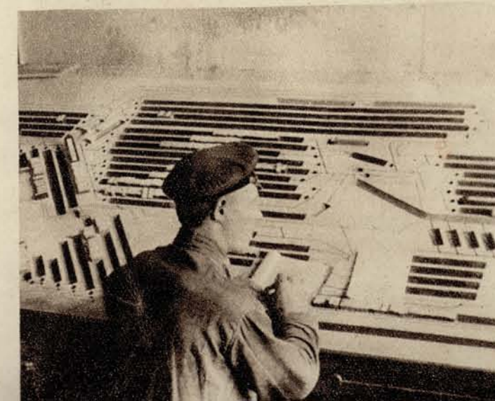
Как на ладони видит диспетчер положение станции Бологое на маневровом столе системы проф. Фролова.
