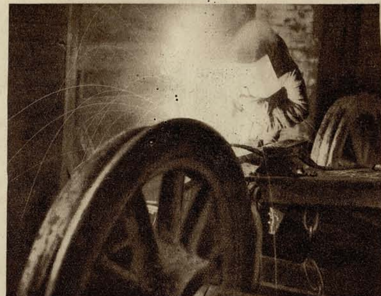
Фиолетовые огни: огни электросварки, получающей широчайшее применение в реконструкции транспорта (путевые, депоовские работы, заводской ремонт и т. д.).
