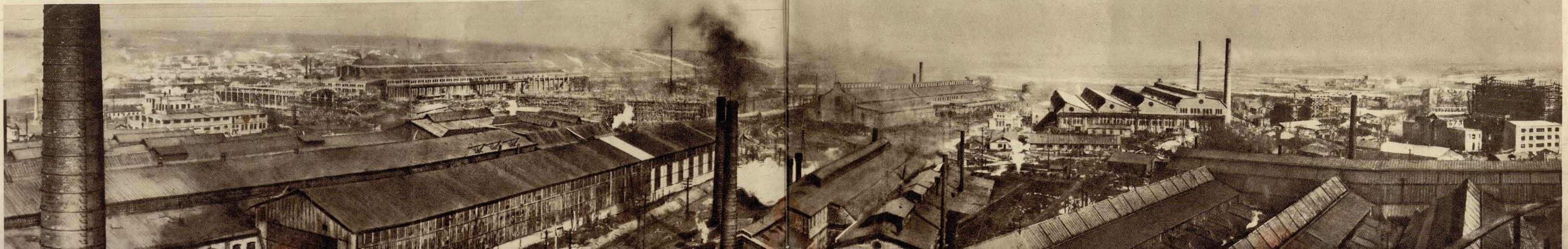
Такова величественная панорама Луганского паровозостроительного завода. Заканчивающийся стройкой новый Луганский завод должен в 1932 г. дать 390 паровозов серии Э и 10 паровозов ФД 1-5-1.
