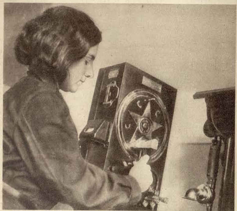
Практические занятия с аппаратом жезловой сигнализации системы Грегера в Закавказском институте путей сообщения.
