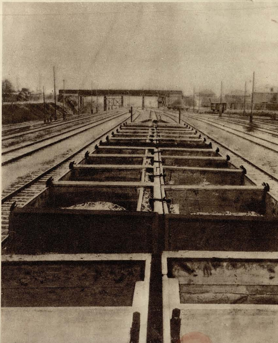
Саморазгружающийся состав путевого комбайна для производства балластных работ.
