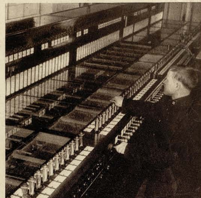
Блокировочный аппарат на блокпосте Москва-Северная. Один аппарат регулирует запутанный клубок движения, целую систему оборудованных блокировкой путей. Надо ли говорить, насколько повысилась безопасность при исключительном росте густоты самого движения. Ведь Москва-Северная отправляет 200 пар одних пассажирских поездов в день. Каждые 2—3 минуты поезд.
