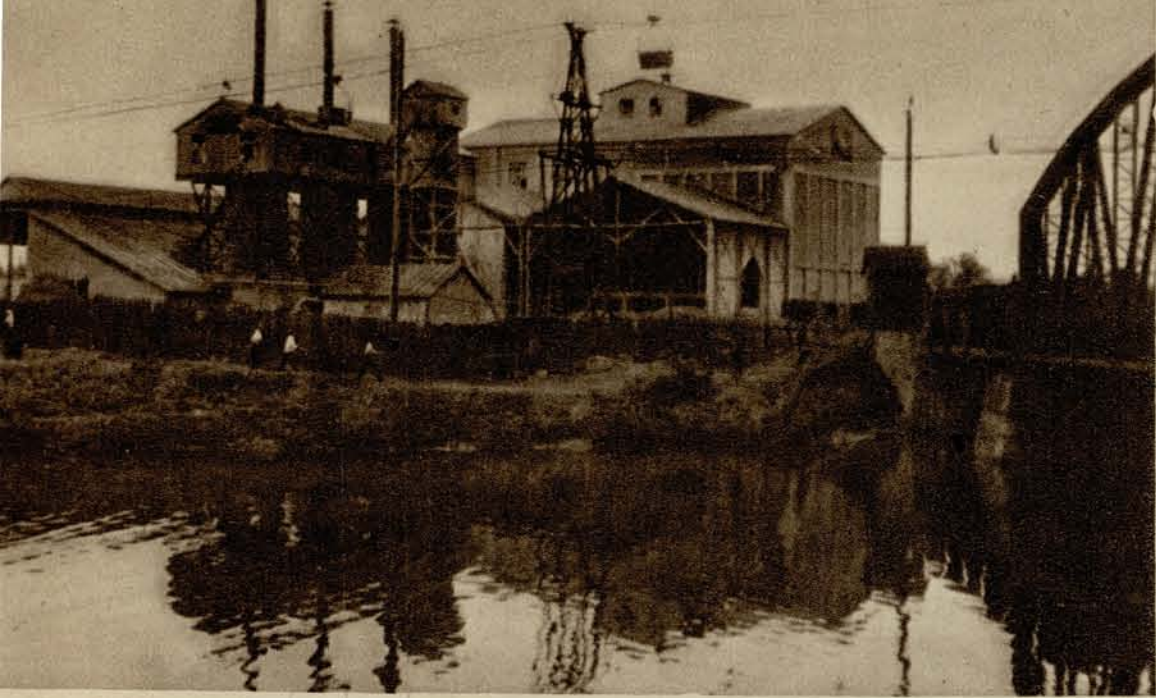
На этом заводе происходит грануляция шлака действующих домен; после чего шлаковые камни служат одним из важных строительных материалов.
