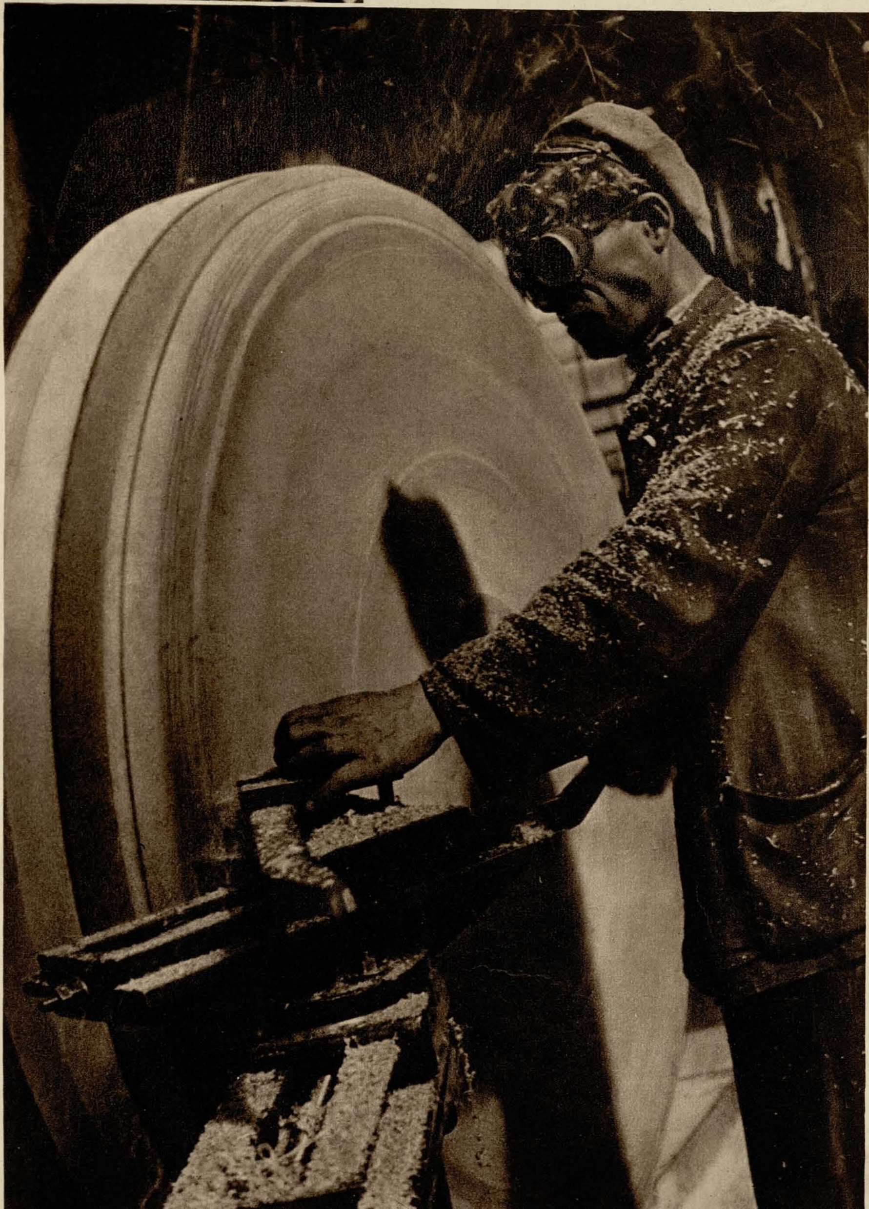
41 станок — оборудование модельного цеха. 134 человека — его штат. Обточка детали для доны Нижнетагильского завода.
