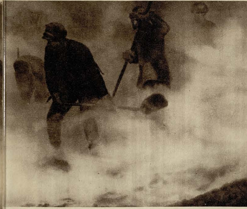
Тяжелым ручным способом шла когда-то разливка чугуна в песочные формы на литейном дворе Краматорского завода «Фицнер и Гампнер».
