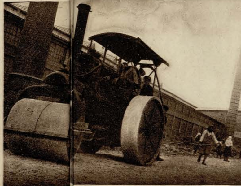
Асфальтируют пролеты между цехами. Так налаживается внутризаводская связь между отдельными процессами производства.
