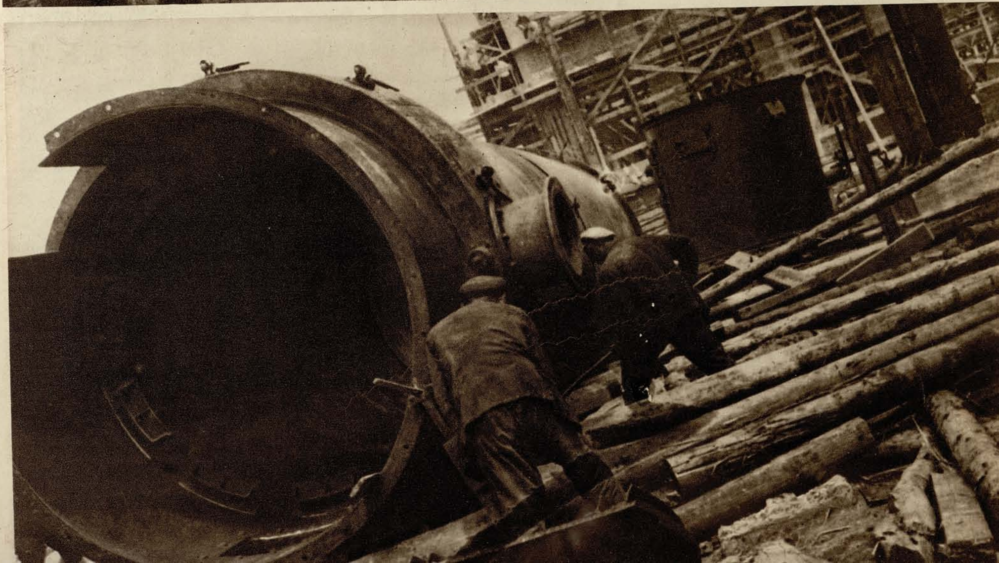
Сборка и монтаж 10-тонной вагранки.
