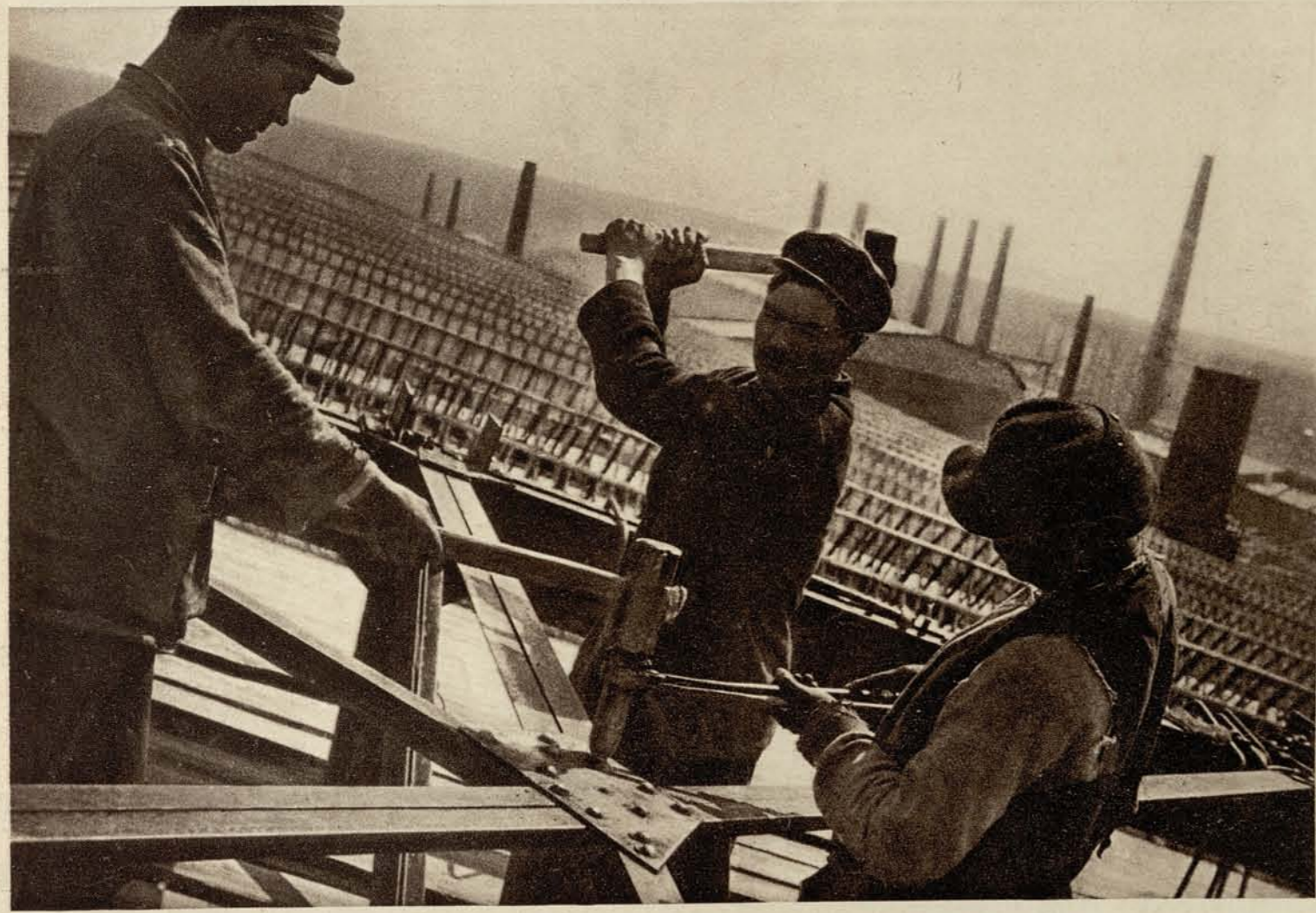
Клепка конструкций кузнечно-прессовального цеха.
