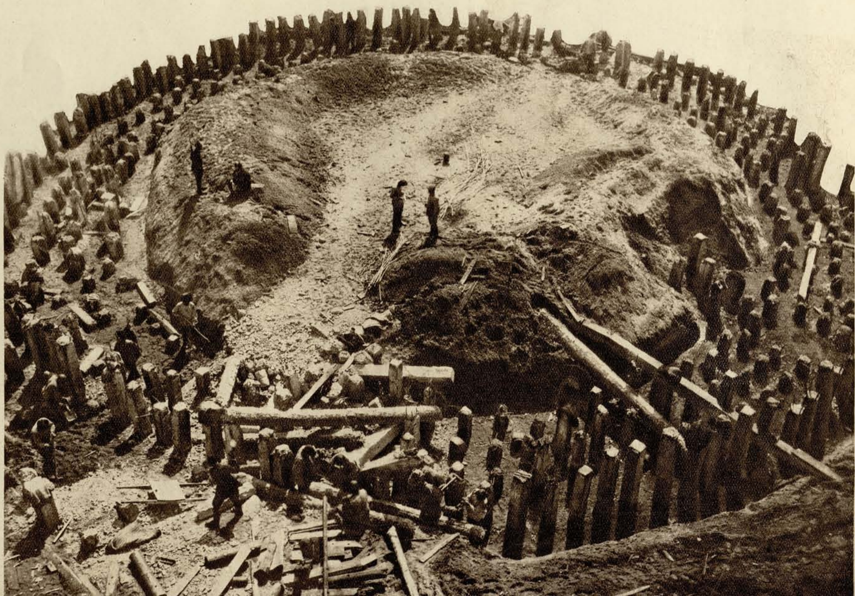
Сотни железобетонных свай заколачивали под каждый фундамент.
