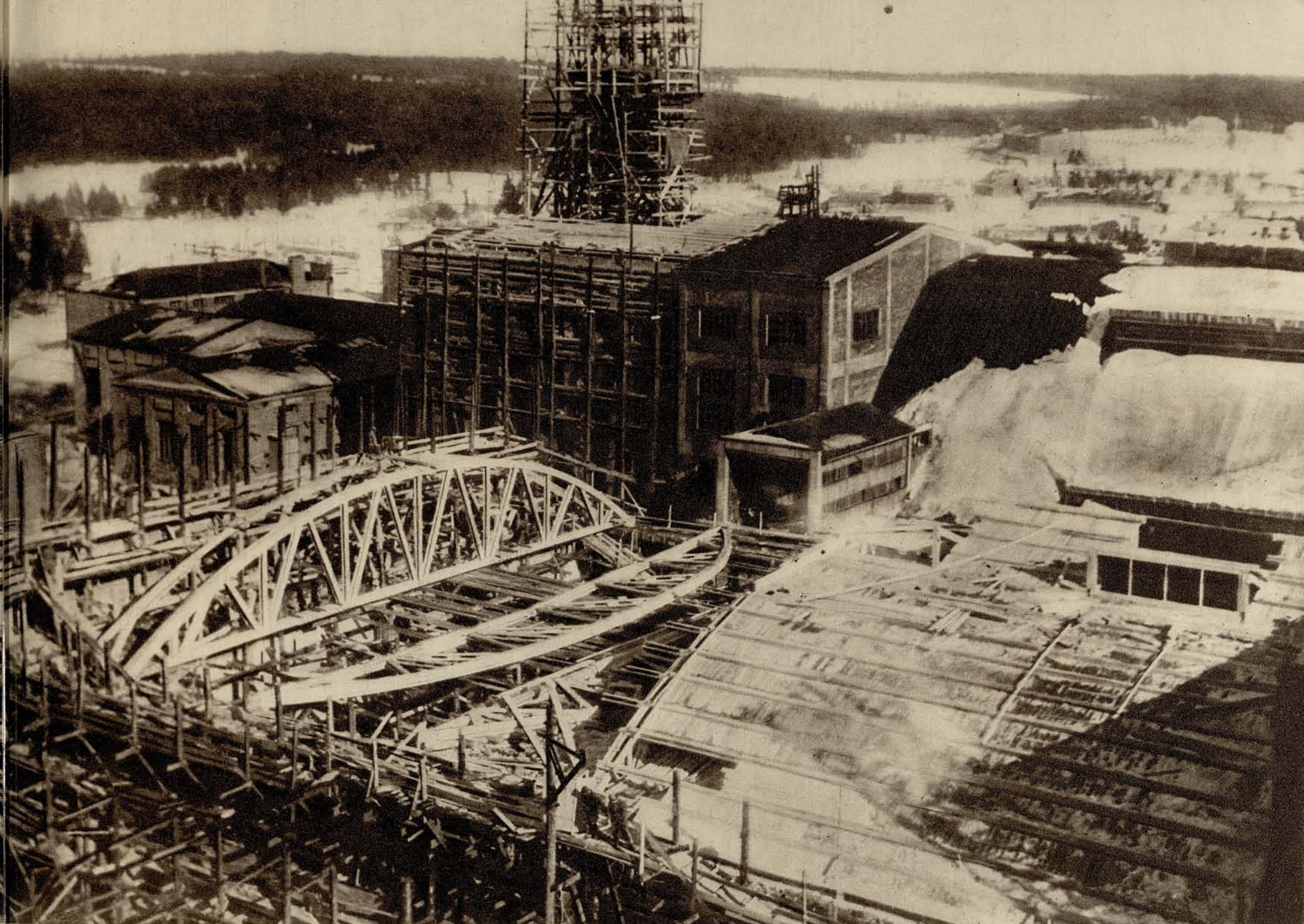
Внизу шахтный копер и склад сырых сильвинитов.
