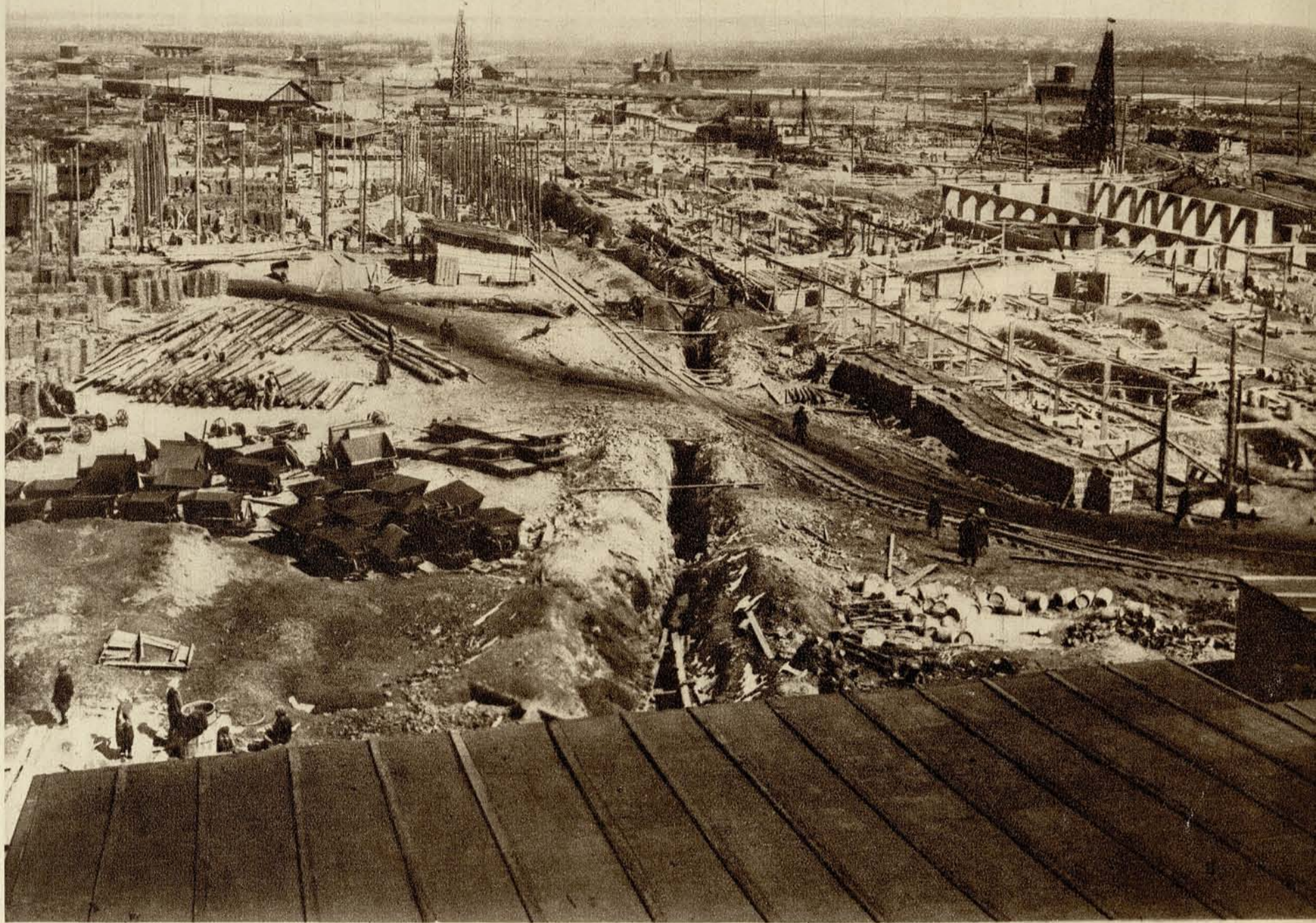
В мае 1930 года на месте болота стояли уже фундаменты основных промышленных объектов, 125 тысяч кубометров бетона было влито в них.
