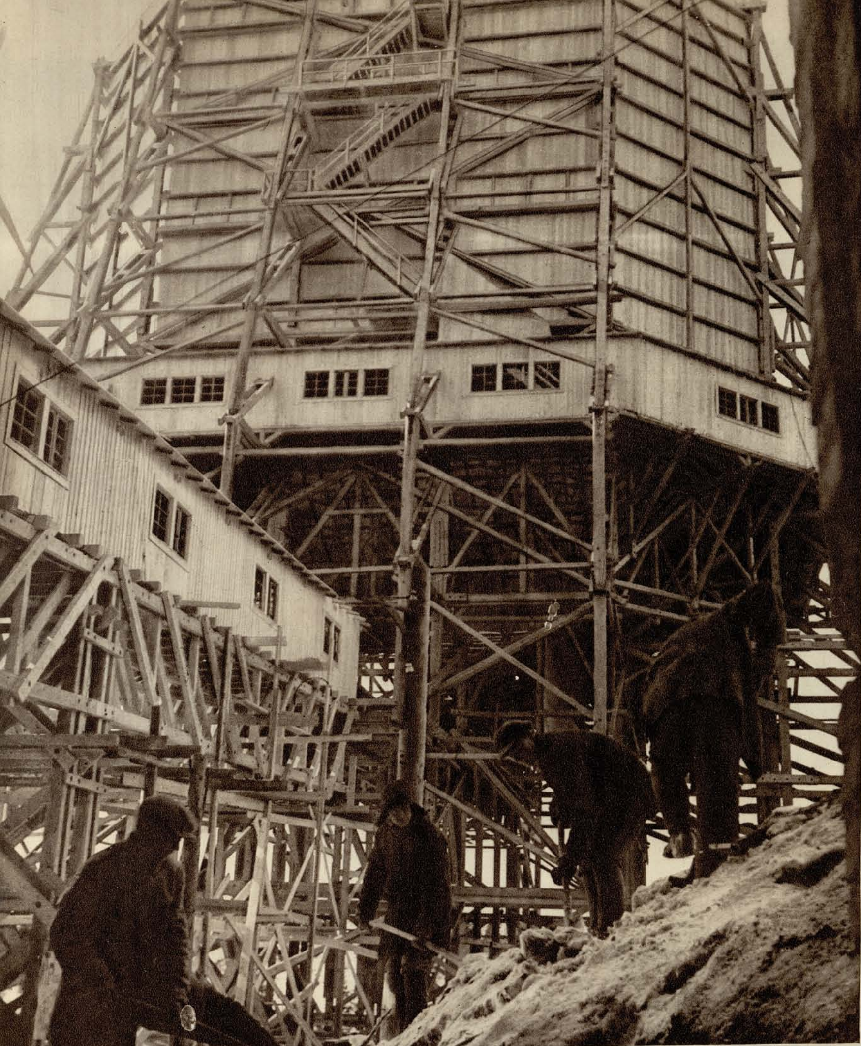
Монтаж детали оборудования склада сырых солей.
