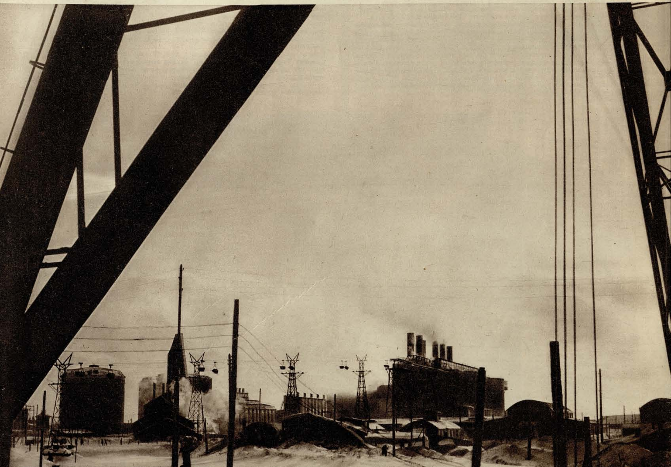
Уголь подается на склад комбината и транспортируется отсюда по канатной дороге в систему пылеприготовления ТЭЦ.
