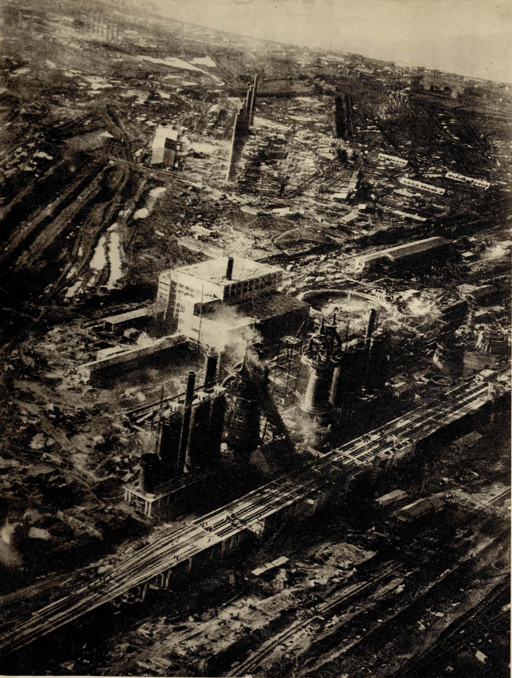
Взгляните на строительство с аэрона. В результате напряженнейшего, огромного труда закончены постройкой объекты первой очереди завода.
