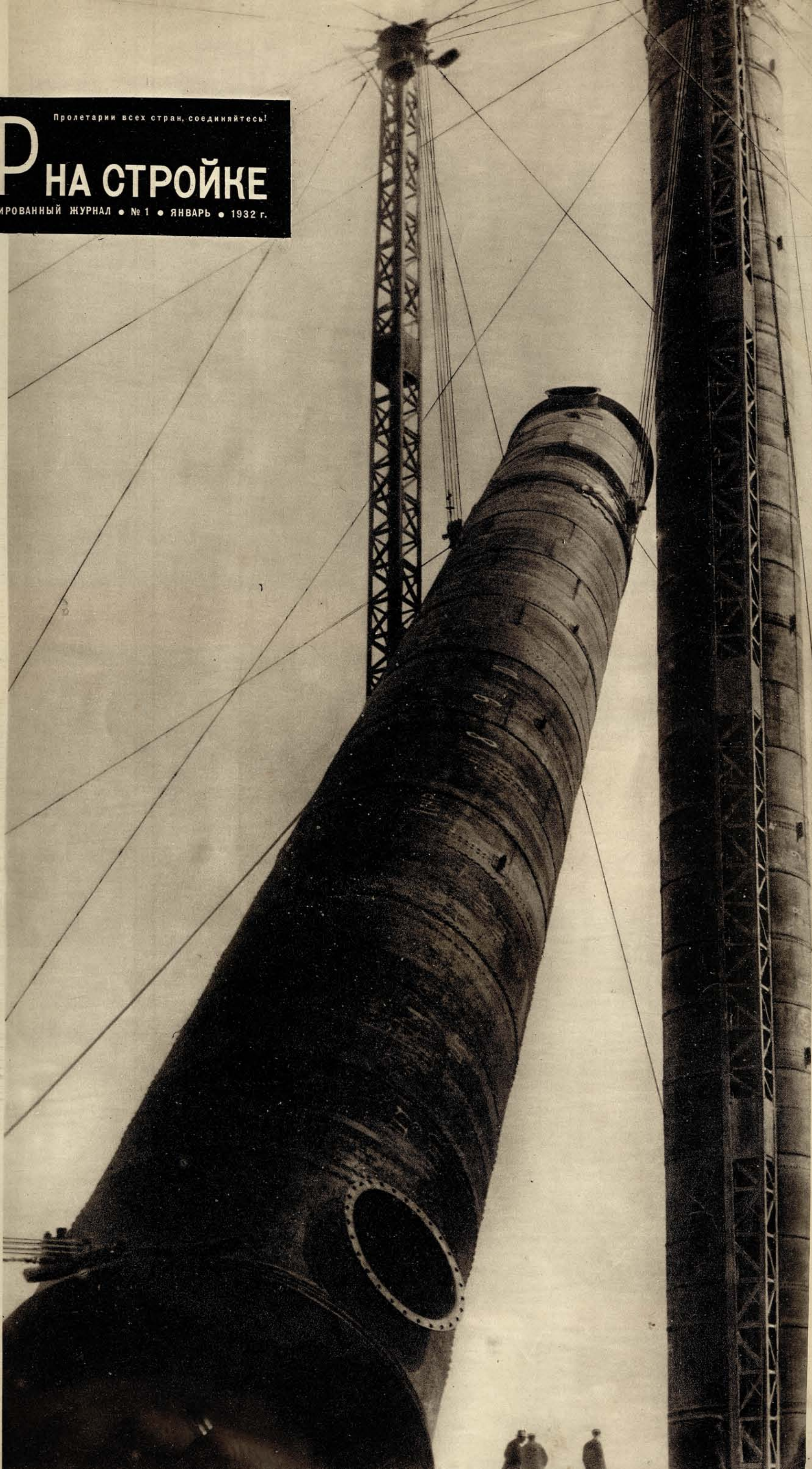
Магнитострой. Подъем скруббера.
