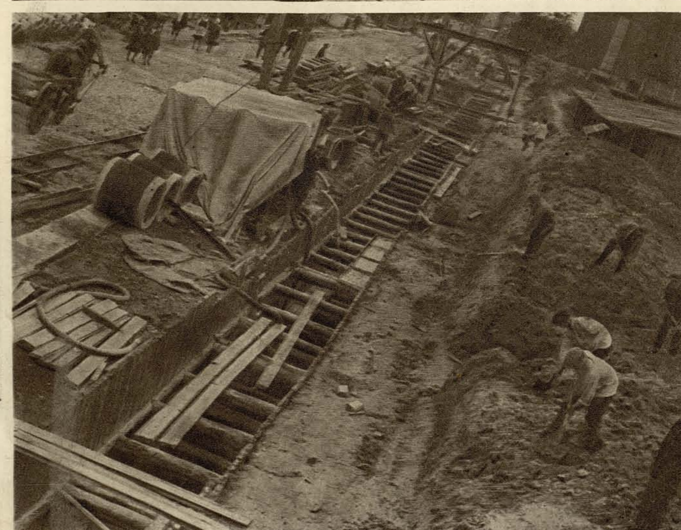
Прокладка канализации на Васильевском острове.
