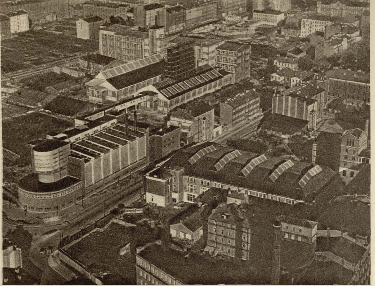
Новые корпуса и силовая станция чулочно-трикотажной фабрики „Красное Знамя“ (с аэроплана).
