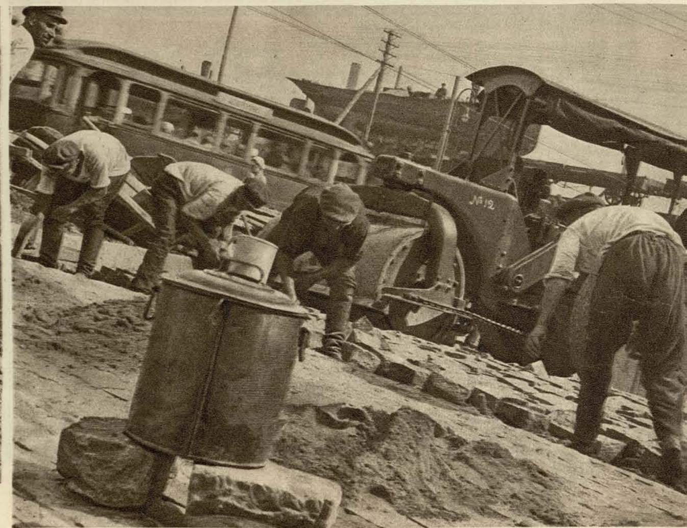
Укладывают новую мостовую у завода „Электросила“.
