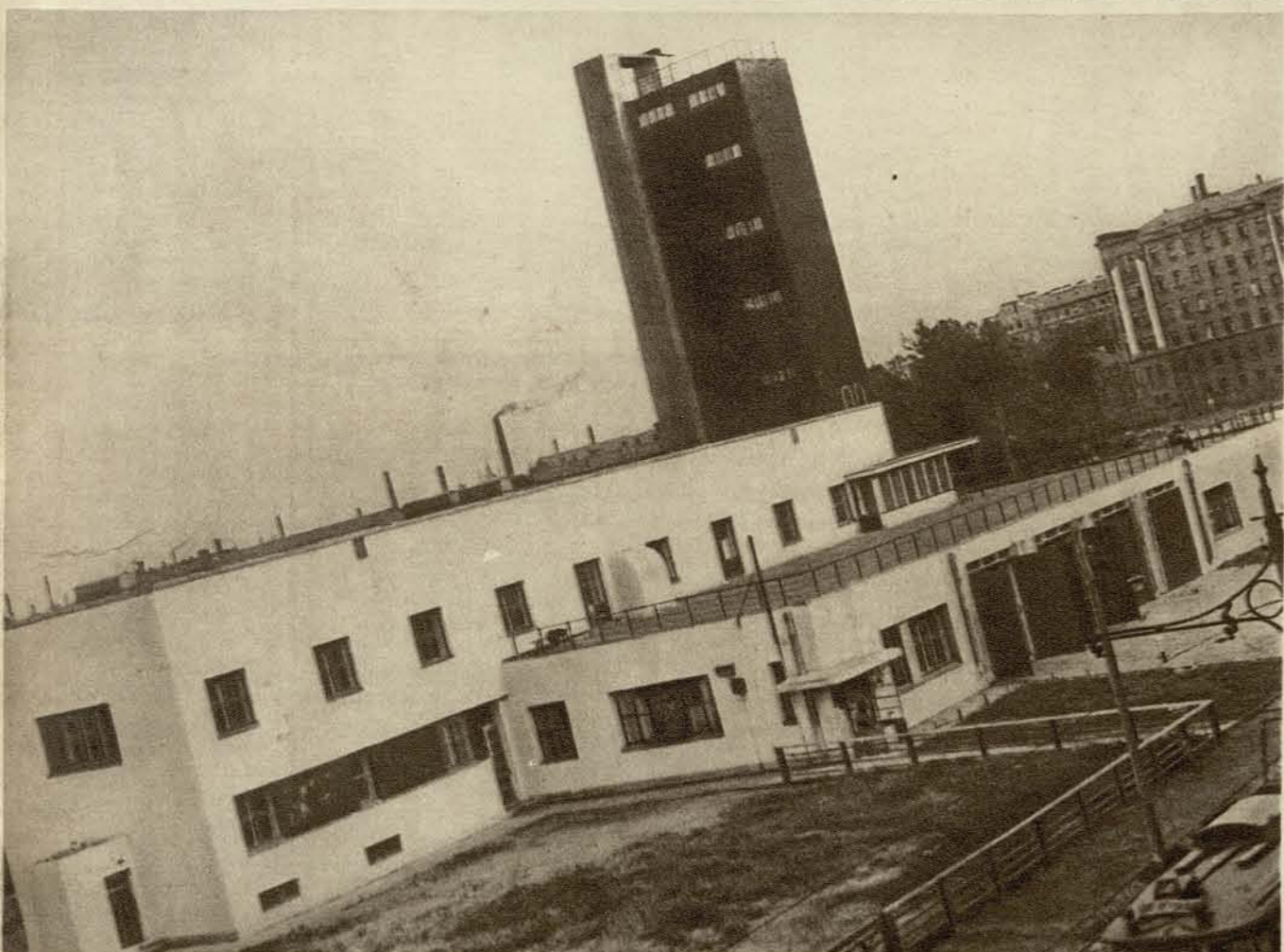
Новая пожарная часть в Выборгском районе.
