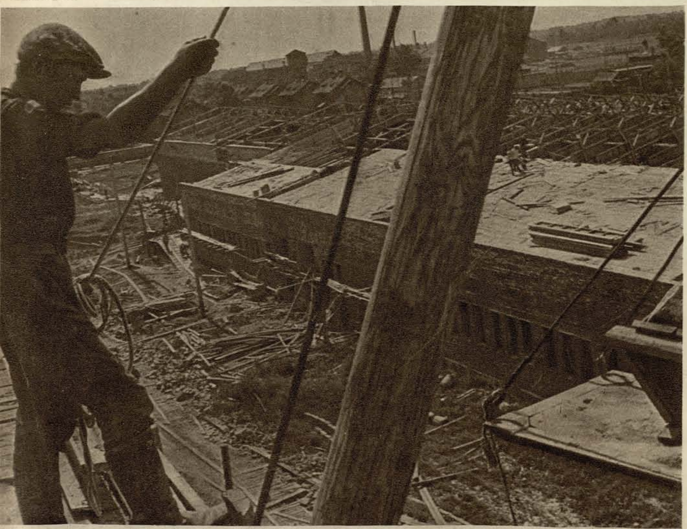
Строится новый трамвайный парк в Володарском районе.
