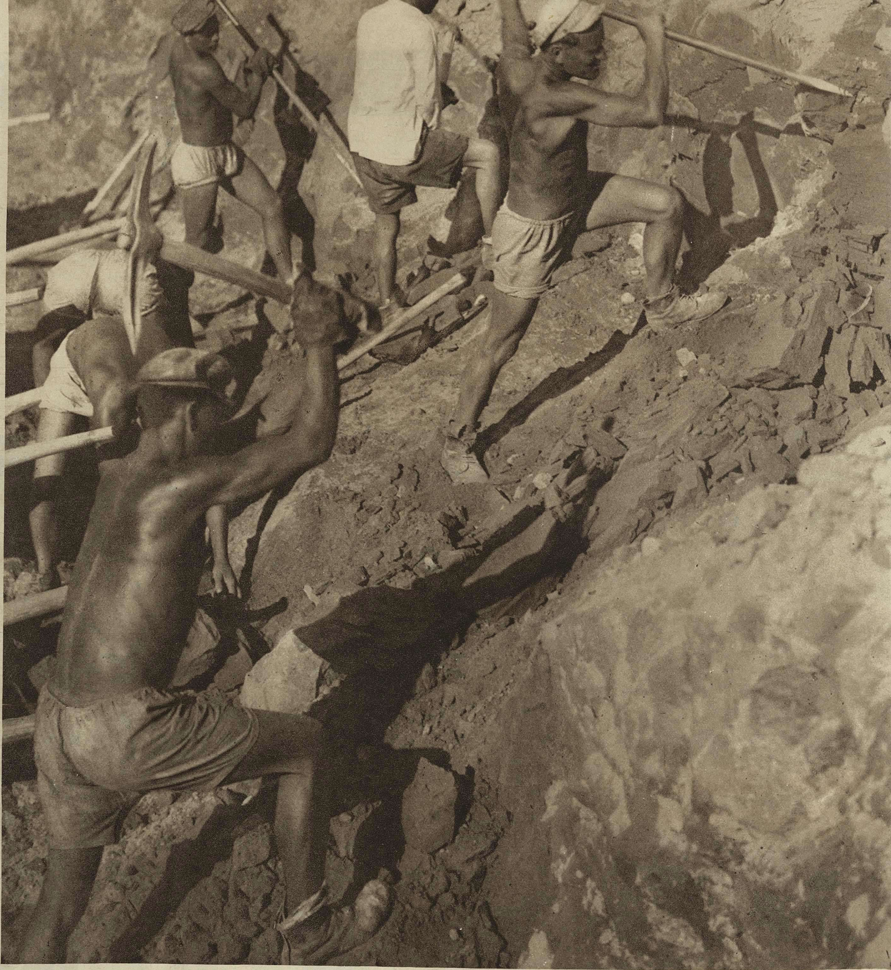
Ударники Вахшстроя за работой.
