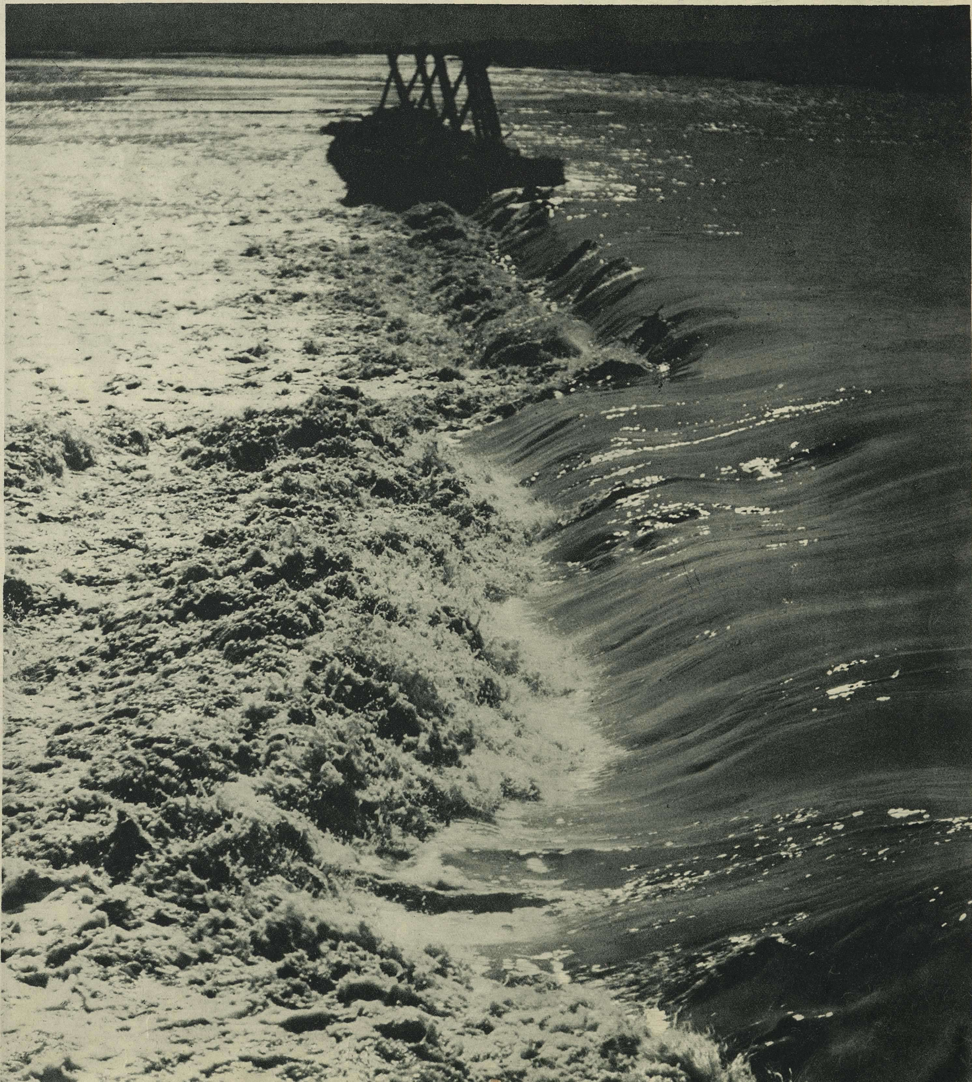
Место постройки головного сооружения Вахшстроя.
