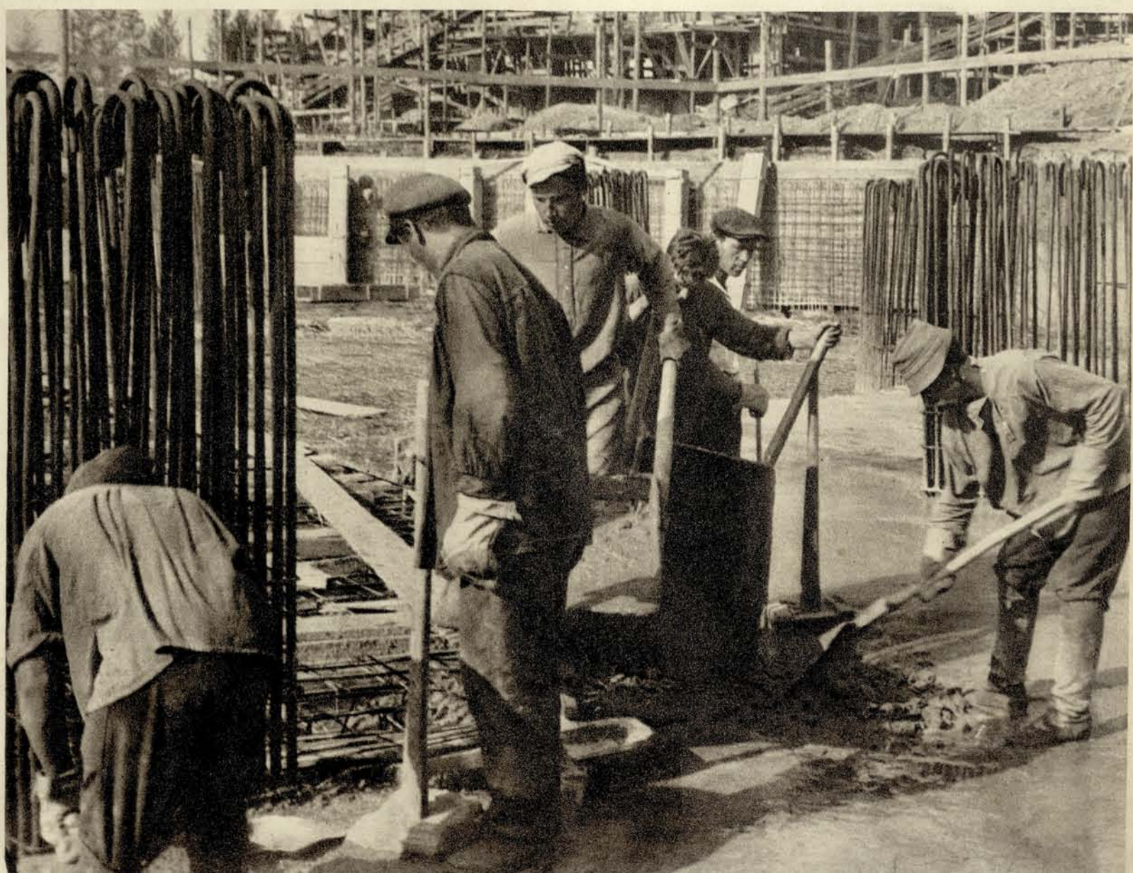
Бригада Филимонова на работах по бетонированию.
