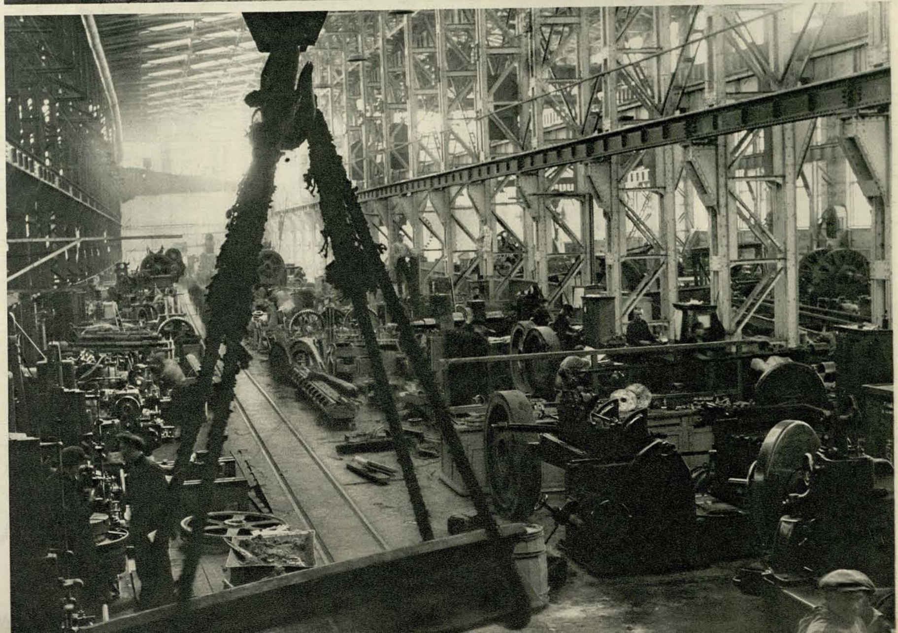
Новый корпус механического цеха.
