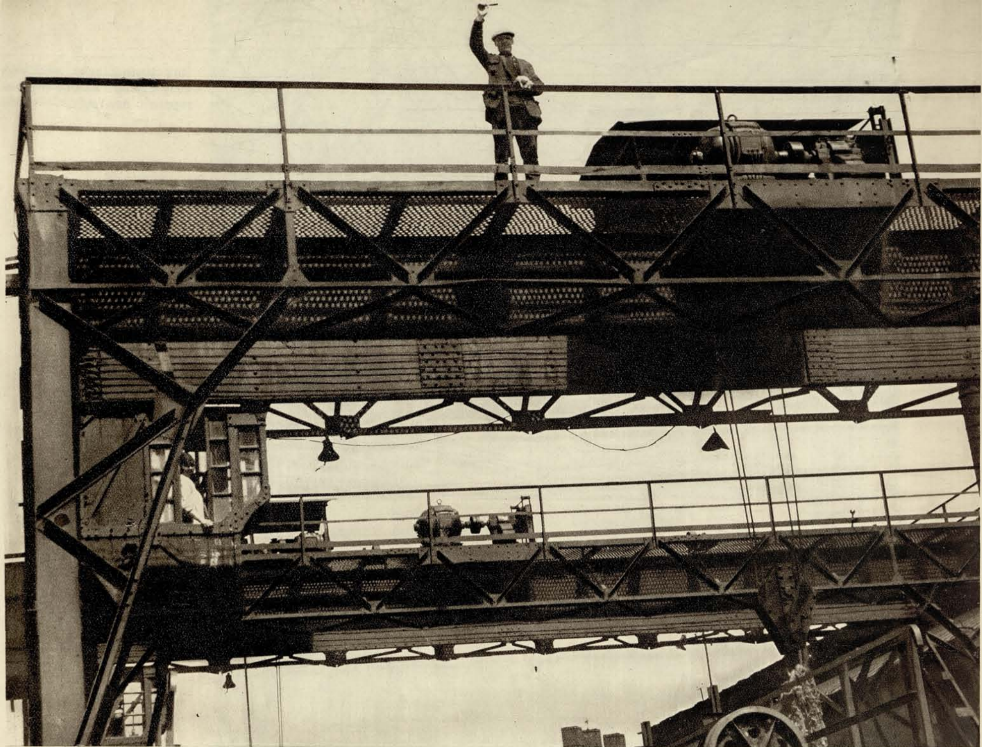
Сборка 125-тонного крана для Кузнецкого завода.
