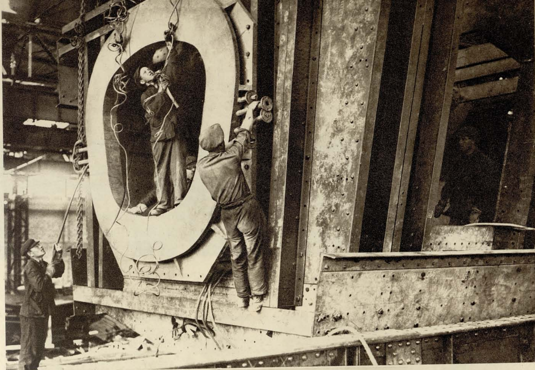
Монтаж печи Вольмана в сталелитейном цеху.
