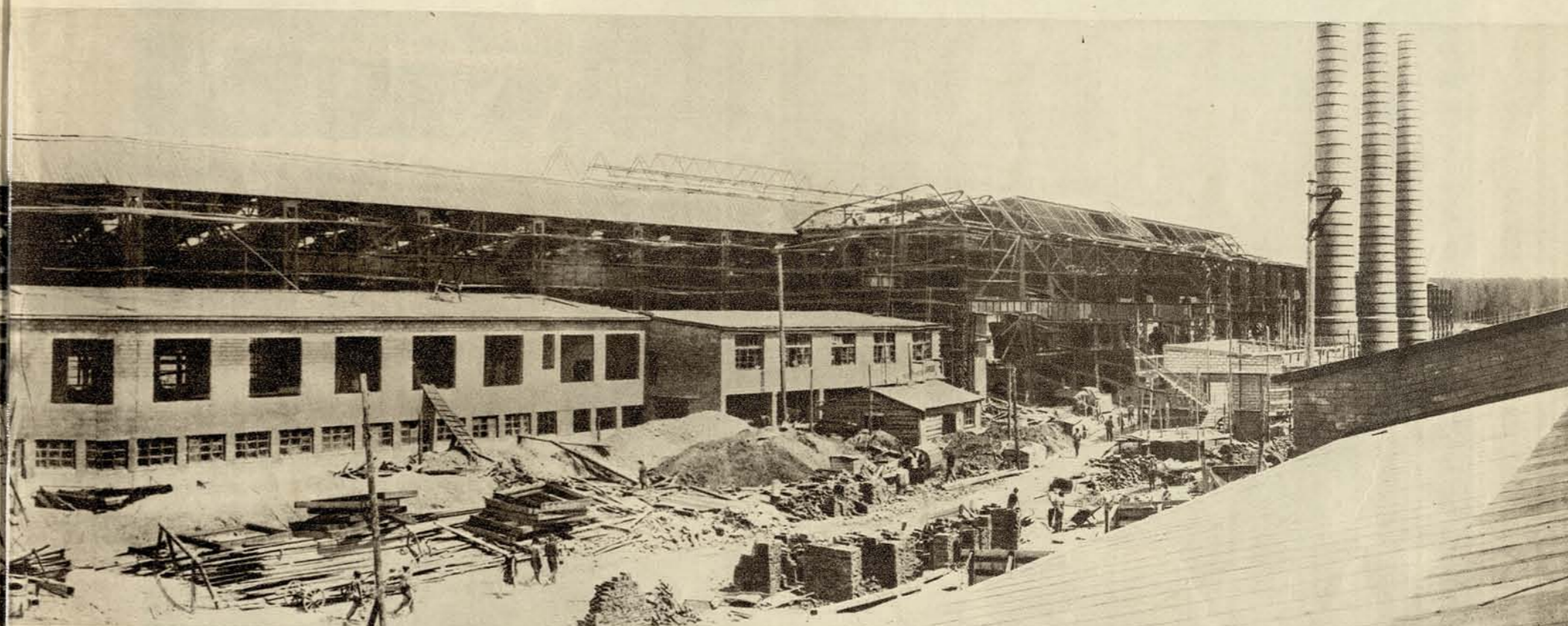
ПАНОРАМА СТАЛЕЛИТЕЙНОГО ЦЕХА.
