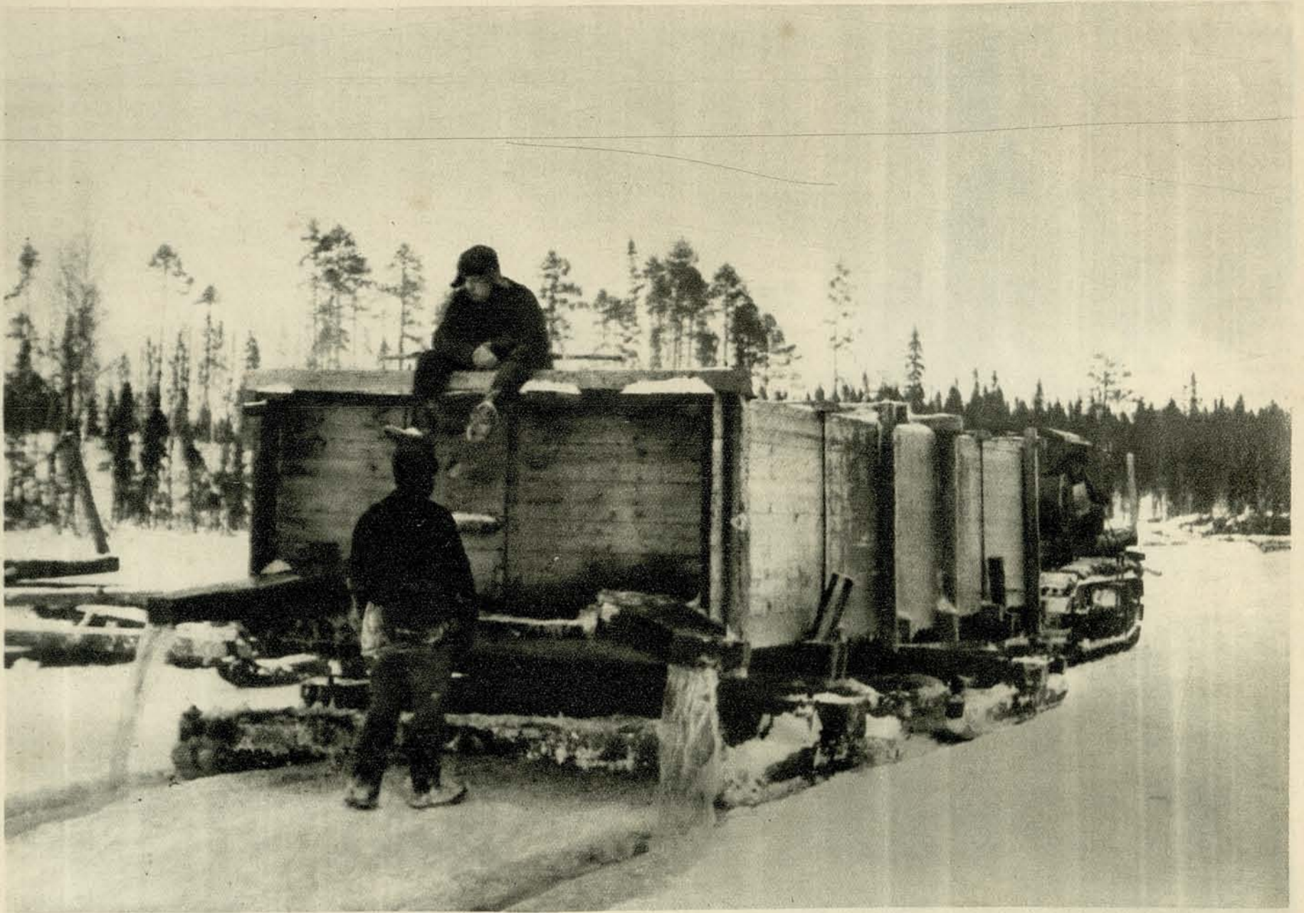
ПОЛИВКА СНЕГА ВОДОЙ. ТАК ДЕЛАЮТ ЛЕДЯНУЮ ДОРОГУ (ОРЛЕЦКАЯ БАЗА)
