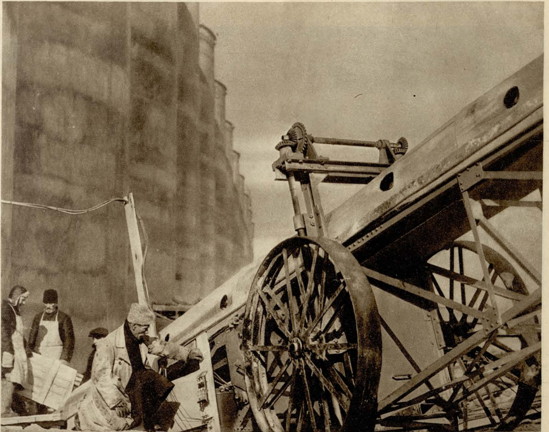
ЛЕНТОЧНЫЙ ТРАНСПОРТЕР ДЛЯ ВЫГРУЗКИ ФОСФОРИТНОЙ МУКИ ИЗ СИЛОСОВ
