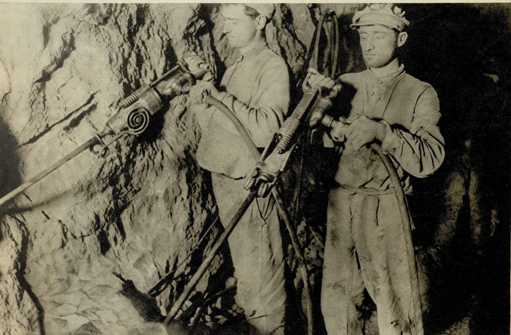
ПЕРЕДВИЖНЫЕ КОМПРЕССОРЫ, ДАЮЩИЕ СЖАТЫЙ ВОЗДУХ В ГЛАВНУЮ ШТОЛЬНЮ ШАХТЫ В ПОСЕЛКЕ АКРОМАРА БУРЕНИЕ ПРИ ПОМОЩИ ПНЕВМАТИЧЕСКИХ МОЛОТКОВ В ГЛАВНОЙ ШТОЛЬНЕ АКРОМАРА
