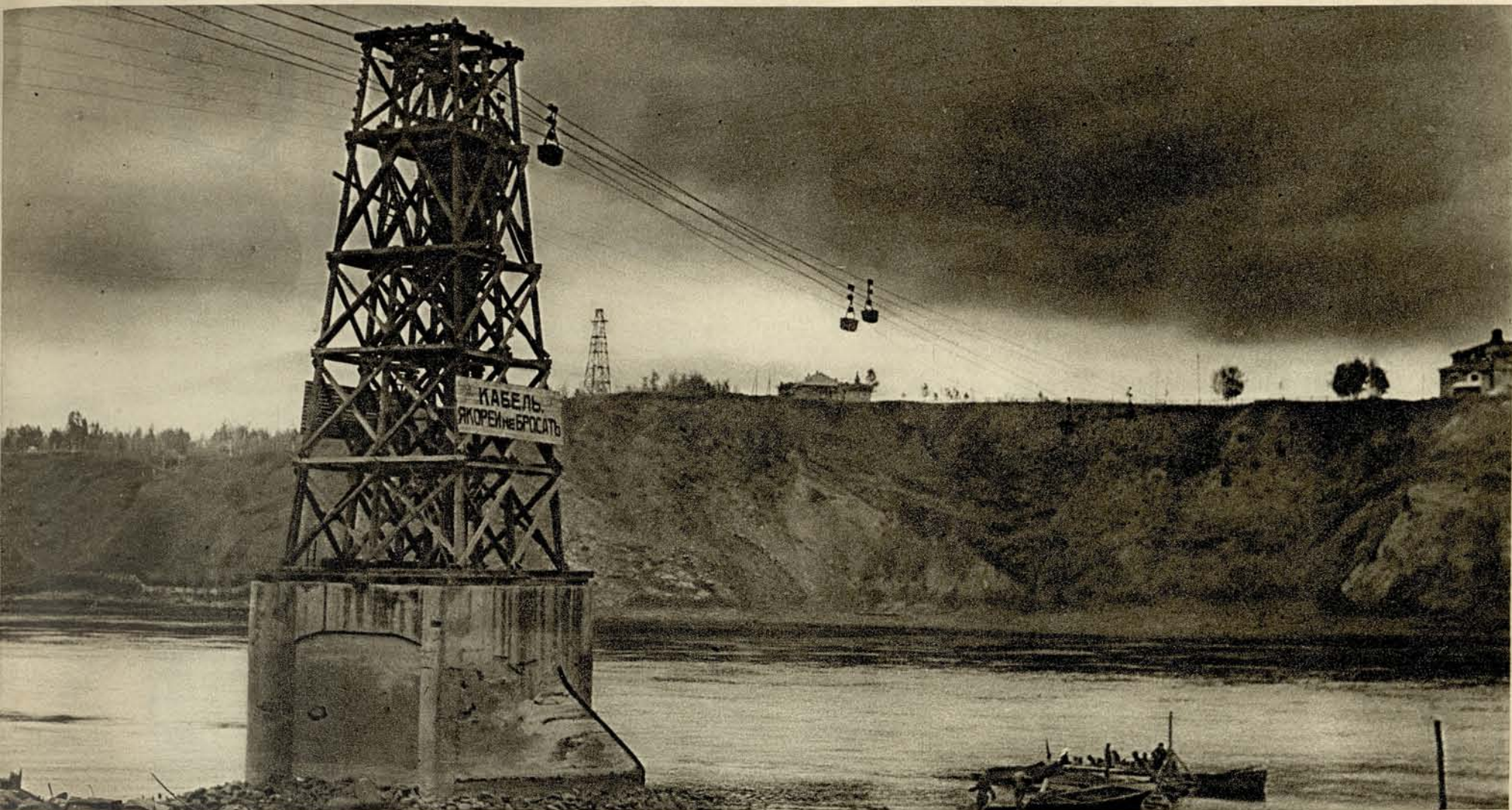
ПОДВЕСНАЯ ДОРОГА С КЕМЕРОВСКОГО РУДНИКА НА ЩЕГЛОВСКИЙ ЗАВОД
