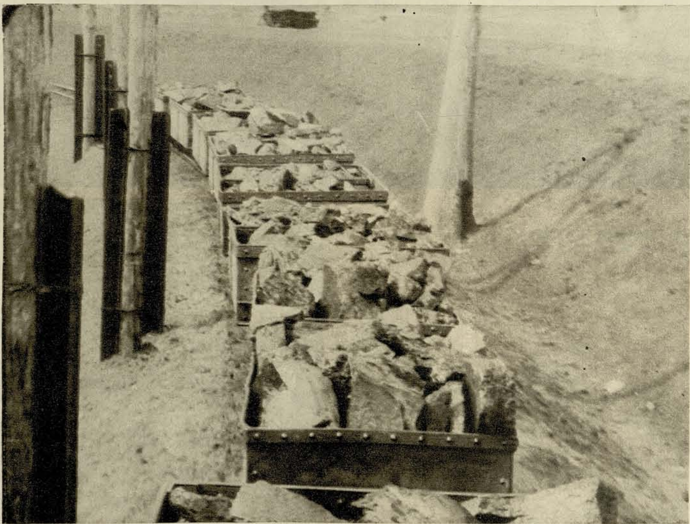
НАДЗЕМНАЯ ОТКАТКА УГЛЯ ЭЛЕКТРОВОЗОМ НА ШАХТЕ ИМ. АРТЕМА
