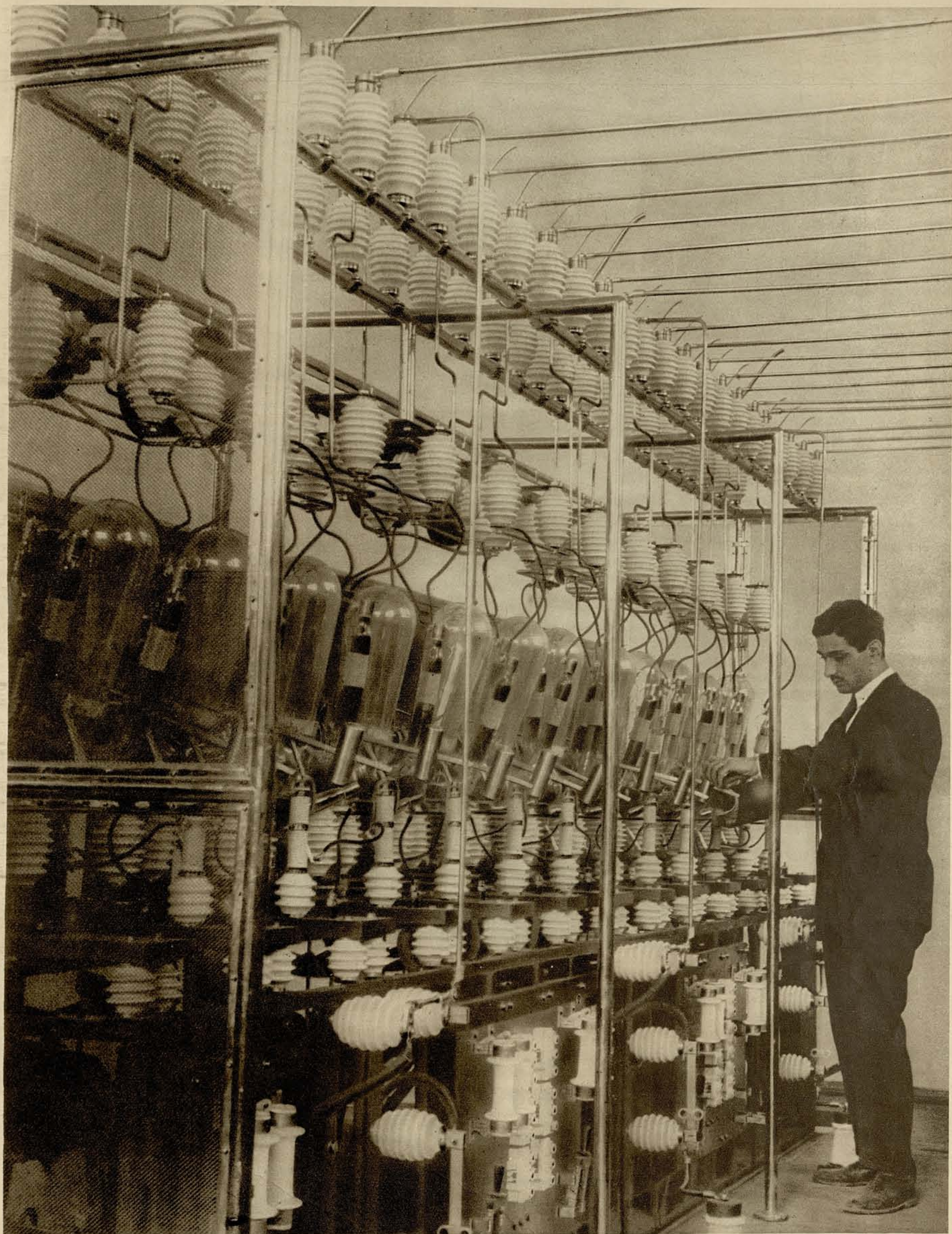
ВЫПРЯМИТЕЛЬНАЯ УСТАНОВКА С РТУТНЫМИ ВЫПРЯМИТЕЛЯ- МИ НА РАДИОСТАНЦИИ ВЦСПС
