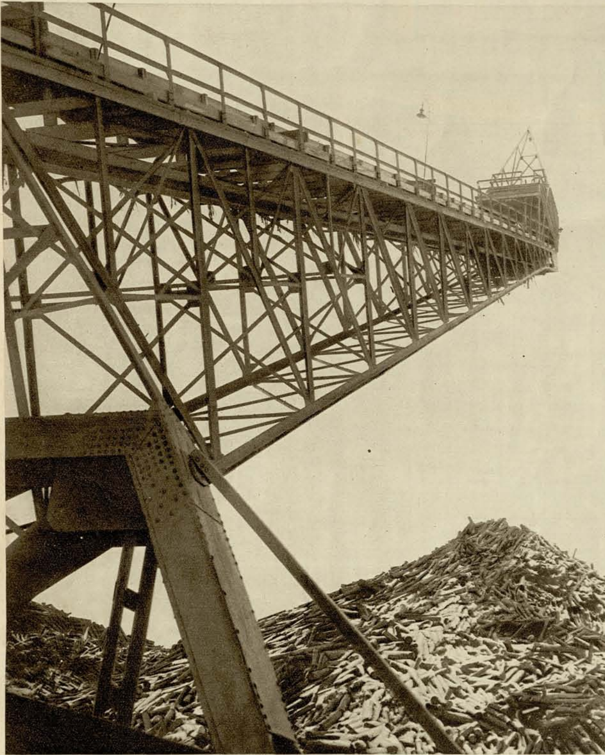
СТАНКЕР ДЛЯ СНЯТИЯ КОРЫ И ВЫКАТКИ БАЛАНСОВ (МЕЛКИХ БРЕВЕН, ИДУЩИХ В ПЕРЕРАБОТКУ)
