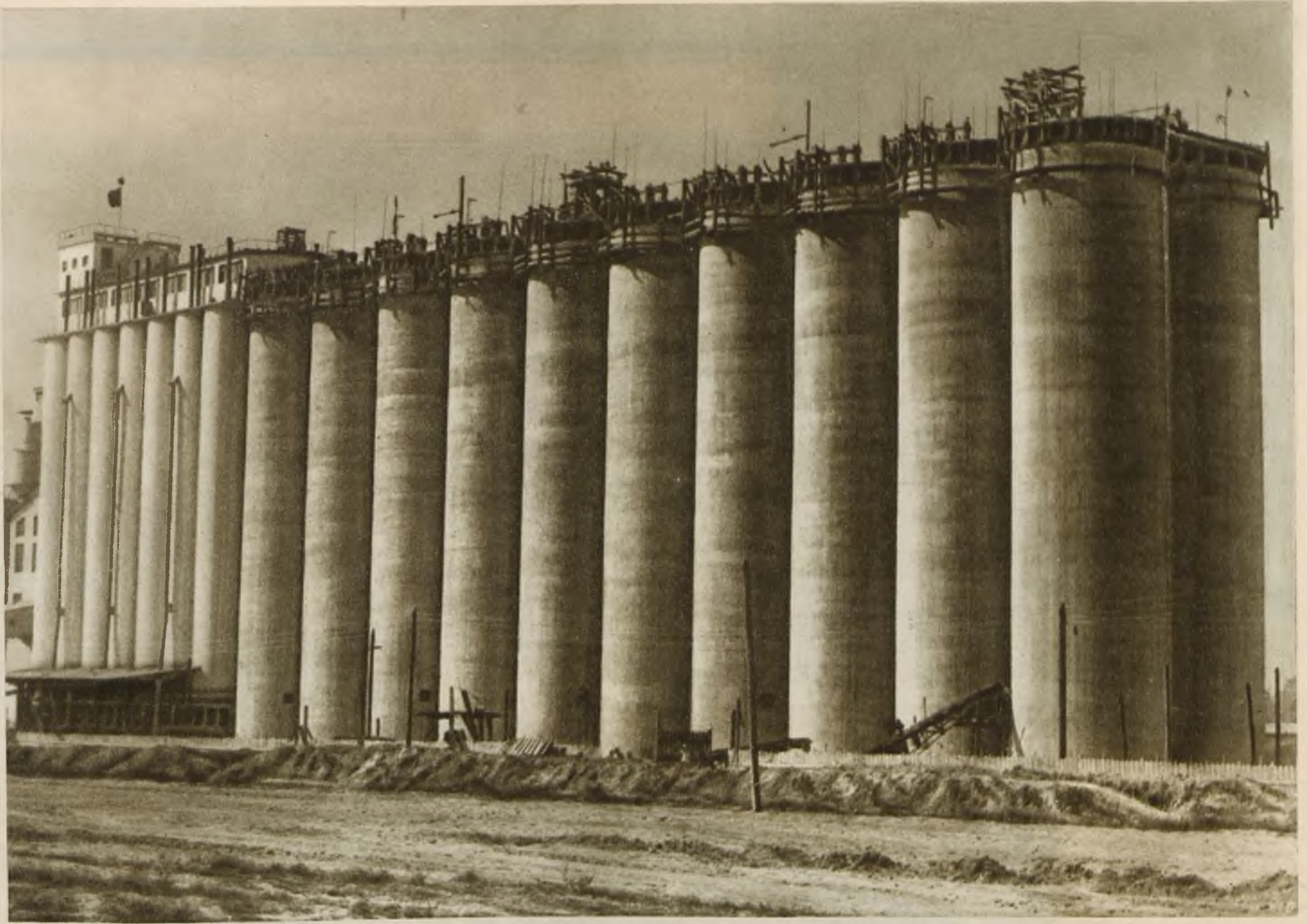
ТАШКЕНТСКИЙ ЭЛЕВАТОР ЕМКОСТЬЮ В 34 ТЫСЯЧИ ТОНН ЗЕРНА. ПРИ ЭЛЕВАТОРЕ СТРОИТСЯ МОЩНАЯ ЭЛЕКТРОМЕЛЬНИЦА
