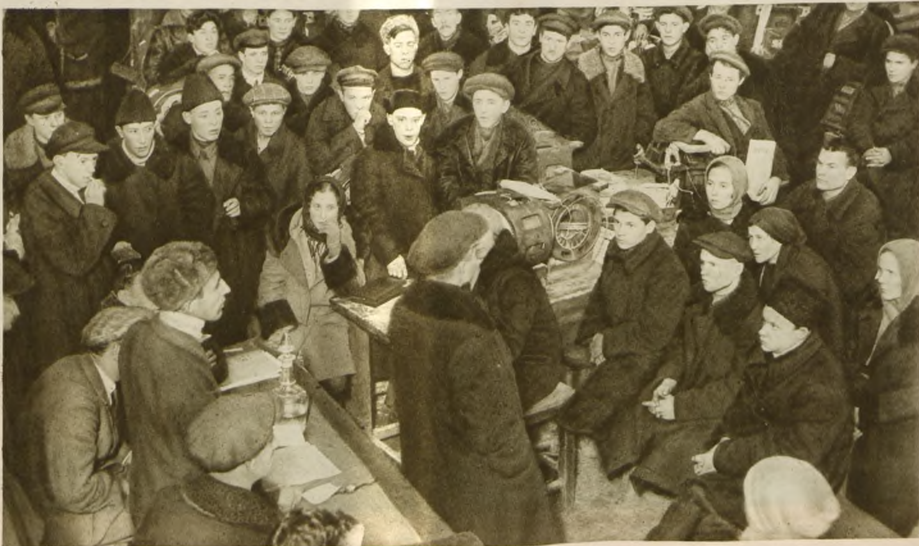
ПРОВОДЫ «ДВАДЦАТИПЯТИТЫСЯЧНИКОВ» НА ЭЛЕКТРОЗАВОДЕ ИМ. ЛЕПСЕ В МОСКВЕ
