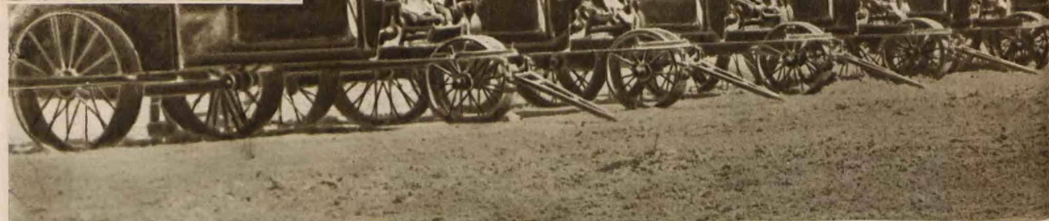
СВЫШЕ ДВУХСОТ КОМБАЙНОВ РАБОТАЮТ НА ПОЛЯХ «ГИГАНТА». РАБОТАЯ В ДВЕ СМЕНЫ, КОМБАЙН ОБРАБАТЫВАЕТ В СРЕДНЕМ 25 ГЕКТАРОВ В ДЕНЬ: ОН ЖНЕТ, МОЛОТИТ И ОЧИЩАЕТ ЗЕРНО
