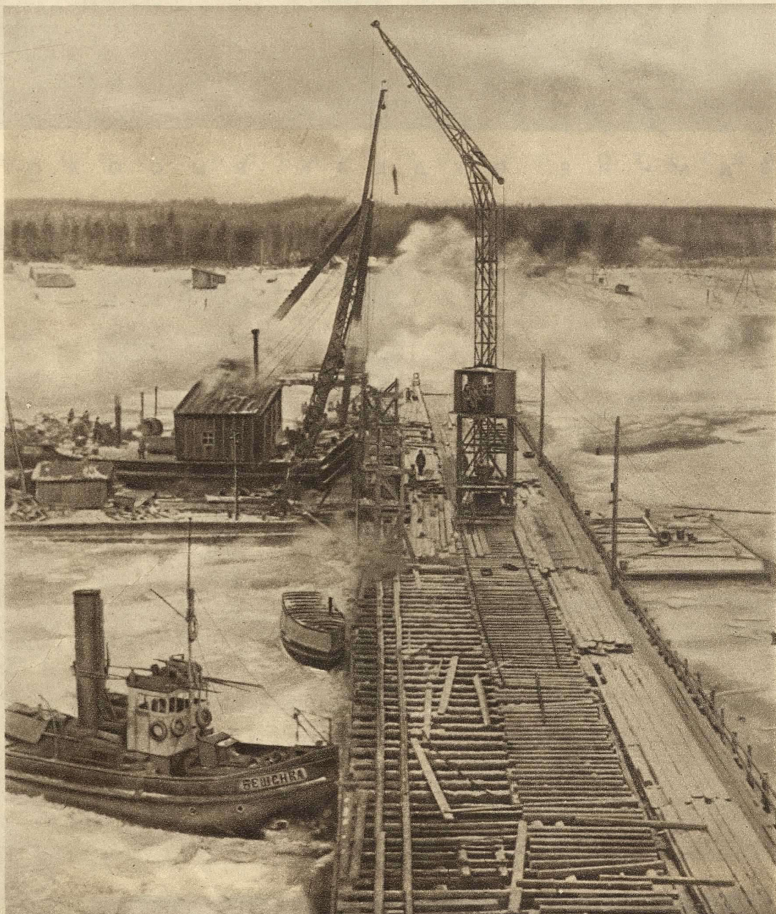
РАБОТЫ ПО СООРУЖЕНИЮ ПЛОТИНЫ НА РЕКЕ СВИРИ
