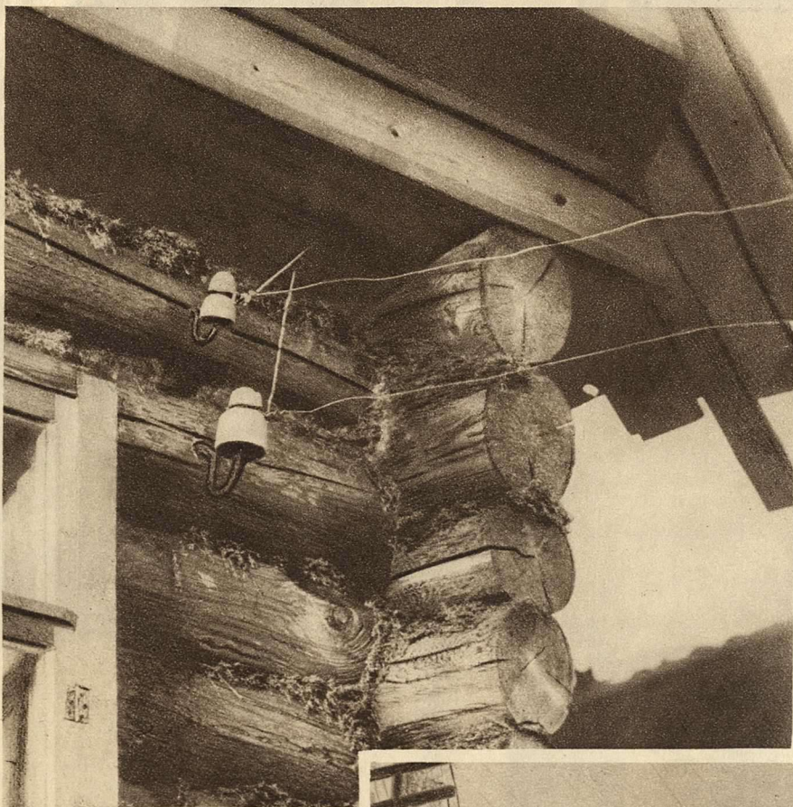
ВВОД ЭЛЕКТРОПРОВОДОВ В ИЗБУ
