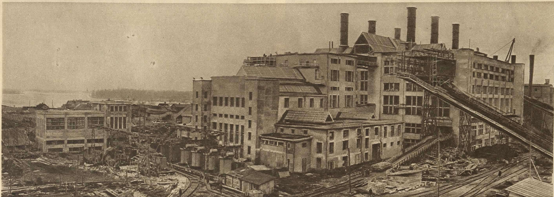
ОБЩИЙ ВИД ЖЕЛЕЗОБЕТОННОГО ЗДАНИЯ ЭЛЕКТРОСТАНЦИИ «КРАСНЫЙ ОКТЯБРЬ»
