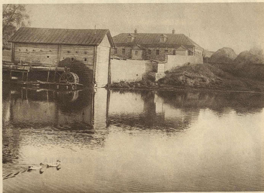
ЧЛЕНЫ КОЛХОЗА «КРАСИВАЯ МЕЧЬ» ТУЛЬСКОГО ОКРУГА ИСПОЛЬЗОВАЛИ ВОДЯНУЮ МЕЛЬНИЦУ ДЛЯ ЭЛЕКТРОСНАБЖЕНИЯ СЕЛА И КОЛХОЗНОГО КРАХМАЛЬНОГО ЗАВОДА
