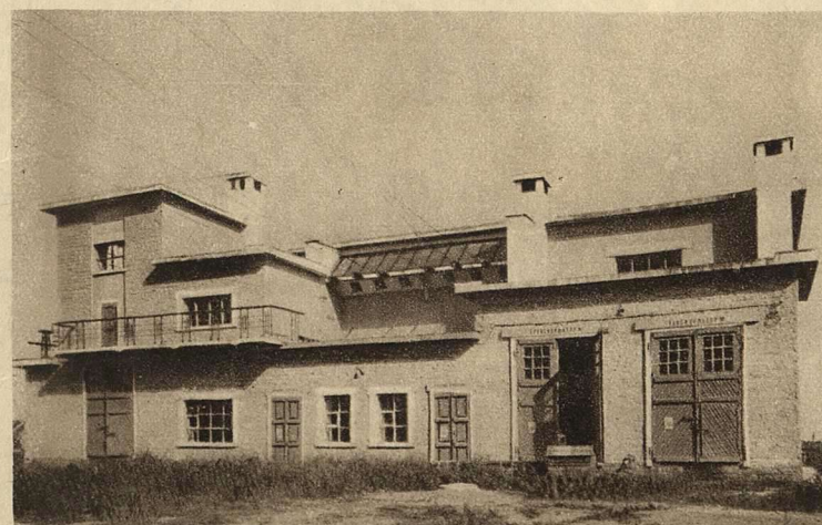
РОВЕНЕЦКАЯ ПОНИЗИТЕЛЬНАЯ ПОДСТАНЦИЯ ШТЕРОВСКОЙ СТАНЦИИ
