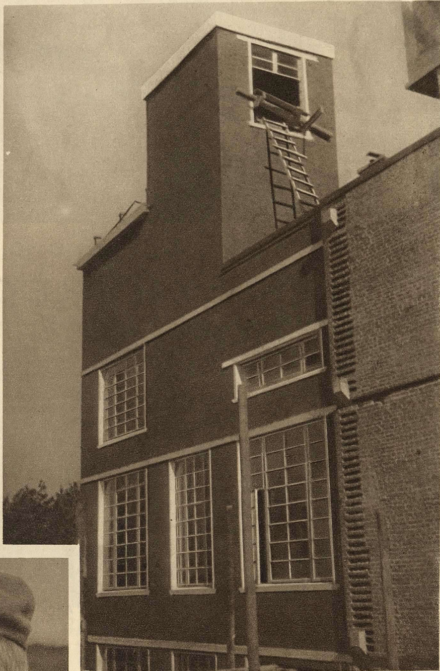
ВИД ОДНОГО КРЫЛА ЭЛЕКТРОСТАНЦИИ НА ТОРФЯНОЙ ОПЫТНОЙ СТАНЦИИ ИНСТОРФА
