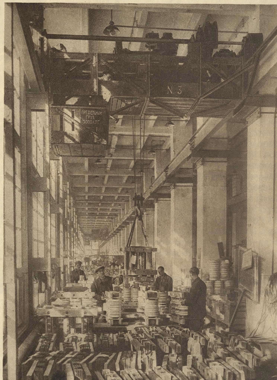
ОДИН ИЗ ПРОЛЕТОВ СБОРОЧНОЙ МАСТЕРСКОЙ ТРАНСПОРТНОГО ОТДЕЛА. ЭЛЕКТРИЧЕСКИЙ КРАН ПОДАЕТ РАБОЧИМ ЧАСТИ ТРАНСФОРМАТОРОВ
