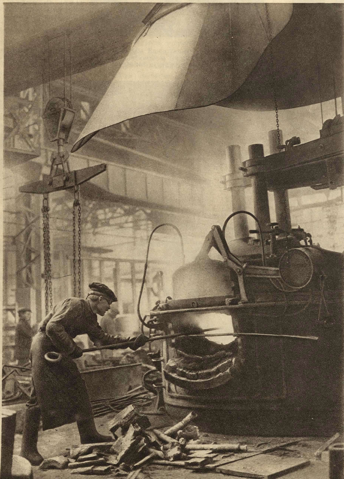
НОВАЯ ЭЛЕКТРИЧЕСКАЯ ПЕЧЬ ДЛЯ СТАЛИ, УСТАНОВЛЕННАЯ В ЛИТЕЙНОЙ «ДИНАМО»
