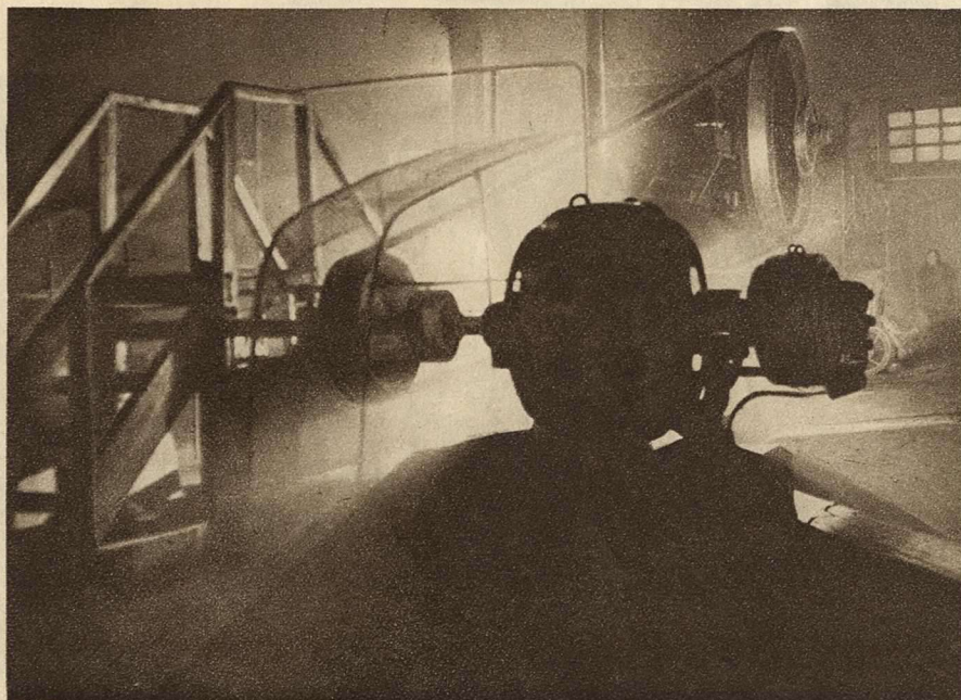
ЭЛЕКТРОСТАНЦИЯ В 200 КИЛОВАТТ В СЕЛЕ ЛИХОСЛАВЬ ТВЕРСКОГО ОКРУГА. СТАНЦИЯ ДАЕТ ЭЛЕКТРОЭНЕРГИЮ 8 СЕЛАМ И МЕЛЬНИЦЕ
