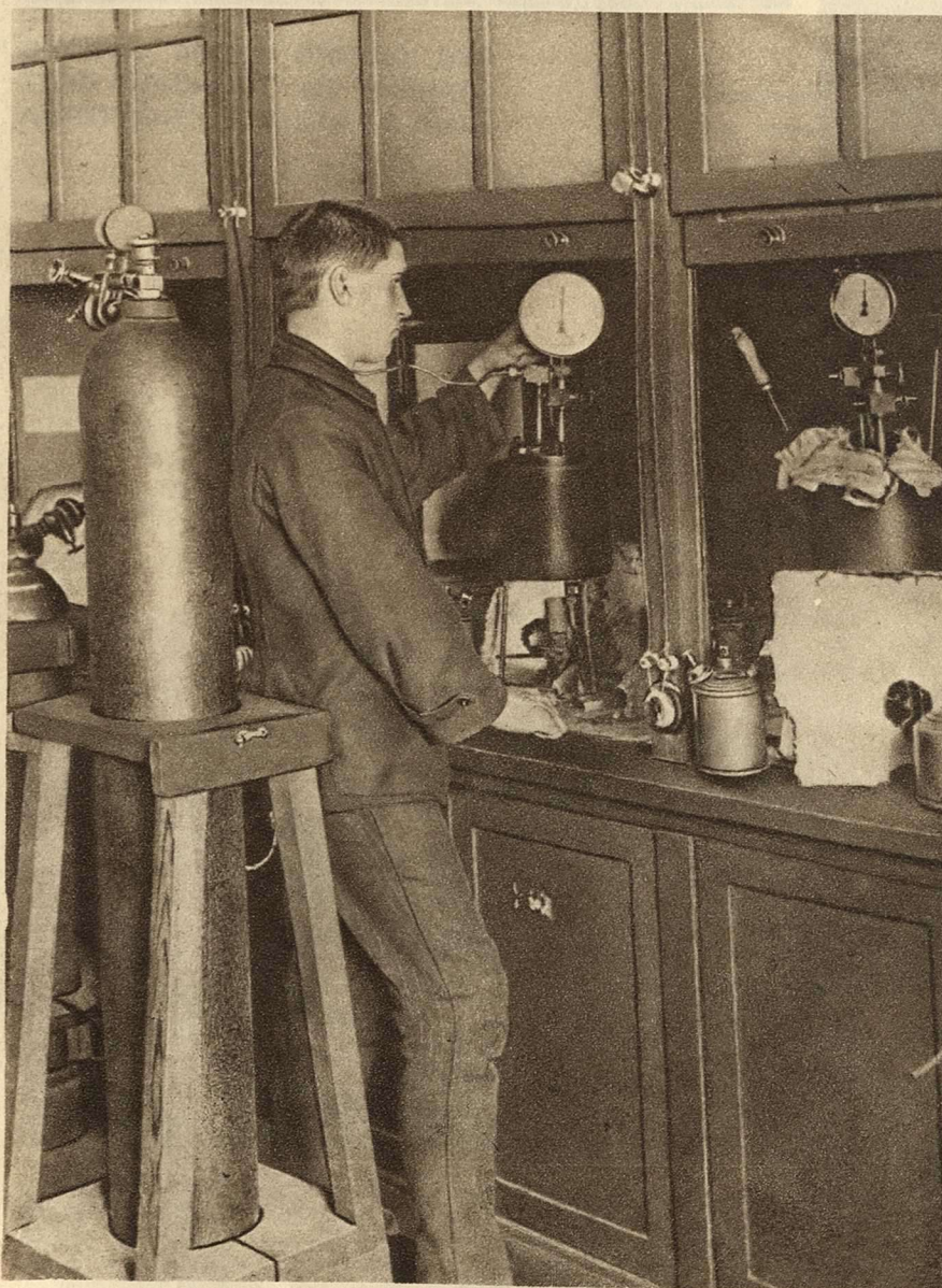
ИНЖЕНЕР ИНСТИТУТА ТОВ. БУТКОВ ОКОЛО ИЗОБРЕТЕННОЙ ИМ «БОМБЫ» — АППАРАТА ДЛЯ ИСПЫТАНИЯ УСТОЙЧИВОСТИ ТРАНСФОРМАТОРНЫХ МАСЕЛ
