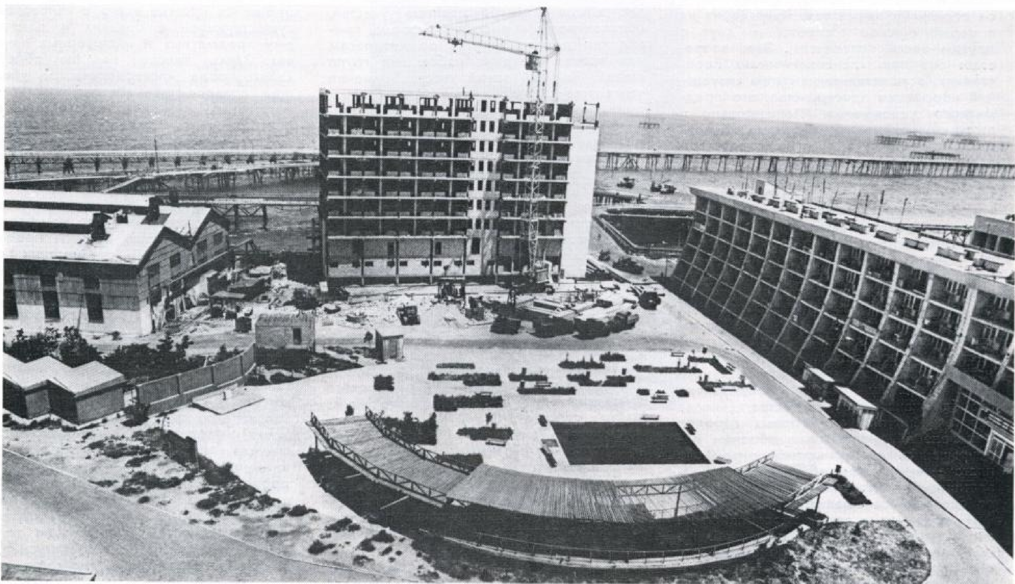
4. Центральная площадь. Справа — пятиэтажный комплекс вахтовых помещений, прямо — строящийся жилой корпус для женщин, в центре — участок теневого навеса
