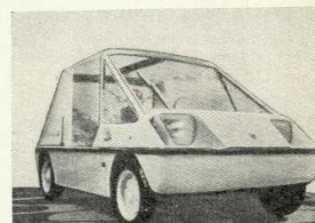
10. FAM. Вмещает до четырех пассажиров с багажом при длине 3504 мм. Обладает хорошей маневренностью и обзорностью.
