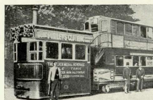
Испериментальный двухвагонный состав рамвайной электрической компании Поттери, 1924 год. Однаковые по конструкции вагоны имеют смыкающиеся пристройки для перехода из вагона в вагон. Скользящий верхний токоприемник — основной иззнак современного трамвая.
