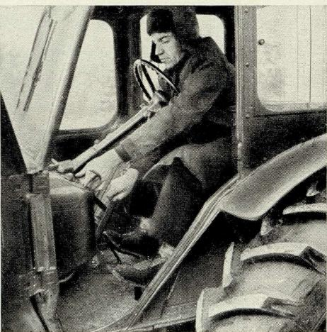
венно под сиденьем. Рычаг подачи топлива, которым при реверсивной передаче приходится пользоваться очень часто, расположен неудобно — под рулевым колесом слишком близко от края сиденья (200 мм) и спинки сиденья (540 мм) (фото 4).
