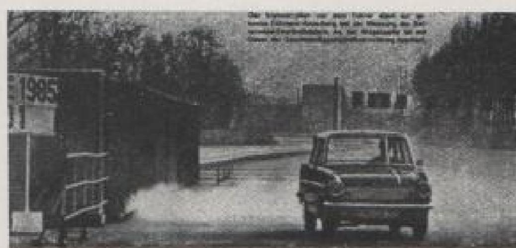
6. Имитация бокового ветра (AMS). Ветер создается вентиляционной установкой.
