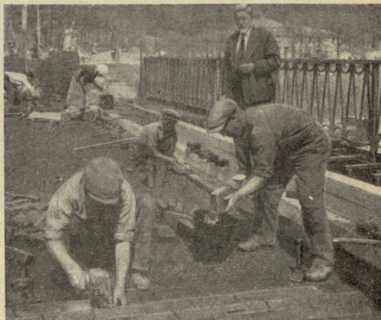
Рис. 3. Укладка плит в проезжую часть Высокоязузского моста.
