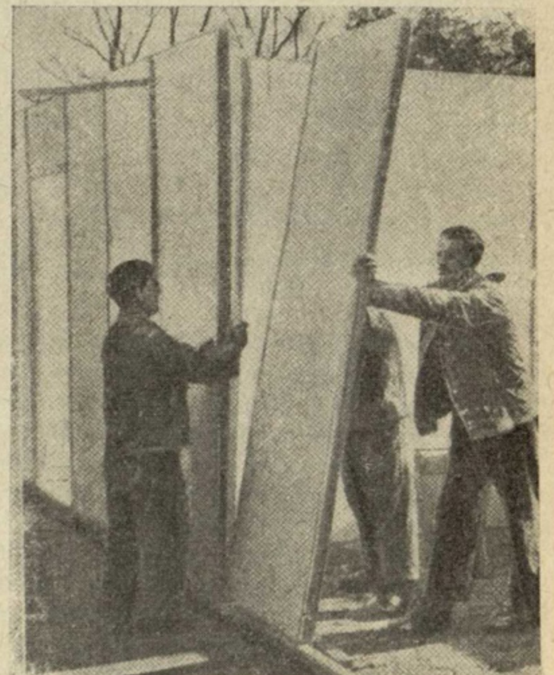
Строительство барака из газогипсовых плит.
