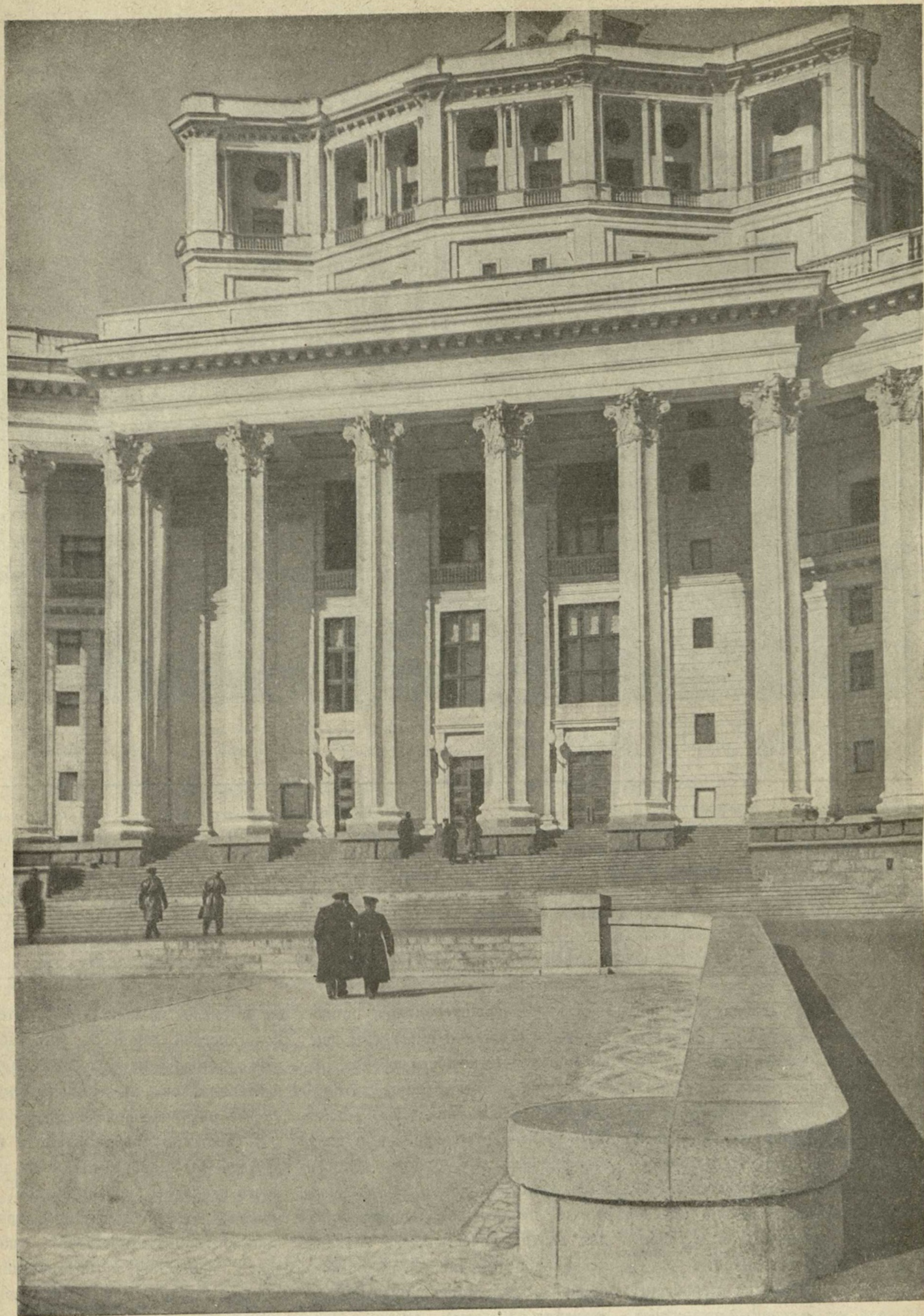
Фасад со стороны площади Коммуны.
