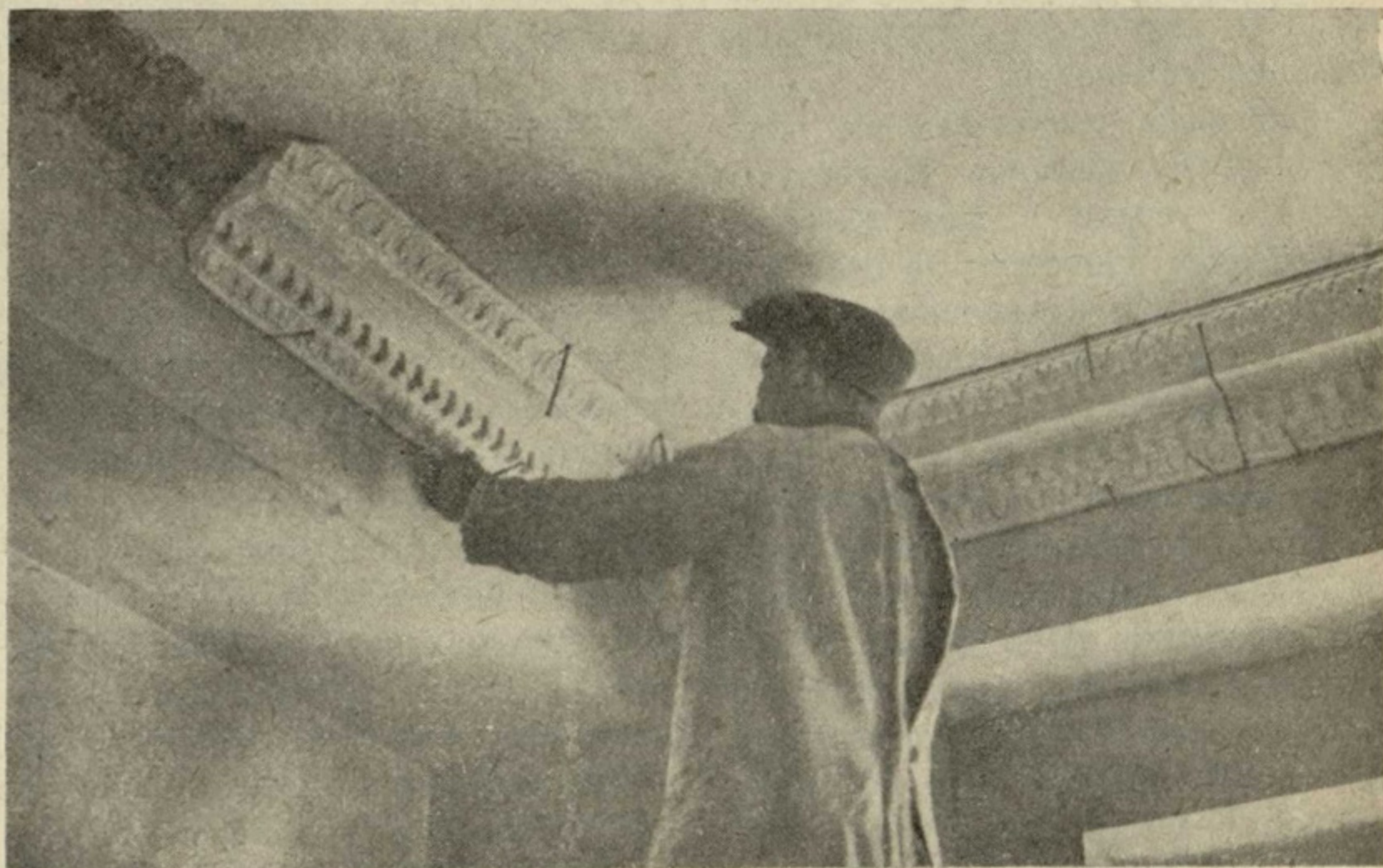
Рис. 10. Монтаж сборных карнизов (строительство корпуса 11-а на Б. Калужской улице).
