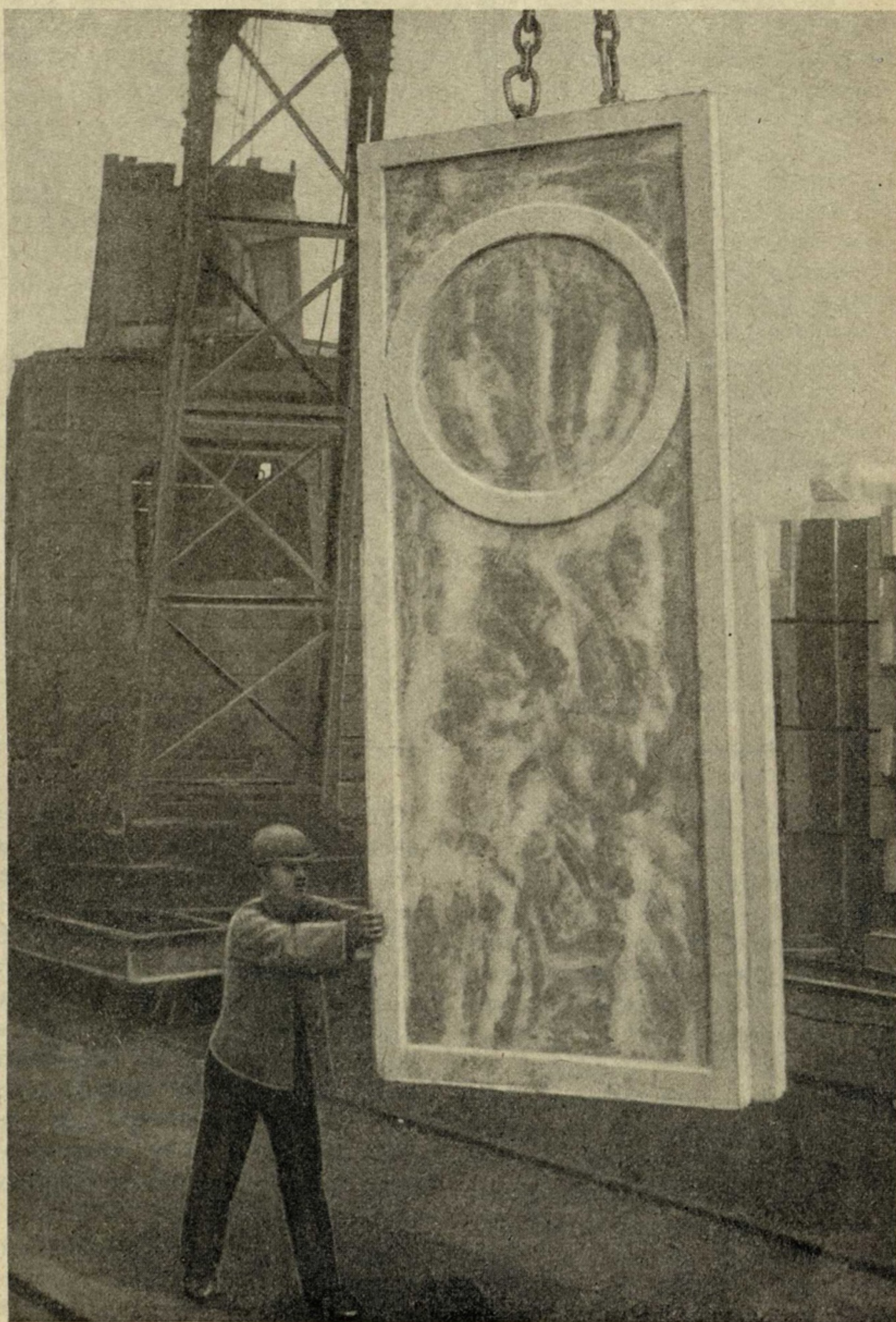
Рис. 1. Подъем блока-простенка с помощью башенного крана.
