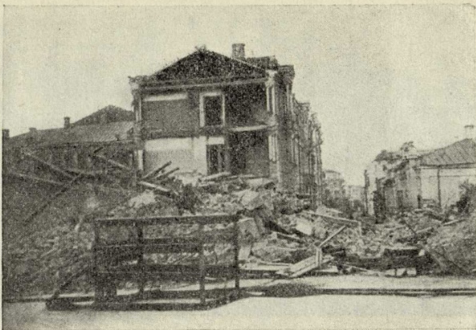
Рис. 9. Дом № 37 по улице Горького после обрушения предварительно отрезанной передней части.
