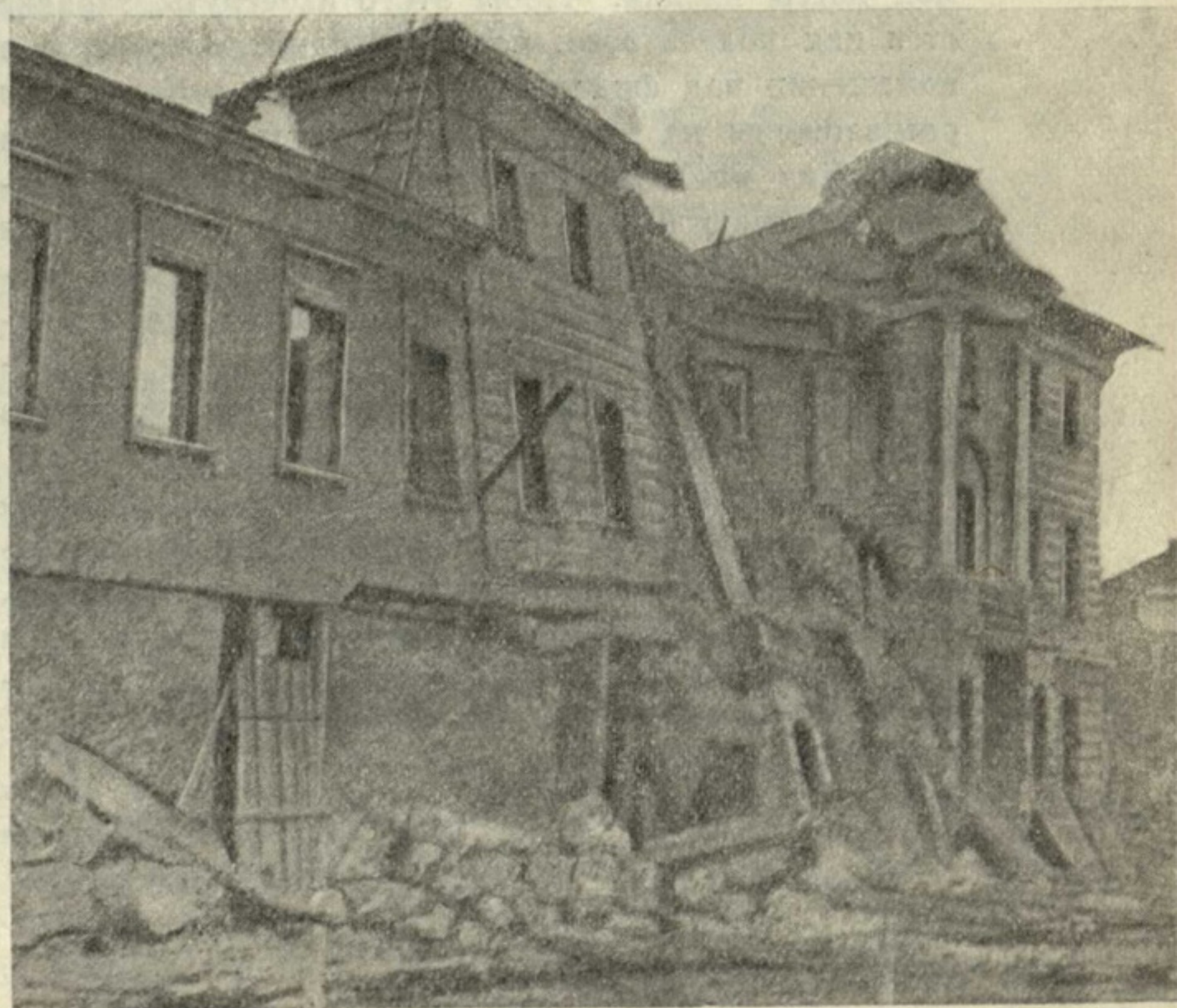
Рис. 8. Подбитые взрывом, не вполне обрушенные части дома № 34, удерживаемые оставшимися несущими связями.
