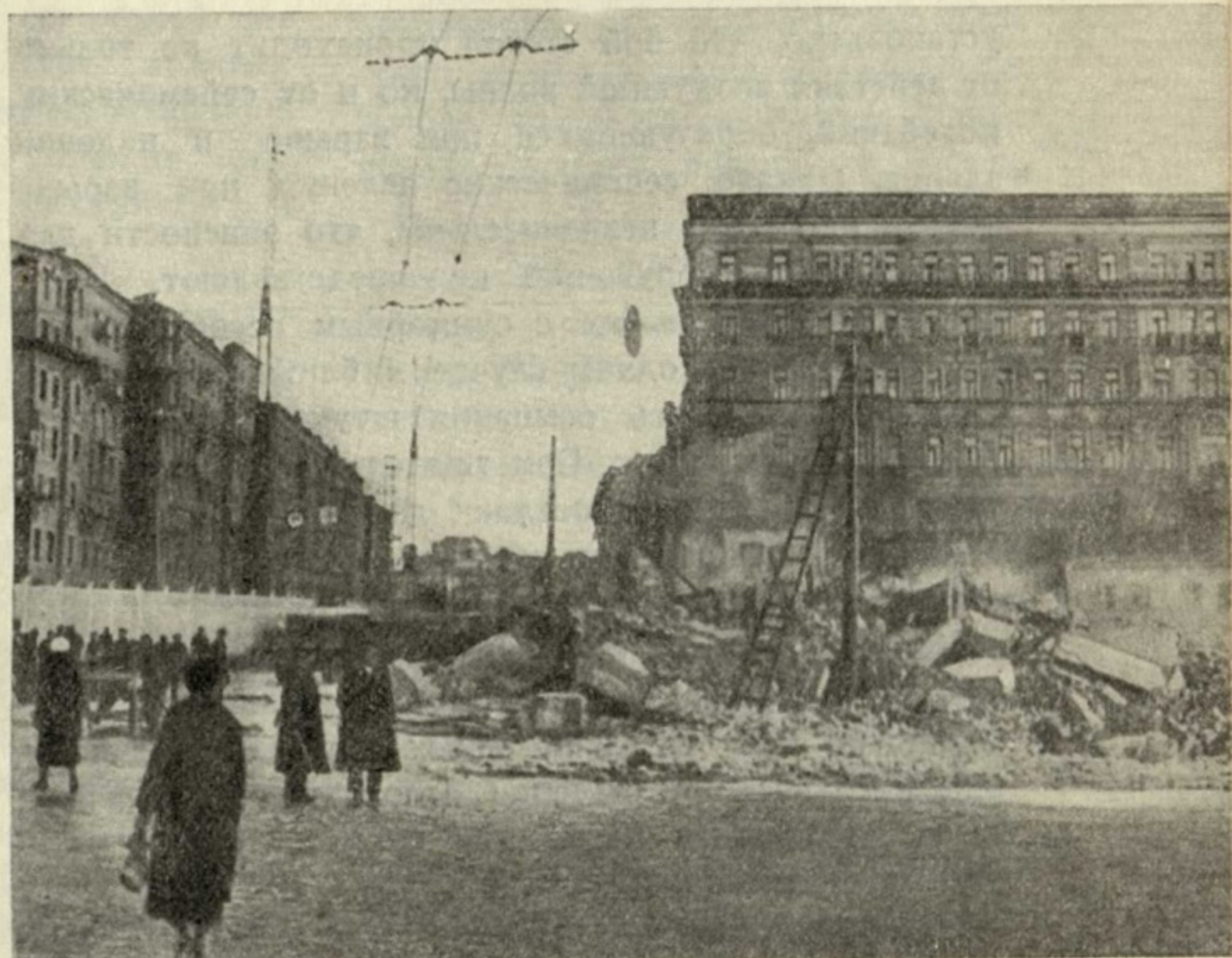
Рис. 7. Участок улицы Горького после обрушения дома № 34.
