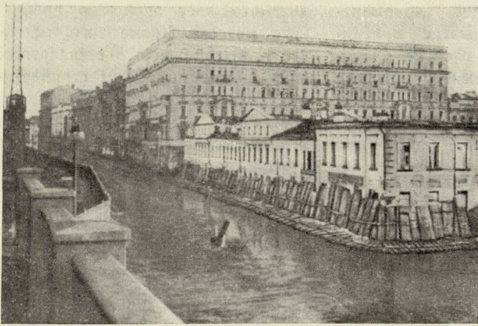
Рис. 2. Дом № 34 по улице Горького, подготовленный к взрыву. На переднем плане видны щиты вокруг здания и амортизаторы над сооружениями подземного хозяйства.
