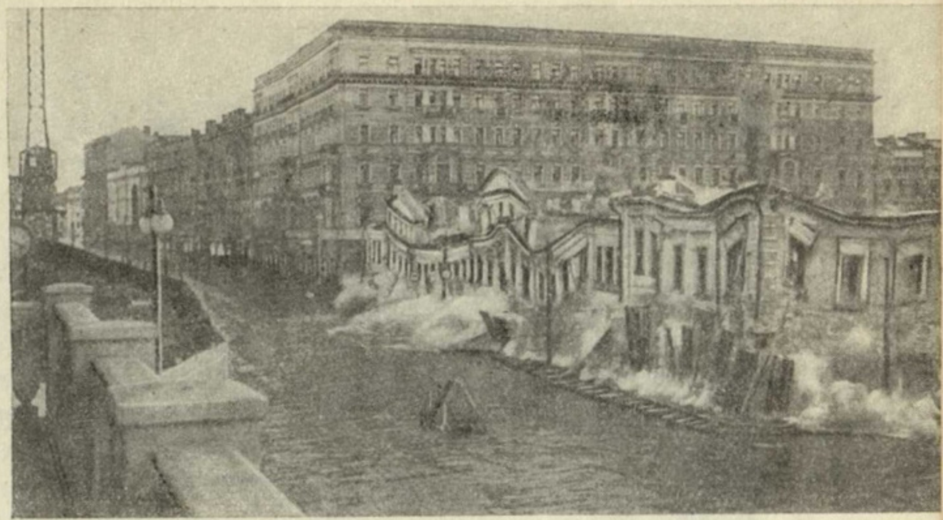
Рис. 6. Дом № 34 в первый момент обрушения на собственное основание.
