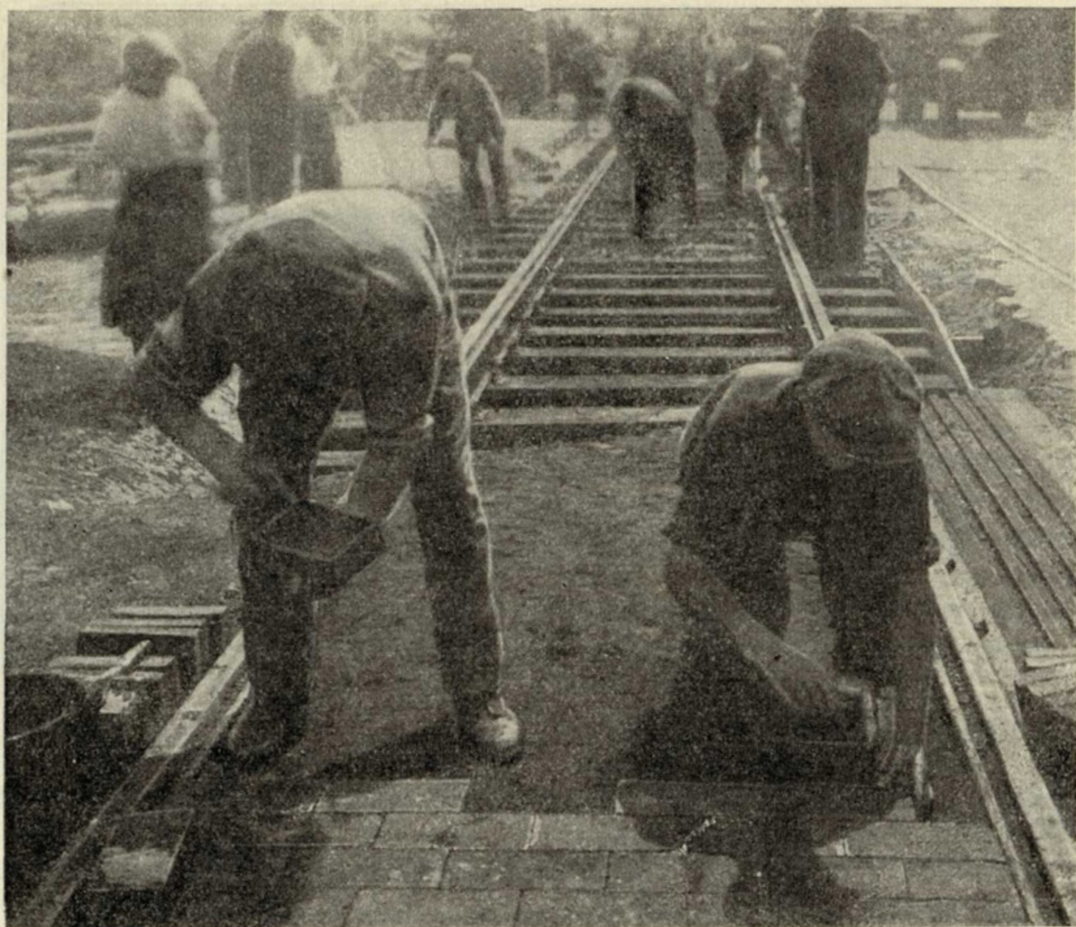
Рис. 10. Укладка асфальтовых плит в путях трамвая.
