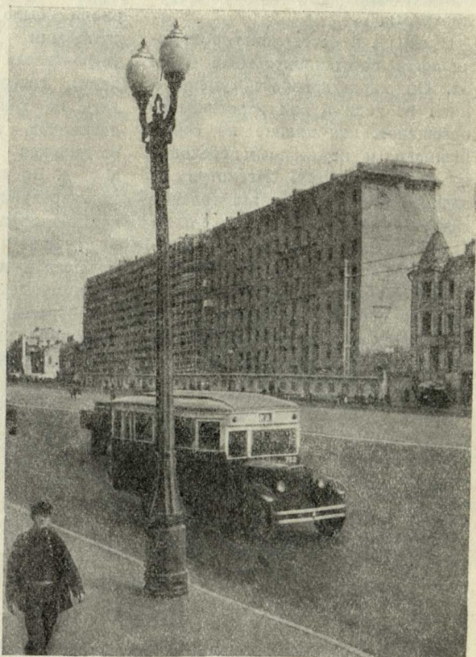
Осветительная арматура типа «Вашингтон», установленная на улицах Садового кольца.
