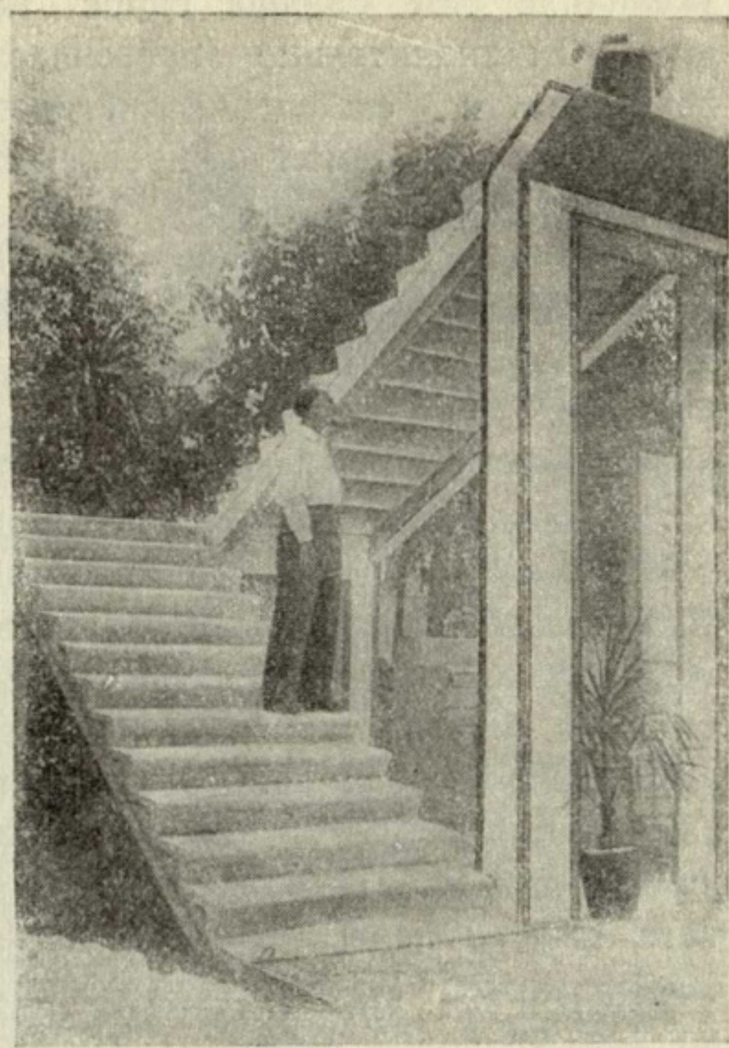
Монолитный лестничный марш из ступеней с цилиндрической пустотой.
