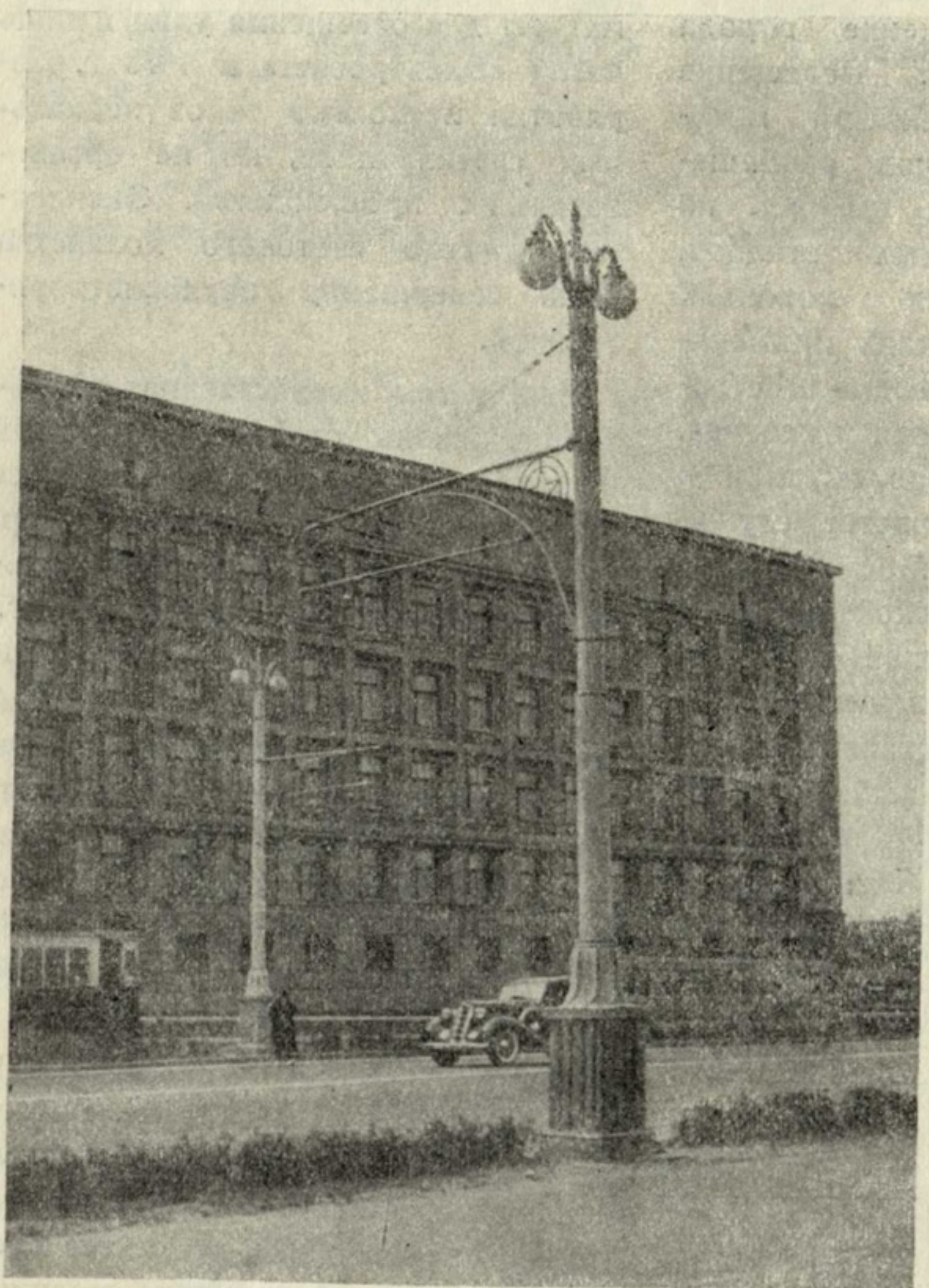
Осветительная шаровая арматура типа «МЗ», установленная в 1939 г. на Ярославском шоссе.
