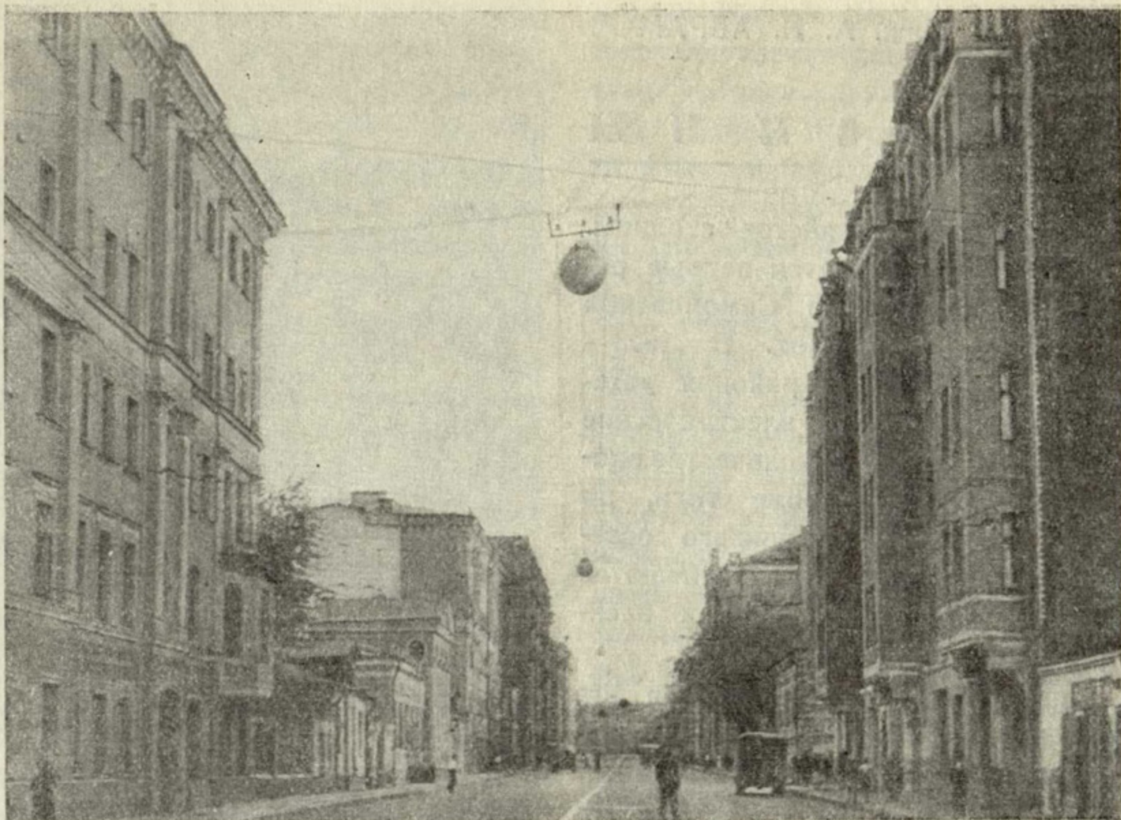
Осветительная арматура типа «АКХ-12» на Б. Якиманке.
