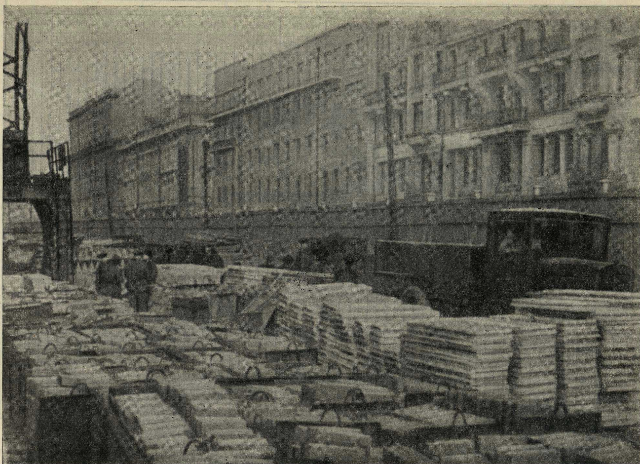
Рис. 5. Кирпич в контейнерах и штабеля сборных железобетонных изделий и перегородочных плит на стройплощадке корпуса «В».
