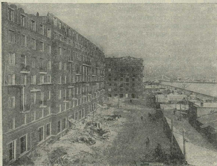
Поточно-скоростное строительство жилых домов на Фрунзенской набережной. Корпус 15 и 14-й.
