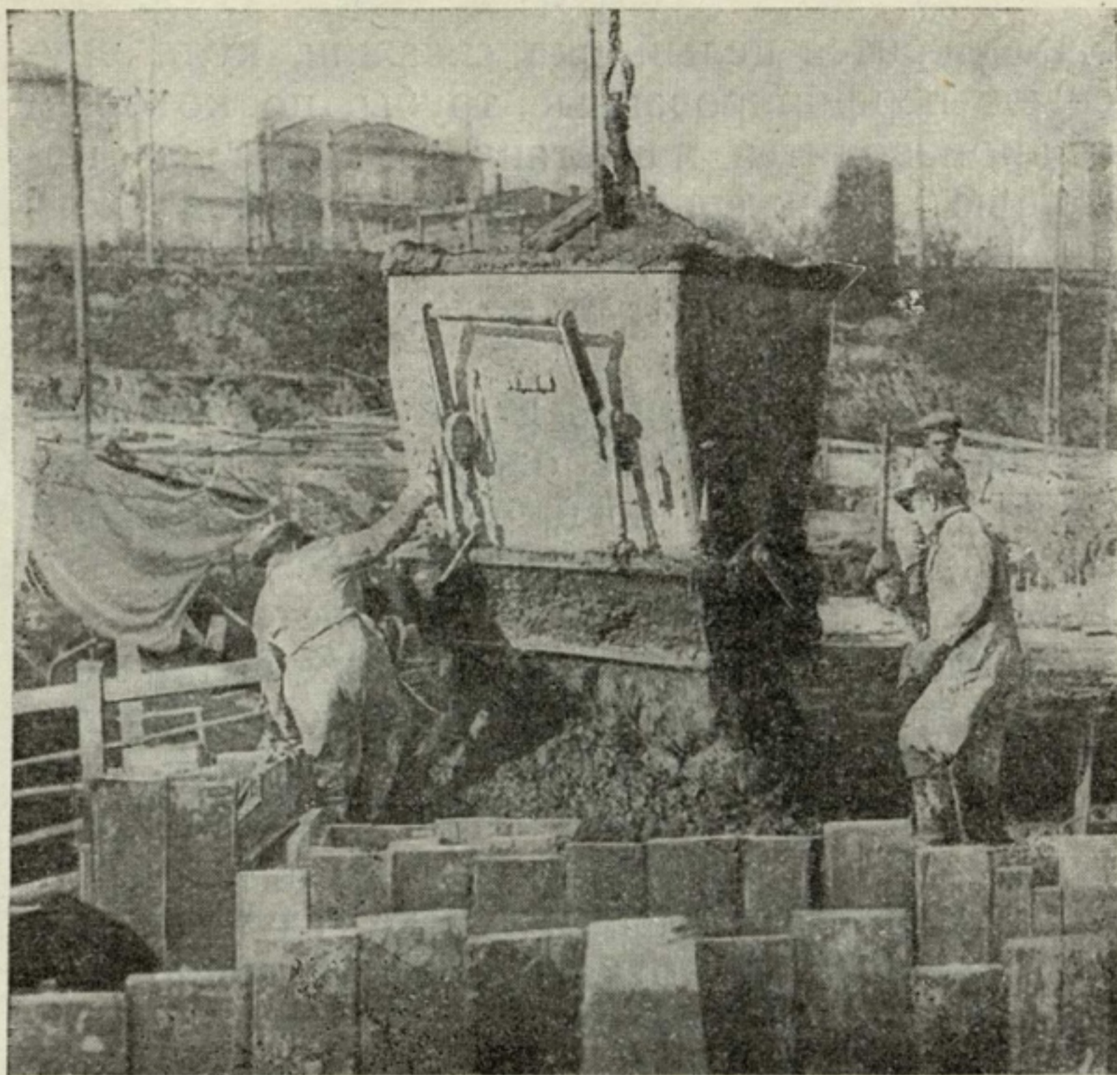
Рис. 9. Выгрузка бетона из бадьи емкостью 1,65 м 3 в блок фундаментов.
