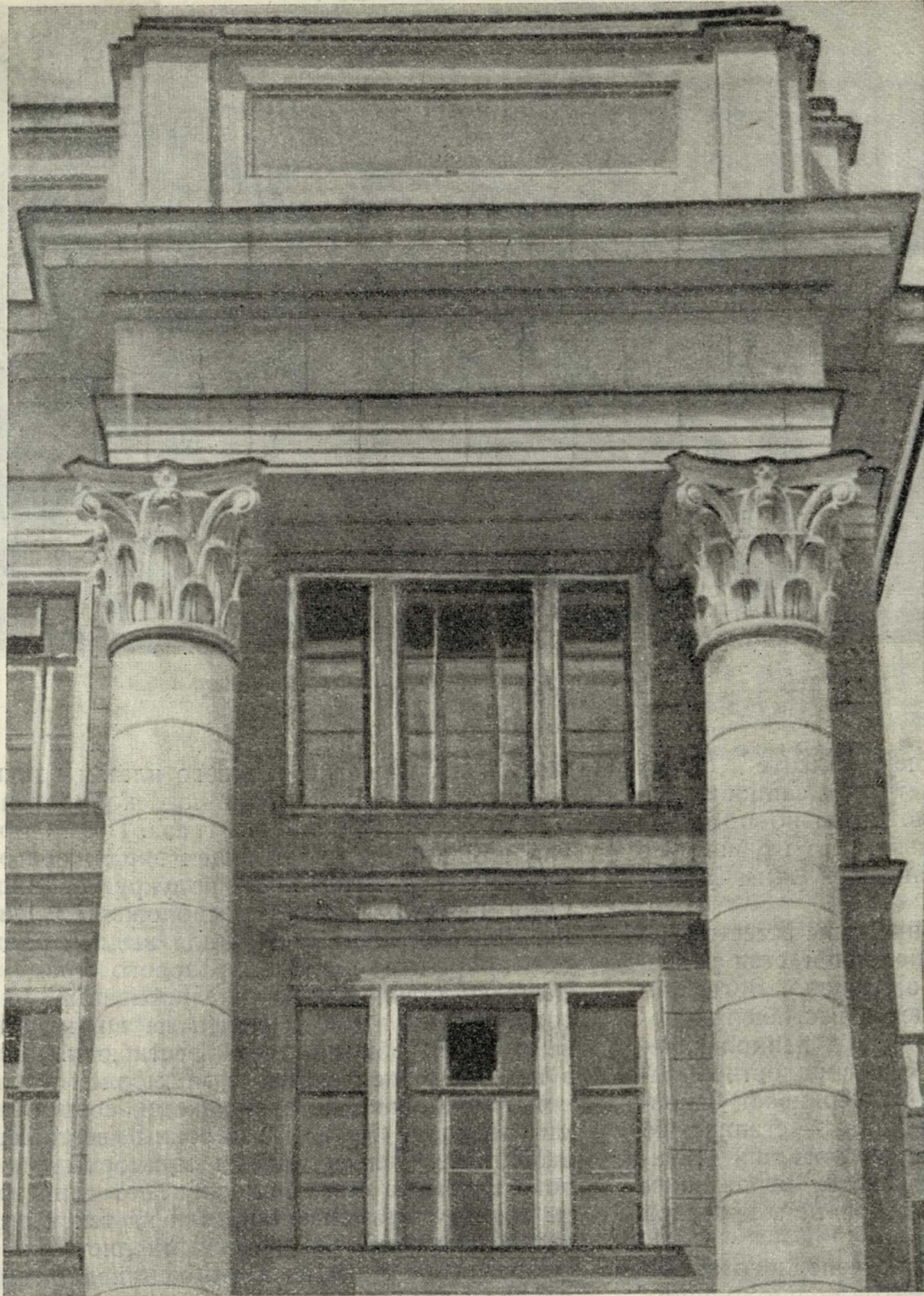
Фрагмент главного фасада.
