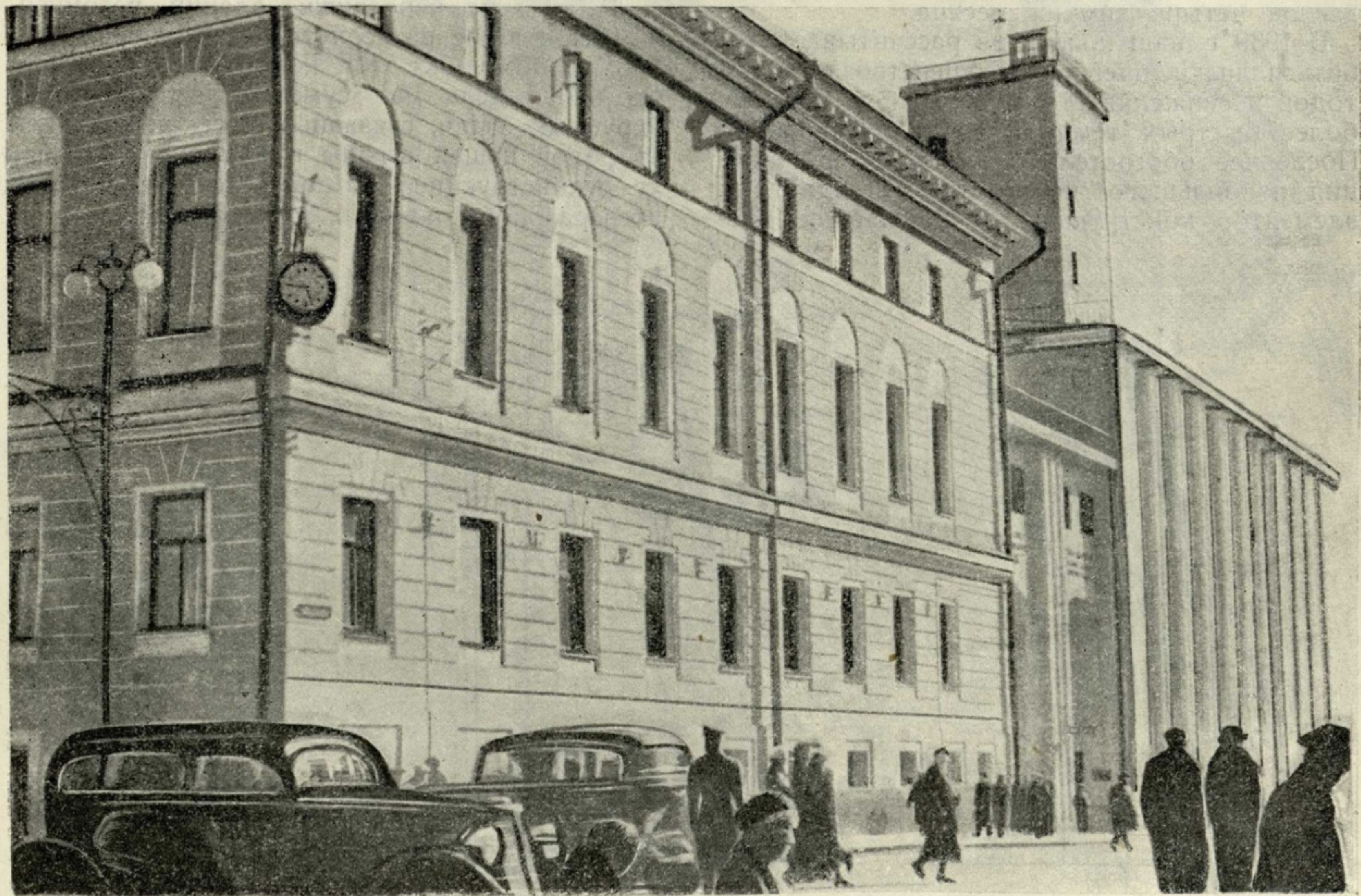
Рис. 10. К передвижке здания Моссовета. Справа—Новый корпус построенный по проекту акад. арх. И. А. Фомина. Слева — корпус, построенный в начале XIX в. арх. М. Ф. Казаковым. В середине — арка, соединяющая оба корпуса.
