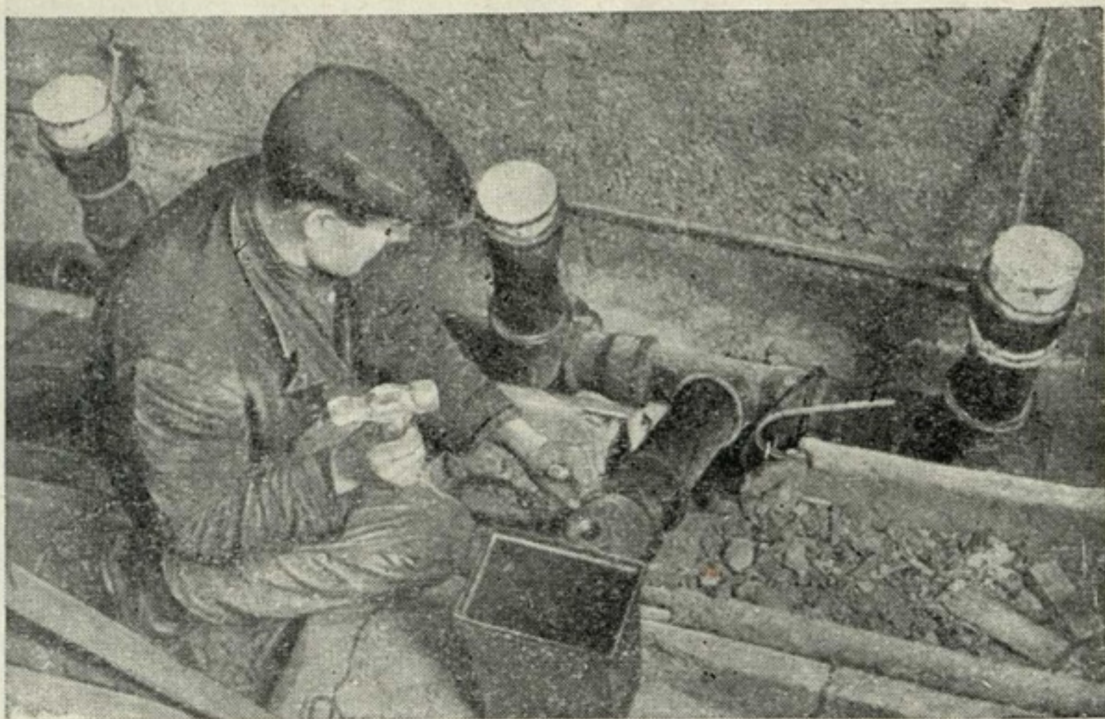
Рис. 7. 2-й день монтажа. Установка на перекрытии санузла канализационной «гребенки», заготовленной в ЦЗМ.
