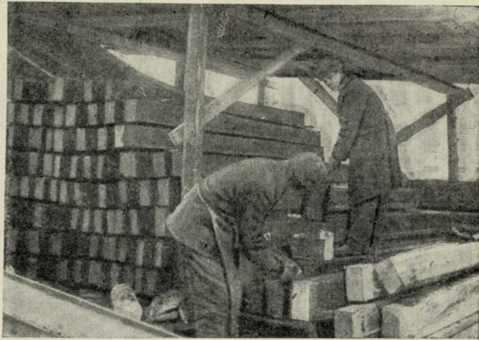
Рис. 7. Подготовка брус-балки. Антисептирование и обмотка концов толем.
