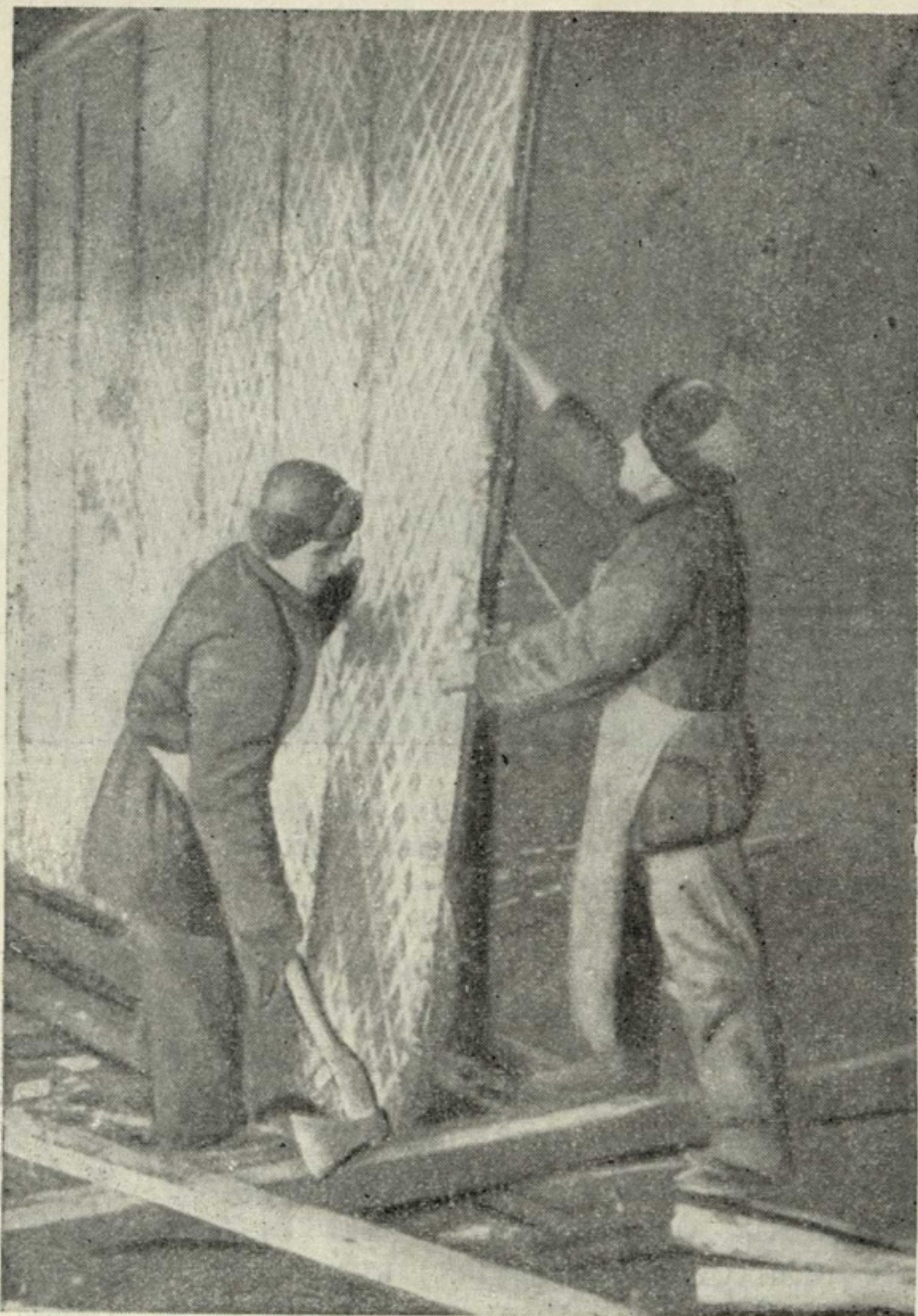
Рис. 4. Монтаж перегородок из щитов заводского производства.
