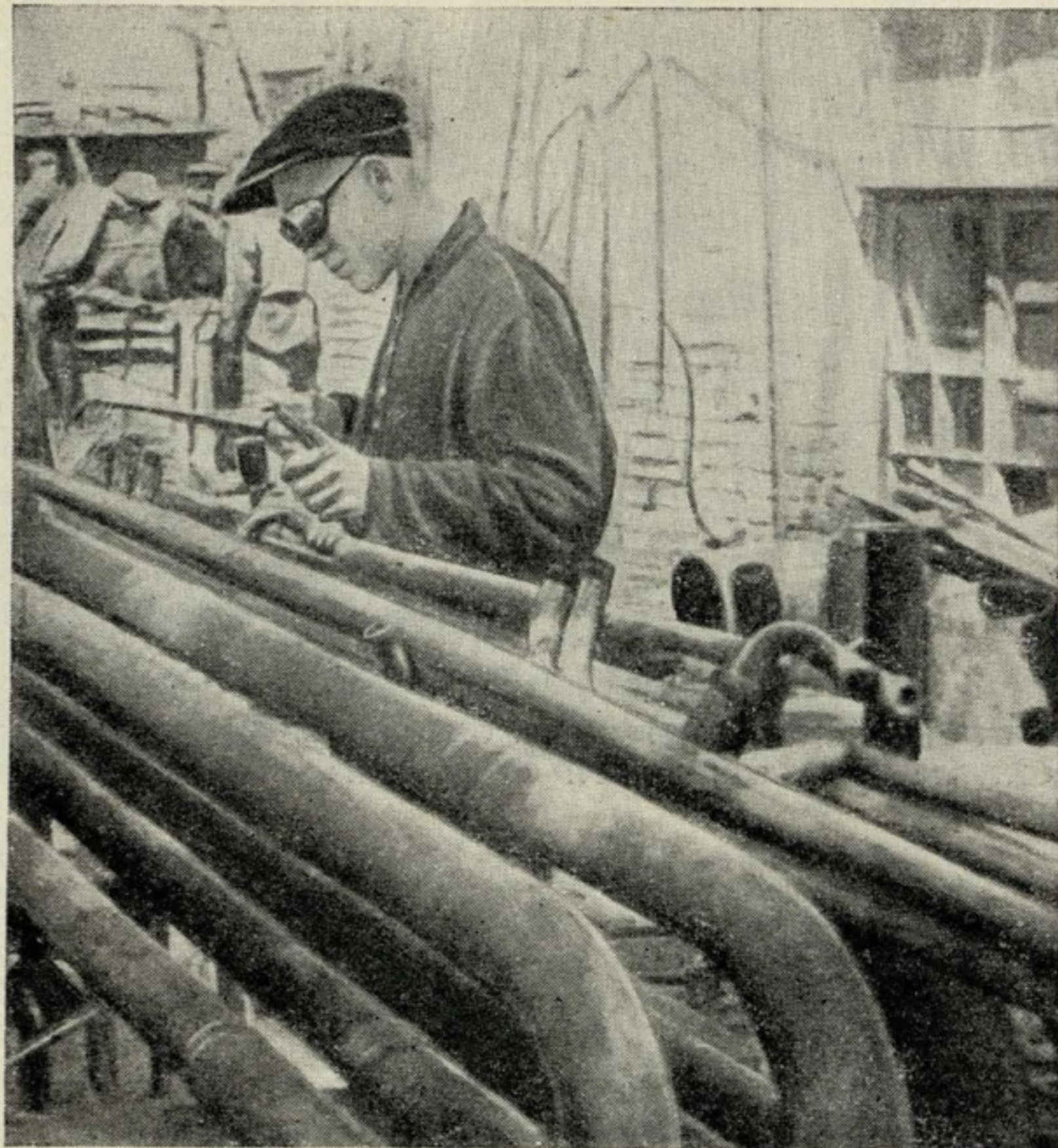
Рис. 5. Сварка стояков и трубопроводов для отопительных систем.
