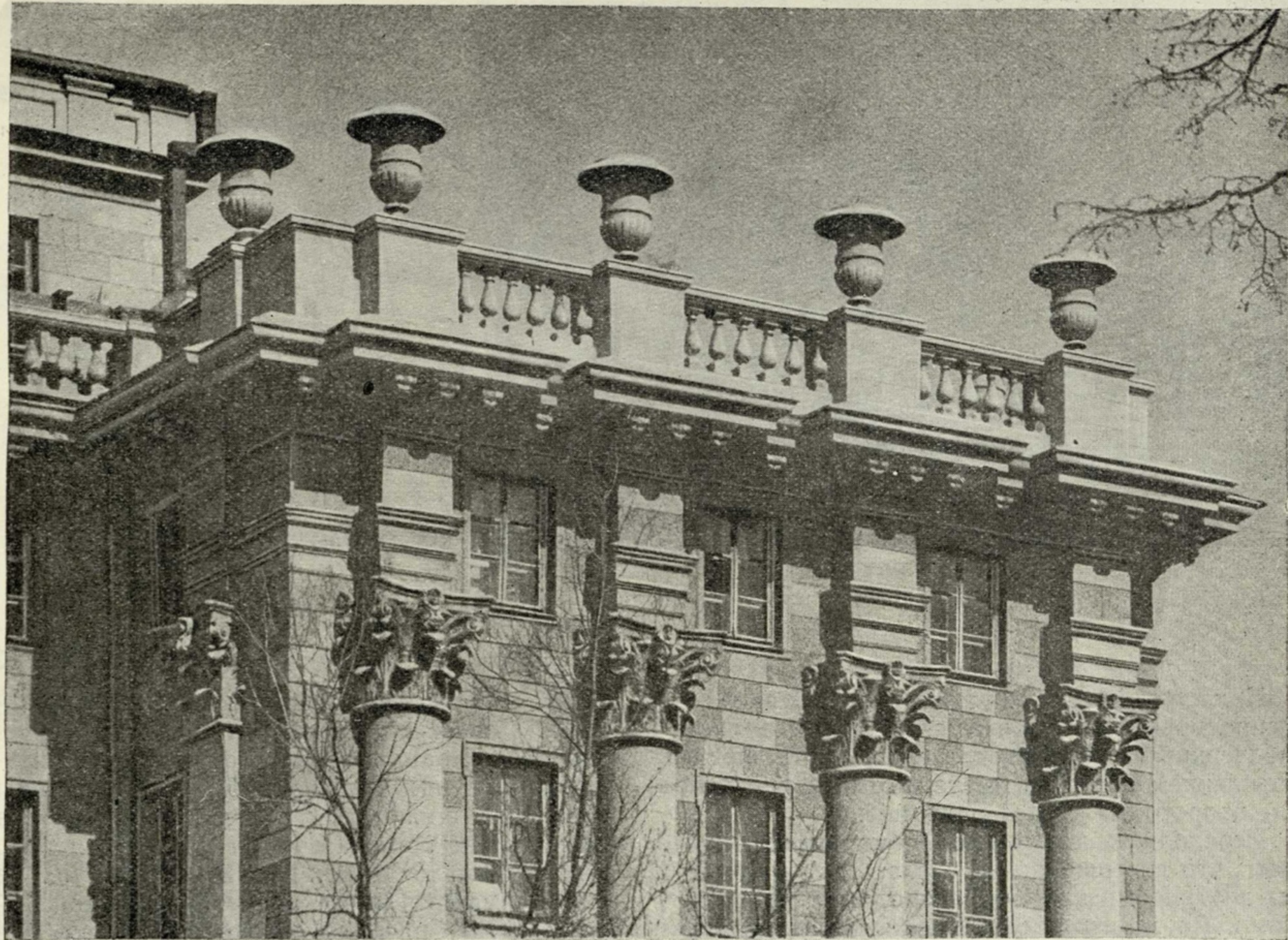
Фрагмент корпуса первой очереди.
