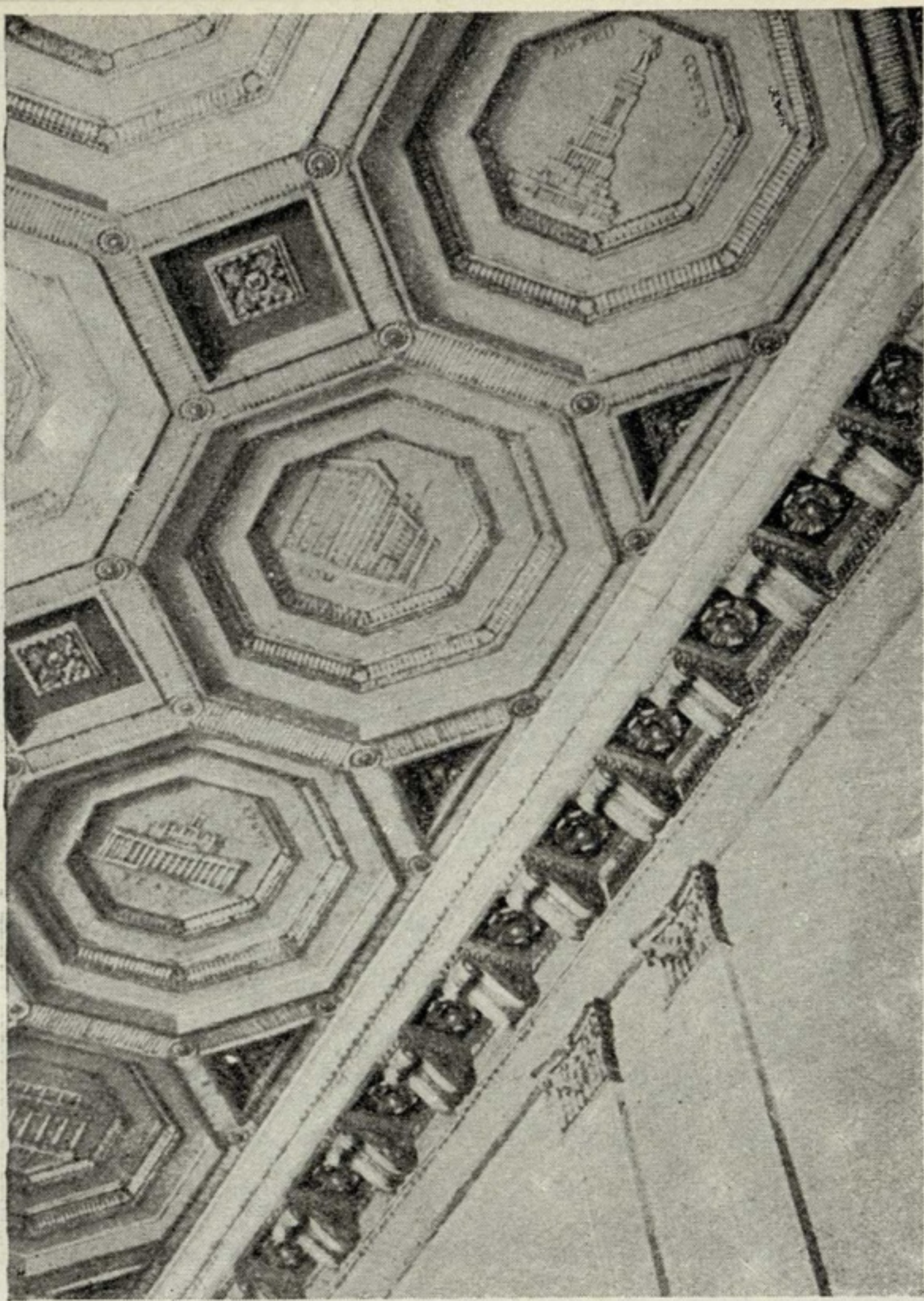
Деталь потолка и карниза банкетного зала 2-го этажа
