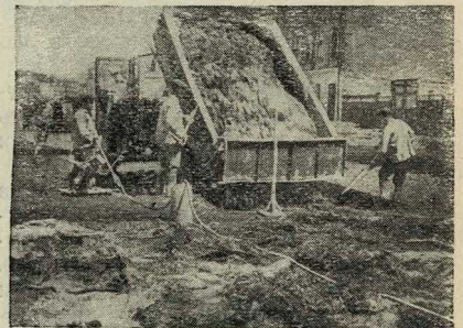
Рис. 8. Уплотнение бетона электровибратором
