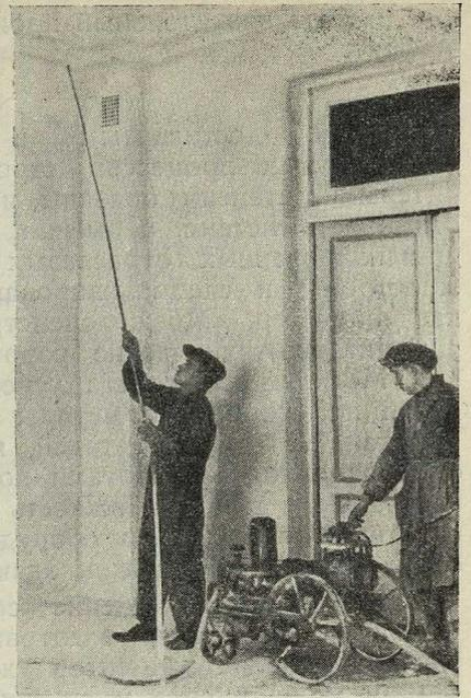
Слева направо: Рис. 12. Портативная затирочная ручная машина за работой. Рис. 13. Покрасочный аппарат „КУ-100“, применяемый в основном для окончательной клеевой окраски. Рис. 14. Побелка потолка механическим гидропультом системы „ЛИС“ (выпущен ленинградской промышленностью и приспособлен конторой отделочных работ „Мосжилстроя“)
