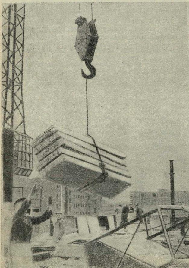
Рис. 5. Под'ем башенным краном „БКТС-1“ сборных конструкций
