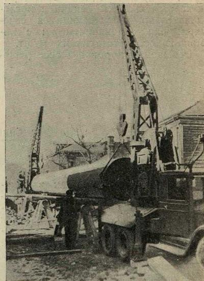
Поднятая кранами на высоту около 2 м, секция труб весом в 6 т была положена на наклонный настил и плавно опущена в канаву. Применение этих кранов значительно ускорило опускание в канаву секций труб, которое до этого производилось вручную при помощи блоков.
