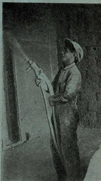
Нанесение грунта из сопла. Производительность 500 кв. м. в час.
