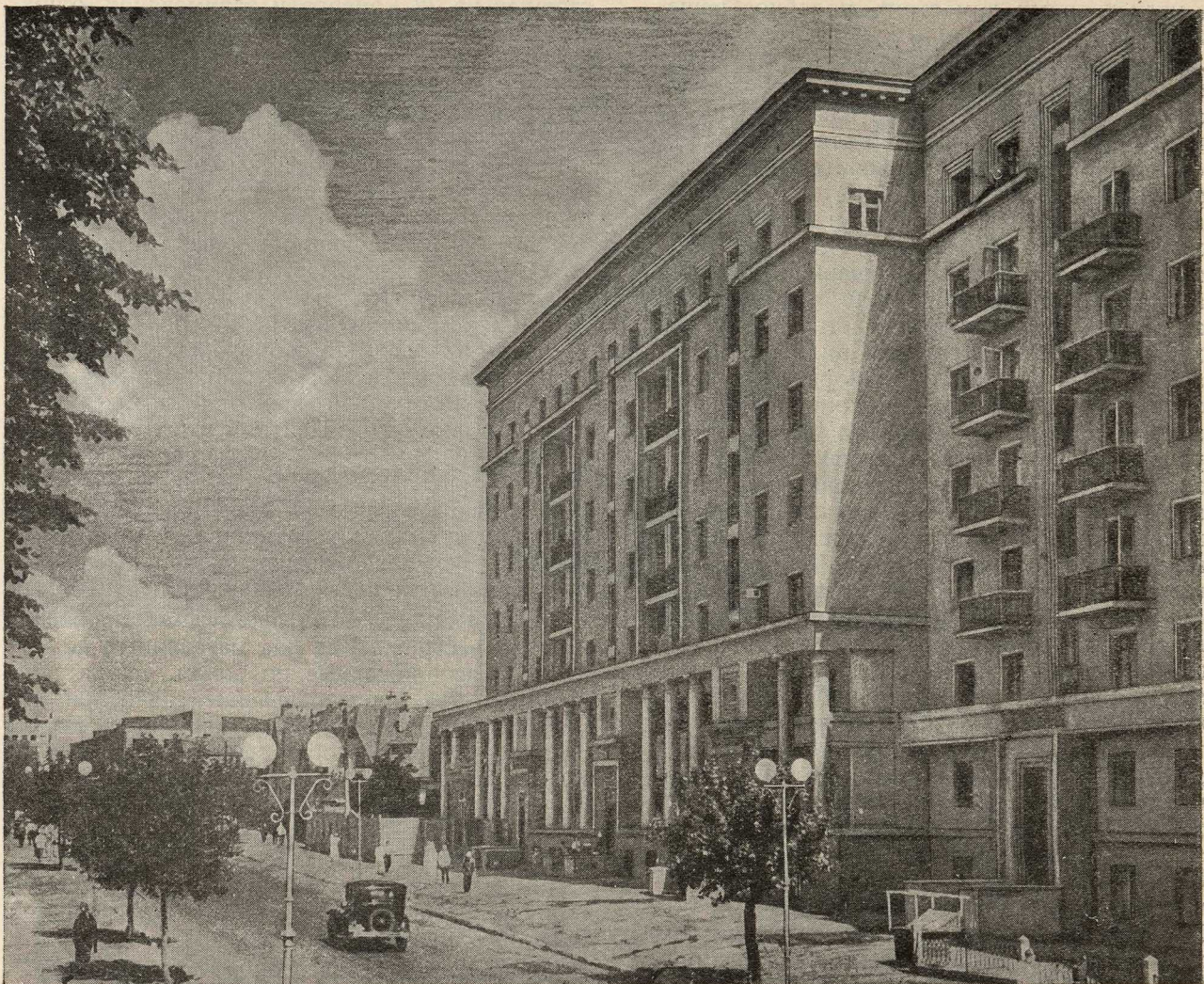
Жилой дом по ул. „Правды“. Выстроен по проекту арх. Н. Метлина
